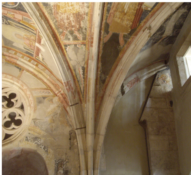
Il. 6. Ekspozycja faz przebudowy i kilku warstw dekoracji malarskiej pochodzących z różnych okresów w kaplicy w pałacu biskupim w Zagrzebiu (fot. E. Świąćka)
