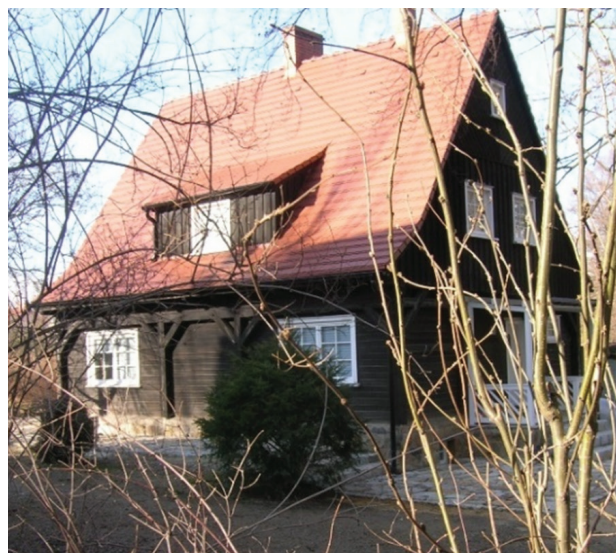
Il. 2. Budynek z konstrukcją przysłupową (dach oparty bezpośrednio na poziomej belce przysłupu) (fot. M. Piróg)
