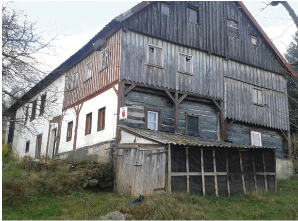
Il. 7. Termomodernizacja części ścian parteru wykonana od zewnątrz (fot. M. Piróg)
