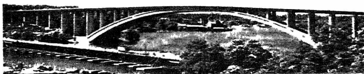
Ryc. 1. Widok ogólny mostu.
