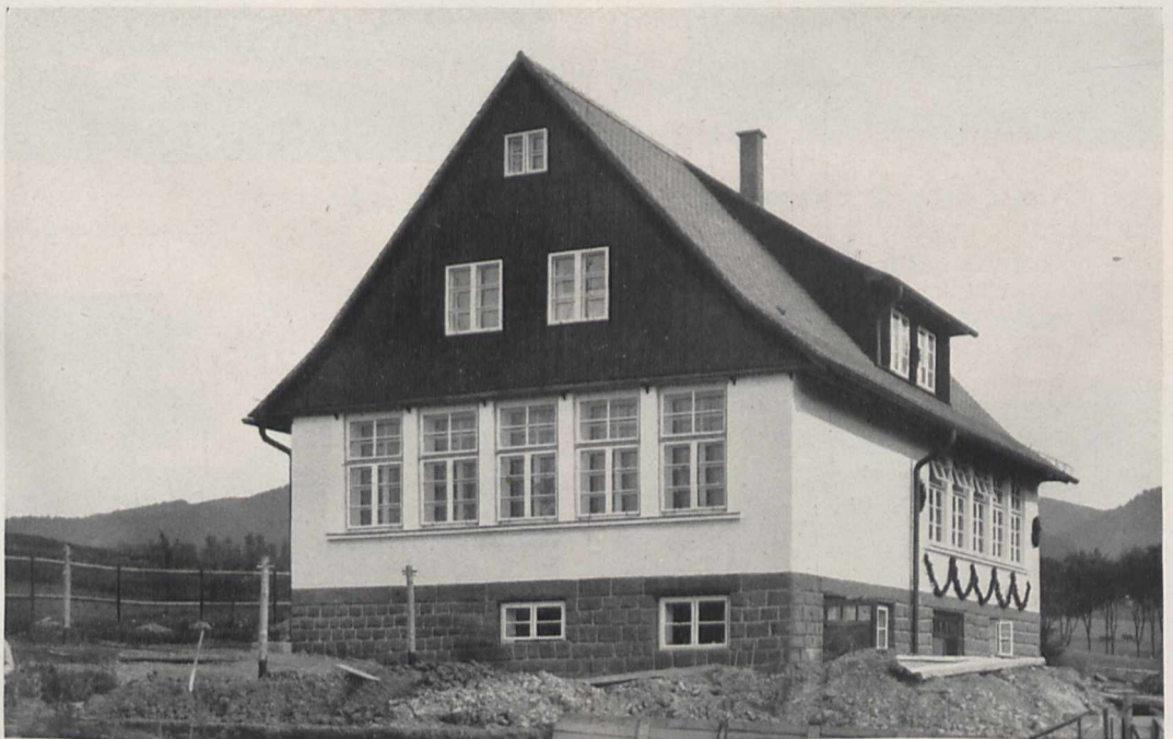
Neue Schule in Köpprich
