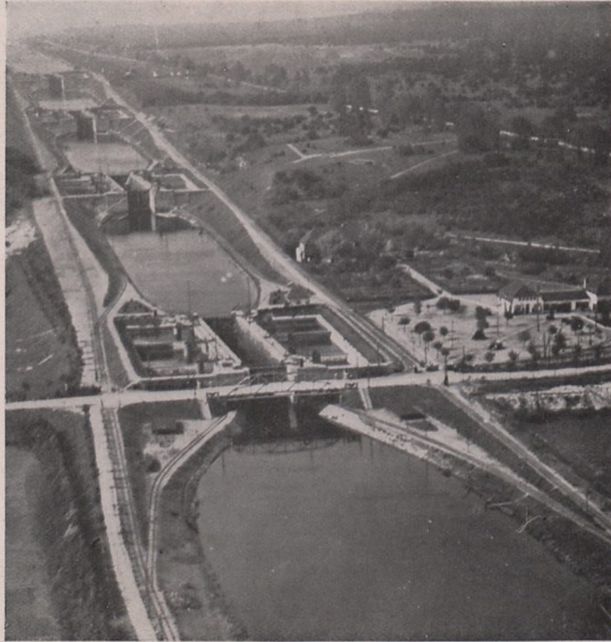
Abb. 234. Treppenschleuse bei Liepe im Großschiffahrtsweg Berlin—Stettin
