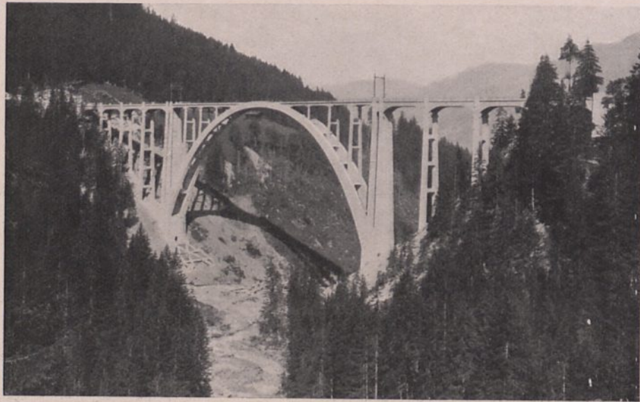
Abb. 191. Langwieser Viadukt, Linie Chur—Arosa, Ed. Zublin & Co., Straßburg im Elsaß
