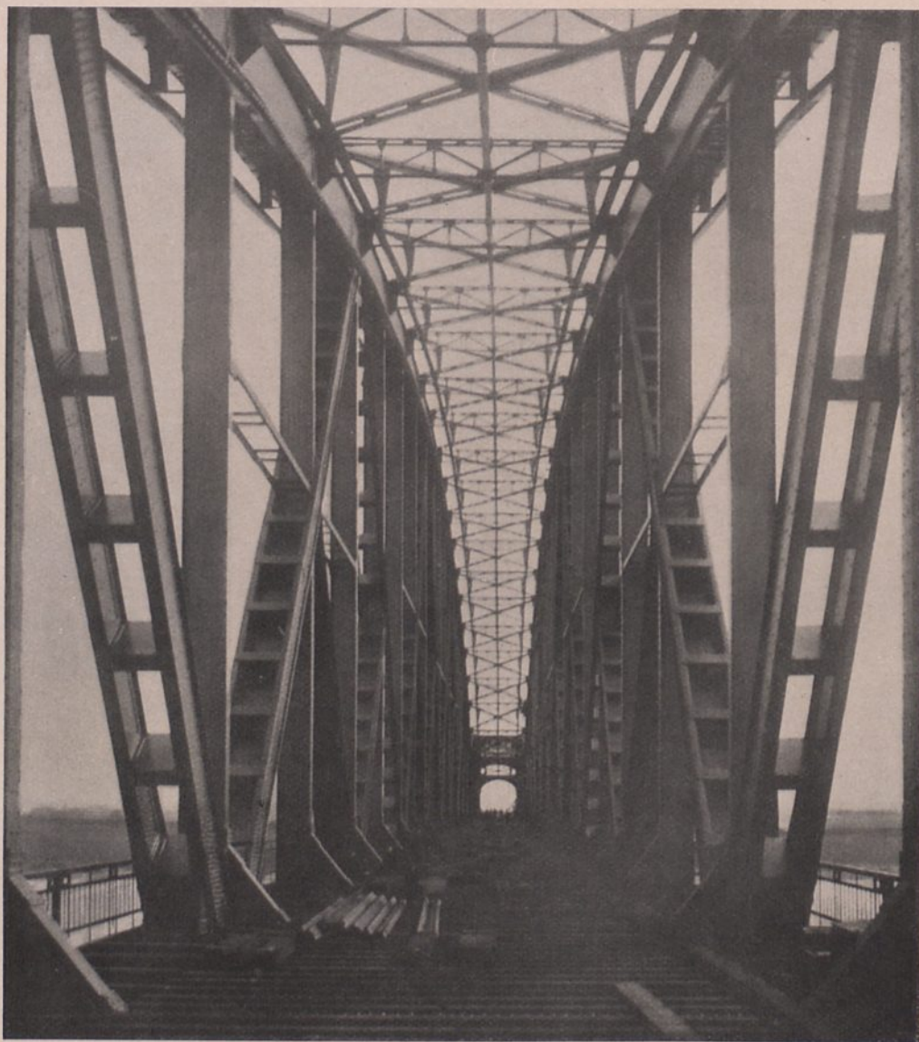
Abb. 194. Eisenbahnbrücke über den Rhein unterhalb Duisburg-Ruhrort, Hein, Lehmann & Co. A.-G., Düsseldorf-Oberbilk
