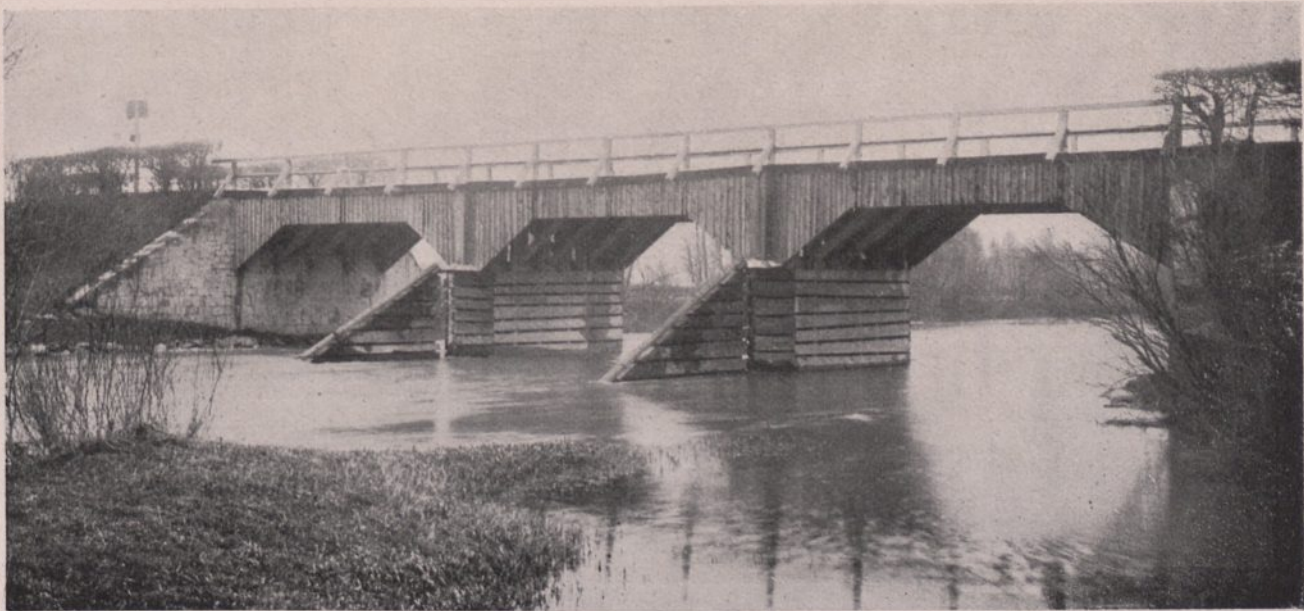
Abb. 167. Straßenbrücke über die Wertach im Allgäu bei Bießenhofen
