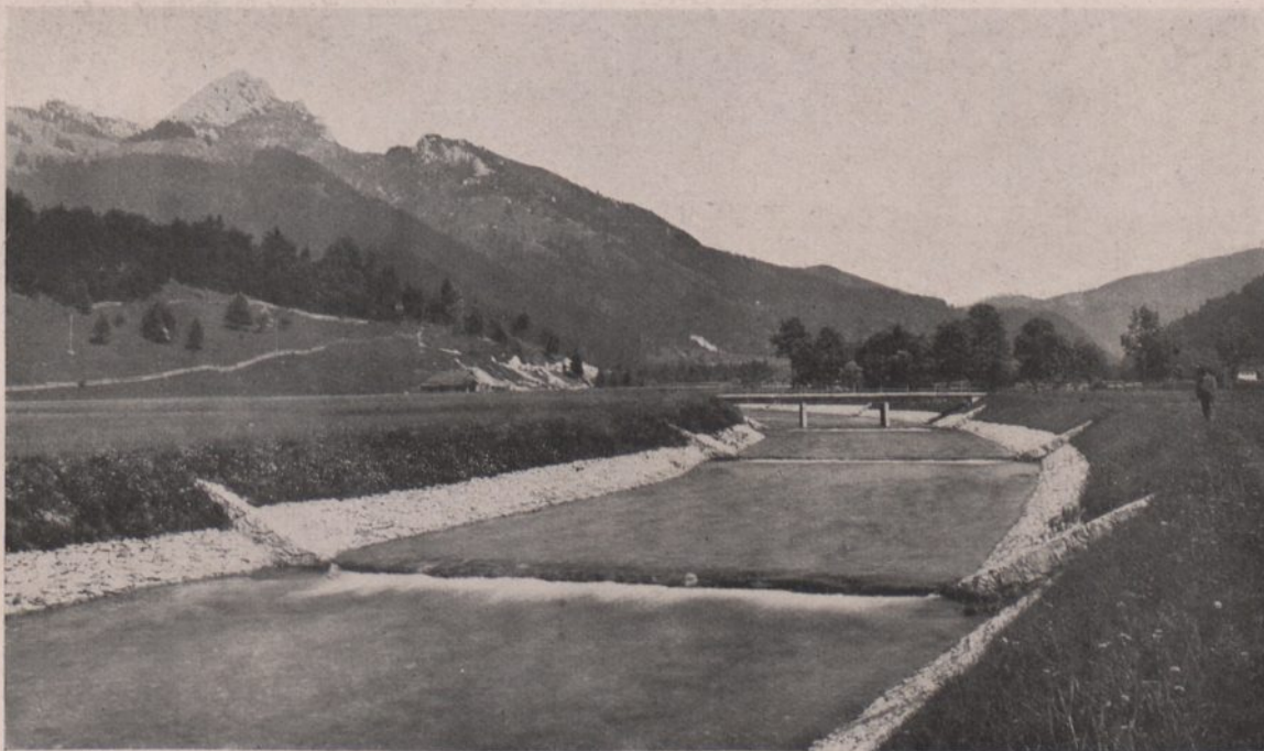
Abb. 233. Korrektion der Leizach bei Geitau, Oberbayern
