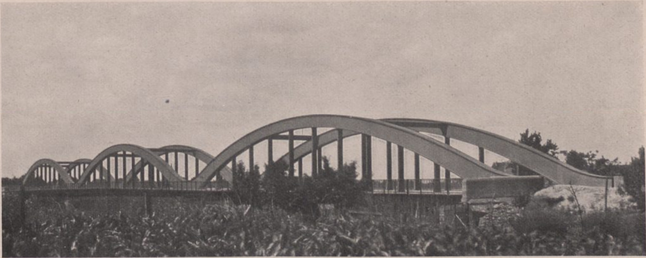
Abb. 202. Ringstraßenbrücke in Heidelberg, Eisenwerk Grötzingen in Baden
