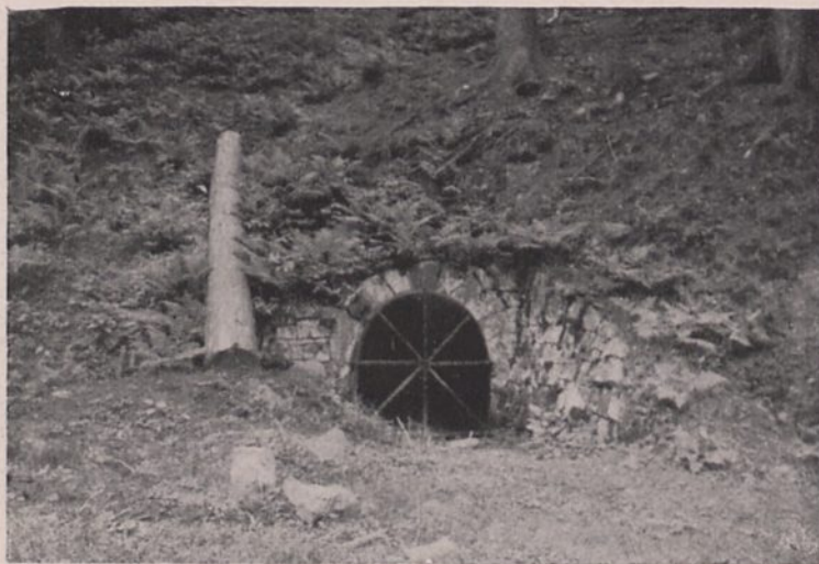
Abb. 145. Stollenmundloch bei Grund im Harz
