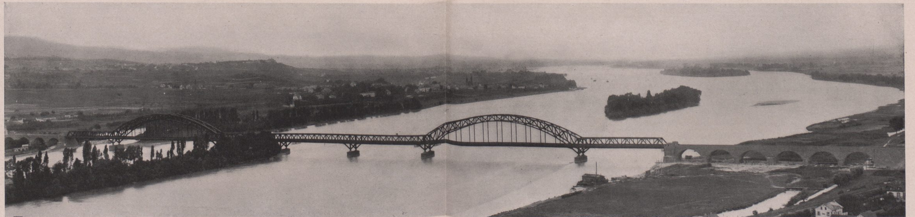
Abb. 199. Eisenbahnbrücke über den Rhein bei Rudesheim, MAN
