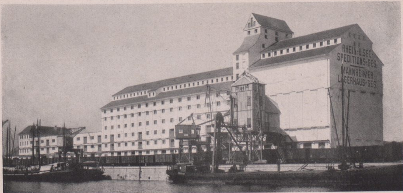
Abb. 101. Silo am Rheinhafen in Straßburg im Elsaß, Aktien-Gesellschaft für Beton- u. Monierbau, Architekt Beblo, München
