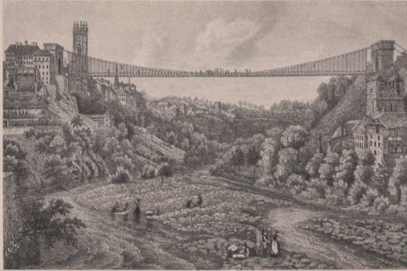
Abb. 205. Hängebrücke Freiburg in der Schweiz
