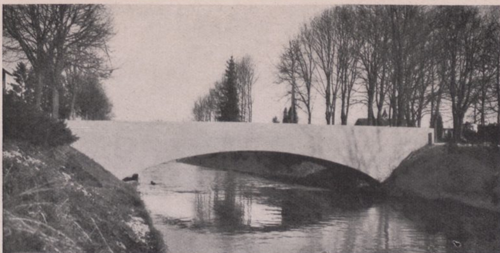
Abb. 187. Werkkanalbrücke Kolbermoor, Wayss & Freytag
