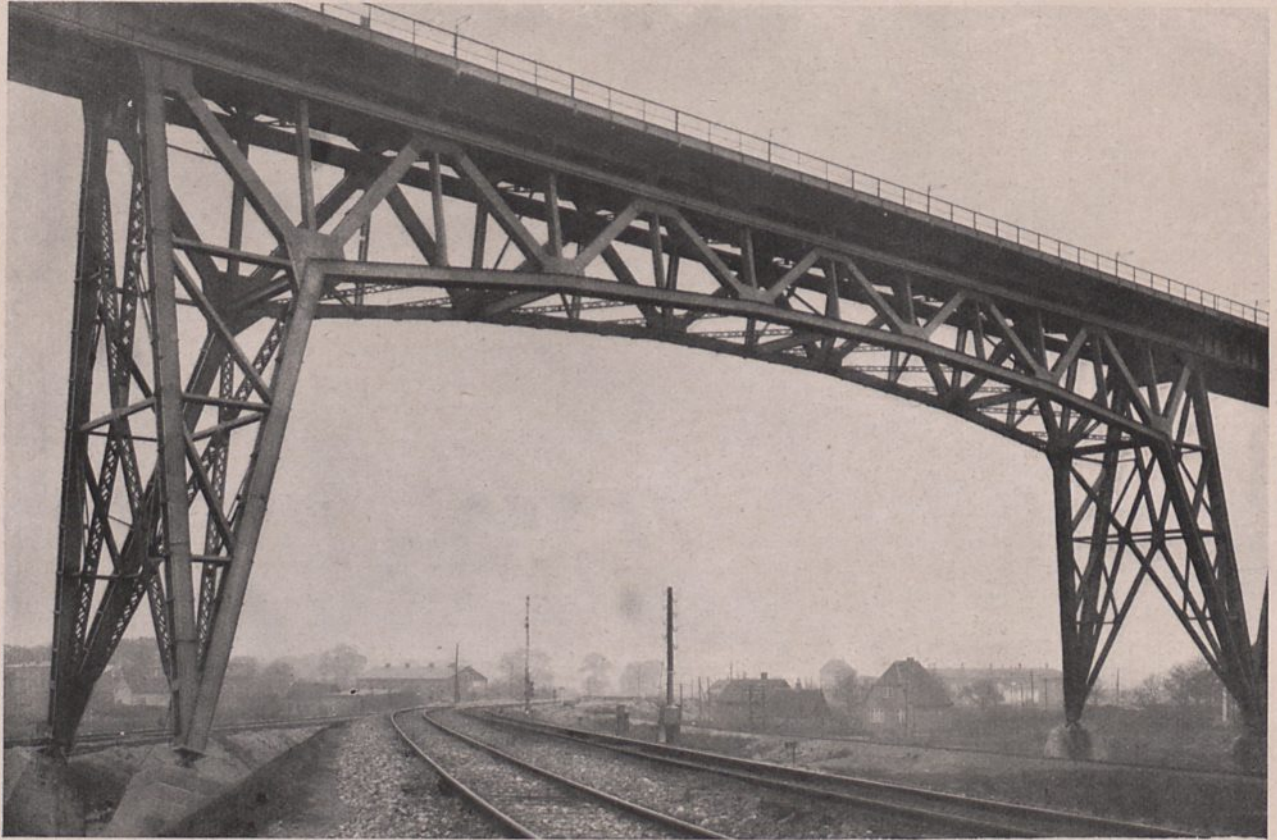
Abb. 196. Hochbrücke Rendsburg, Gleisüberbrückung am Schleifenpunkt der nördlichen Rampenbrücke
