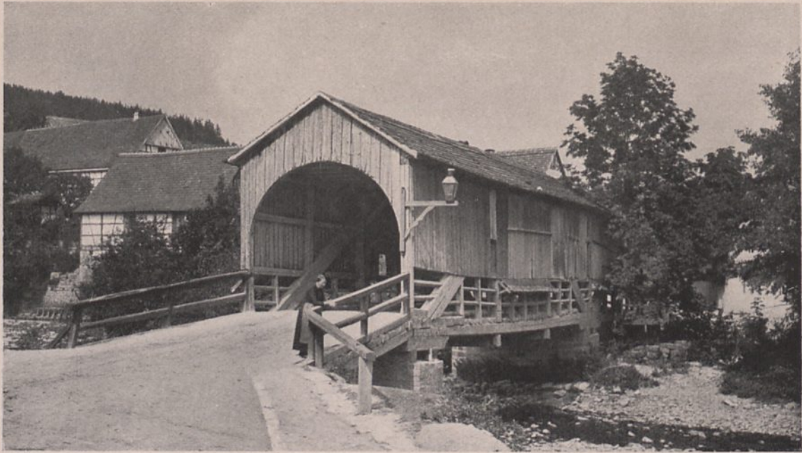
Abb. 169. Ilmbrücke in Buchfahrt bei Weimar
