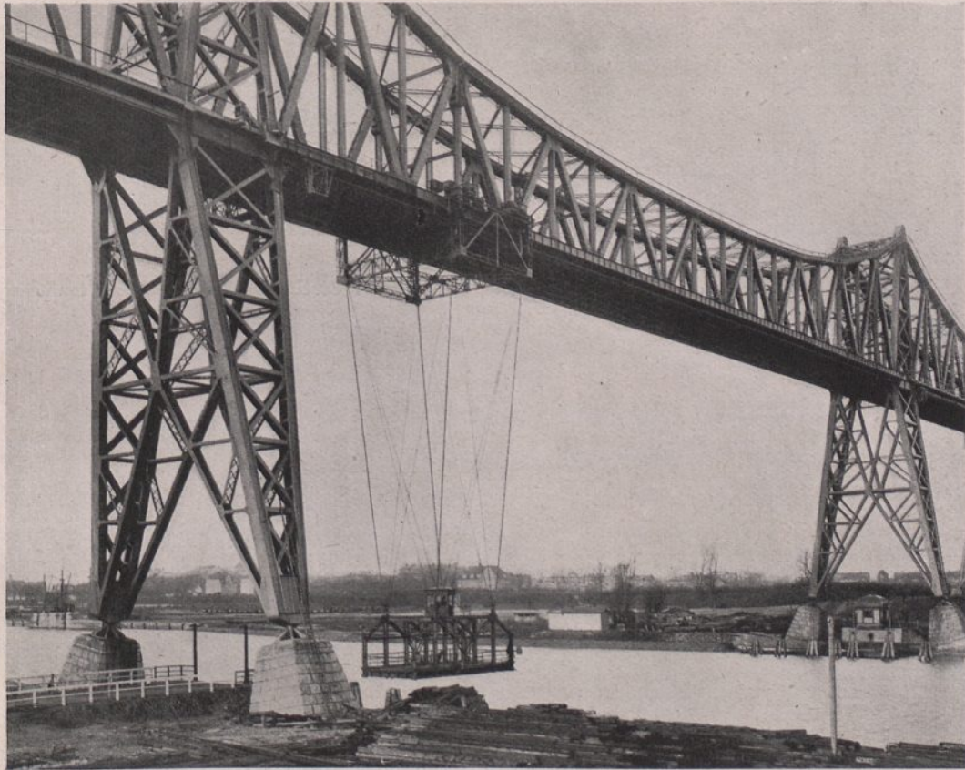
Abb. 197. Hochbrücke Rendsburg, Mittelöffnung mit Schwebefähre
