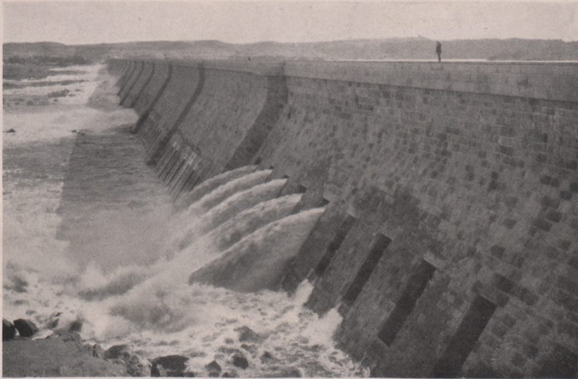
Abb. 236. Staudamm Assuan, Nordseite
