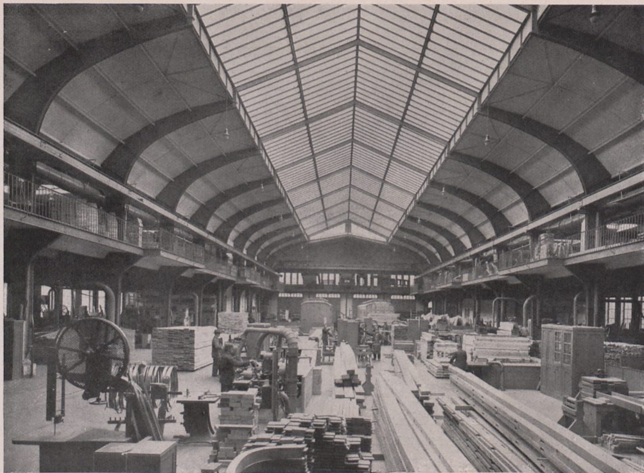
Abb. 121. Hannoversche Waggonfabrik, Architekt P. Behrens, Neubabelsberg
