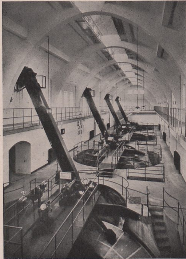
Abb. 130. Inneres des Hauptreinigungsgebäudes
