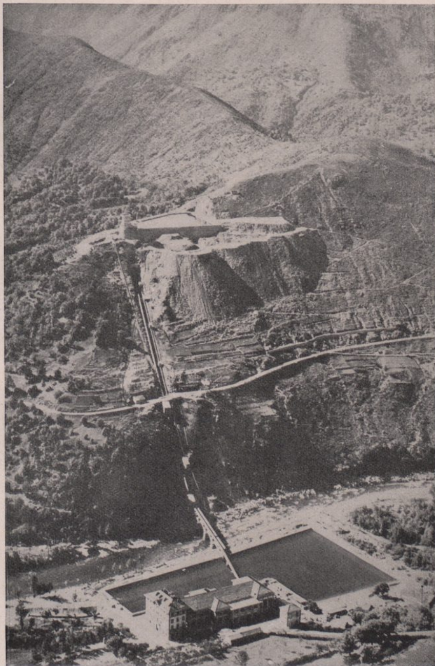
Abb. 222. Wasserkraftanlage Funghera, Gebr. Sulzer, Winterthur
