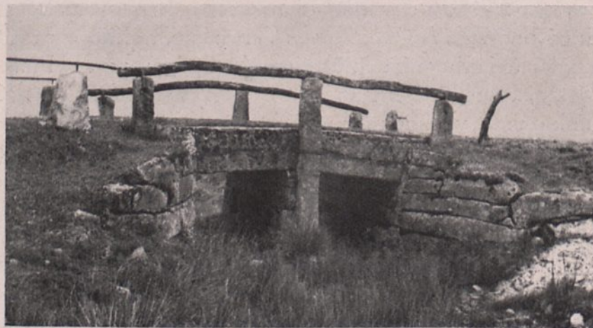
Abb. 166. Brücke von 1787 über die Süderau bei Tondern
