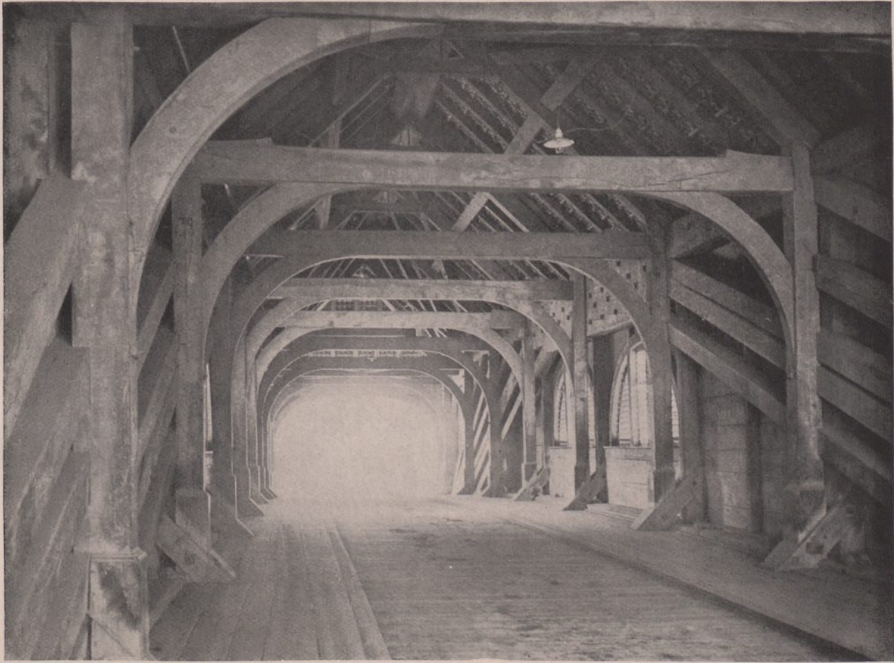
Abb. 171. Inneres einer gedeckten Holzbrücke in Baden
