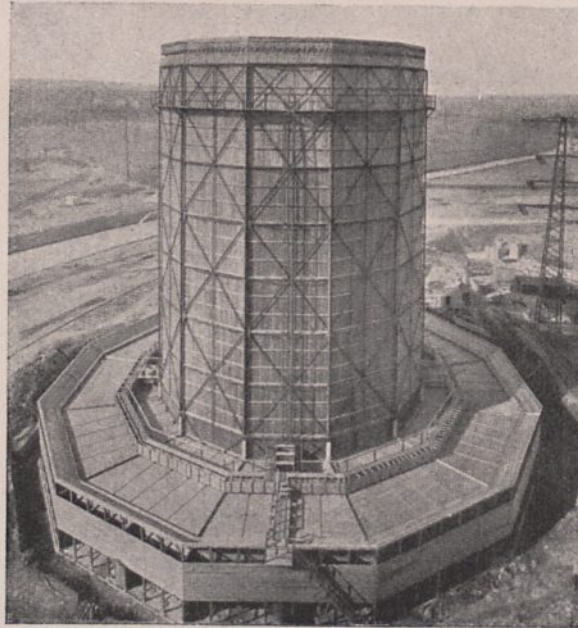
Abb. 83. Kühlturm Kraftwerk Hirschfelde bei Dresden, Maschinenbau-A.-G. Balcke, Bochum in Westfalen
