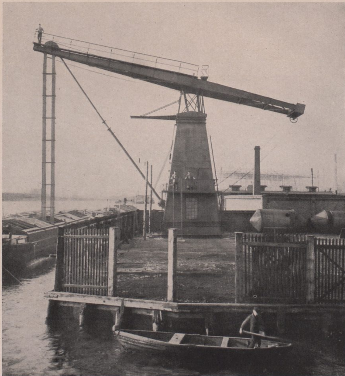
Abb. 215. Schiffsgetreideheber im Stettiner Hafen, Mühlenbauanstalt und Maschinenfabrik vorm. Gebr. Seck, Dresden
