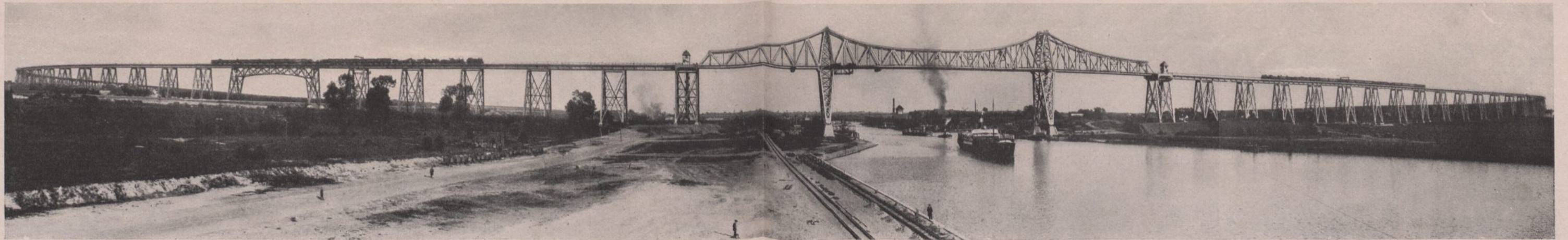
Abb. 198. Eisenbahnhochbrücke Rendsburg; Kanalbrücke erbaut von der Gutehoffnungshütte, Oberhausen, Rampenbrücken von C. H. Jucho, Dortmund
