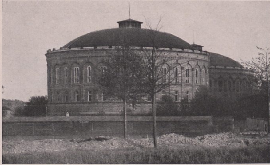
Abb. 68. Alter Gasbehälter in Reick bei Dresden
