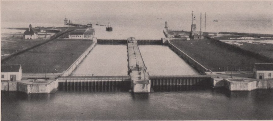
Abb. 239. Werft Wilhelmshaven, Schleuse, erbaut von den Vereinigten Oldenburger Klinkerwerken, Bockhorn in Oldenburg
