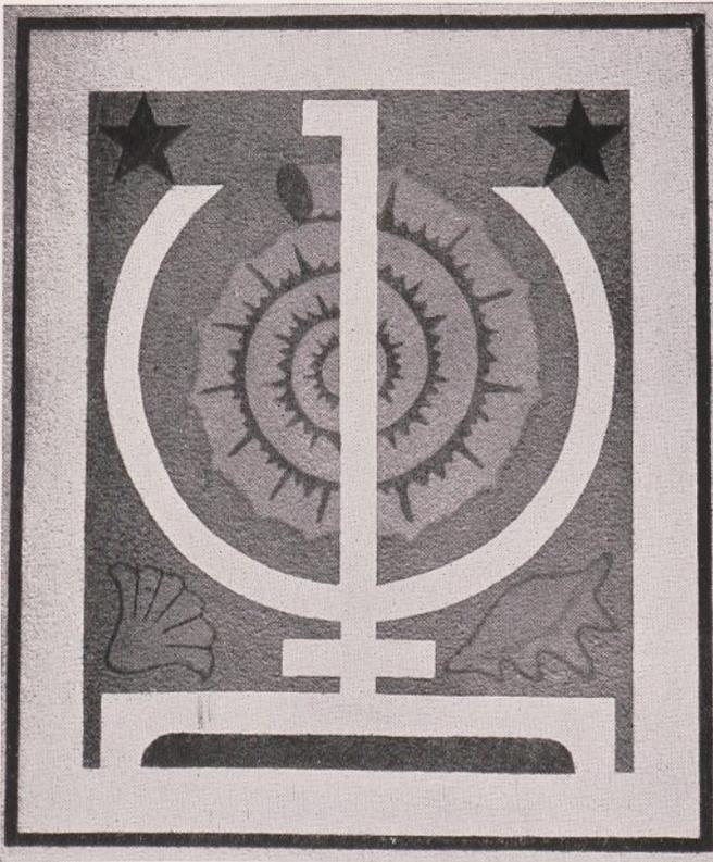
Abb. 14. Putzintarsie, Einlegearbeit aus verschieden gefärbten Putzmörteln (Schularbeit)
