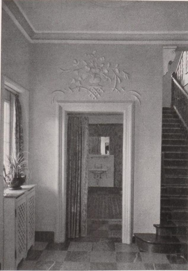
Abb. 40. Eckgesims und Antragarbeit über der Türe in einer Vorhalle. (Arch. Schlösser & Weirether, Stuttgart)
