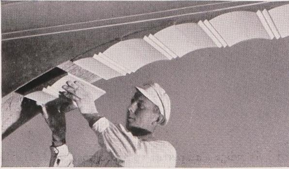
Abb. 52. Die Gesimsstücke werden einzeln am Bogen angesetzt
