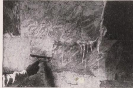
Abb. 22. Schneiden des angetragenen Stuckmarmors
