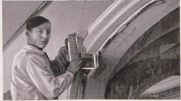
Abb. 53. Anschlag für den freihändigen Gesimszug an einer Korbbogenleibung
