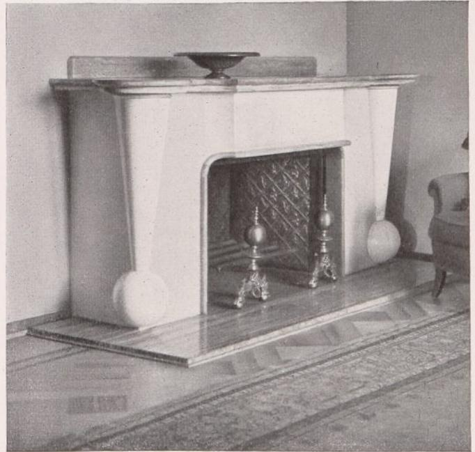
Abb. 17. Kamin, in weißem Zement ausgeführt. Bodenplatte und Abdeckplatte bestehen aus Travertin. Sämtliche sichtbaren Flächen sind poliert (Arch. Franz Nöcker, Köln).
