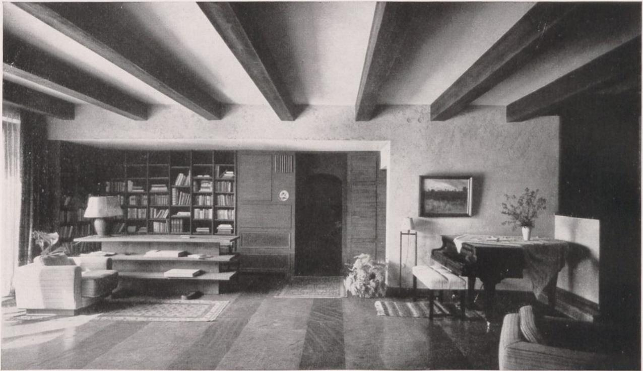
Abb. 2. Aus einem Wohnhaus in Altona (Arch. Bensel, Kamps & Amsinck, Hamburg). Wand in Kalkmörtel rauh geputzt, Deckenfelder glatt gescheibt. Der helle Putz steht hier in guter Verbindung mit dem dunklen Holzwerk
