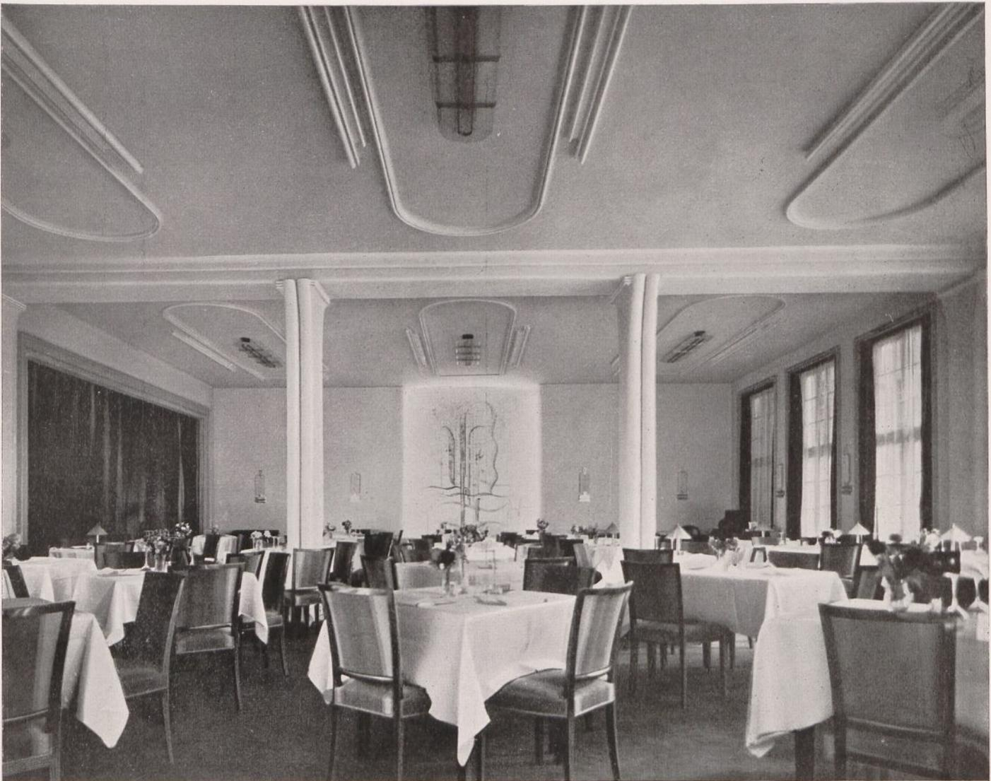
Abb. 32. Stuckdecke (Zugarbeit) im Speisesaal des Palast-Hotel Breidenbacher Hof (Arch. E. Fahrenkamp, Düsseldorf)
