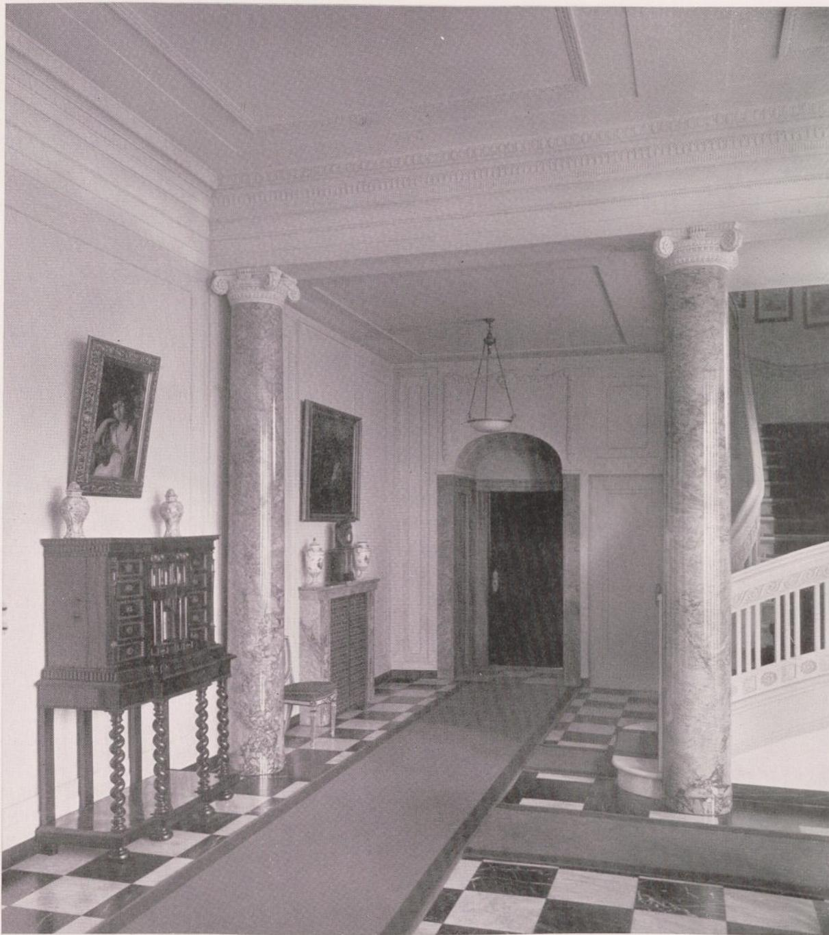
Abb. 80. Stuckdecke und Wandstuck (Zugarbeit) in der Treppenhalle eines Wohnhauses (Arch. Albert Eitel †)
