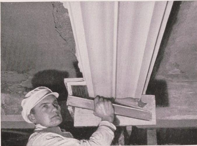
Abb. 30. Gesimszug am freihängenden Unterzug mit der Hochdruckschablone
