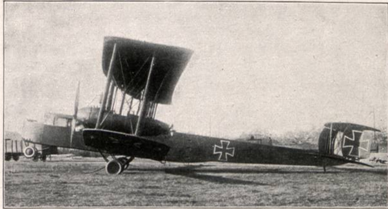
Abbild. 14. Staaken-R.-Flugzeug mit 3 Rumpfen, Haupttrumpf ohne Motore.
