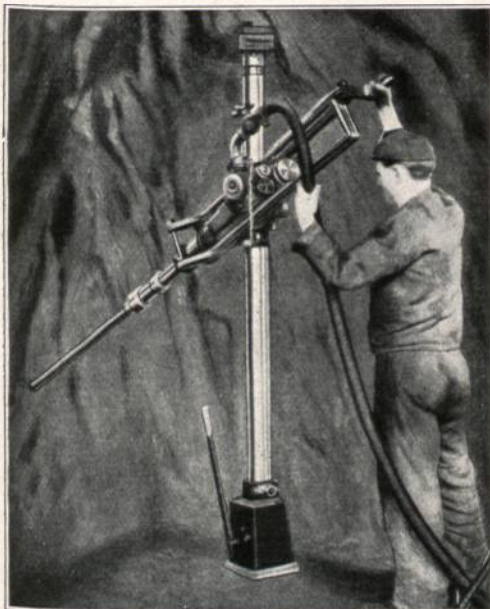
Abbildung 25. Druckluft-Stoßbohrmaschine.
