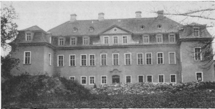
Schloß Stubendorf / Bauausführung 1925
