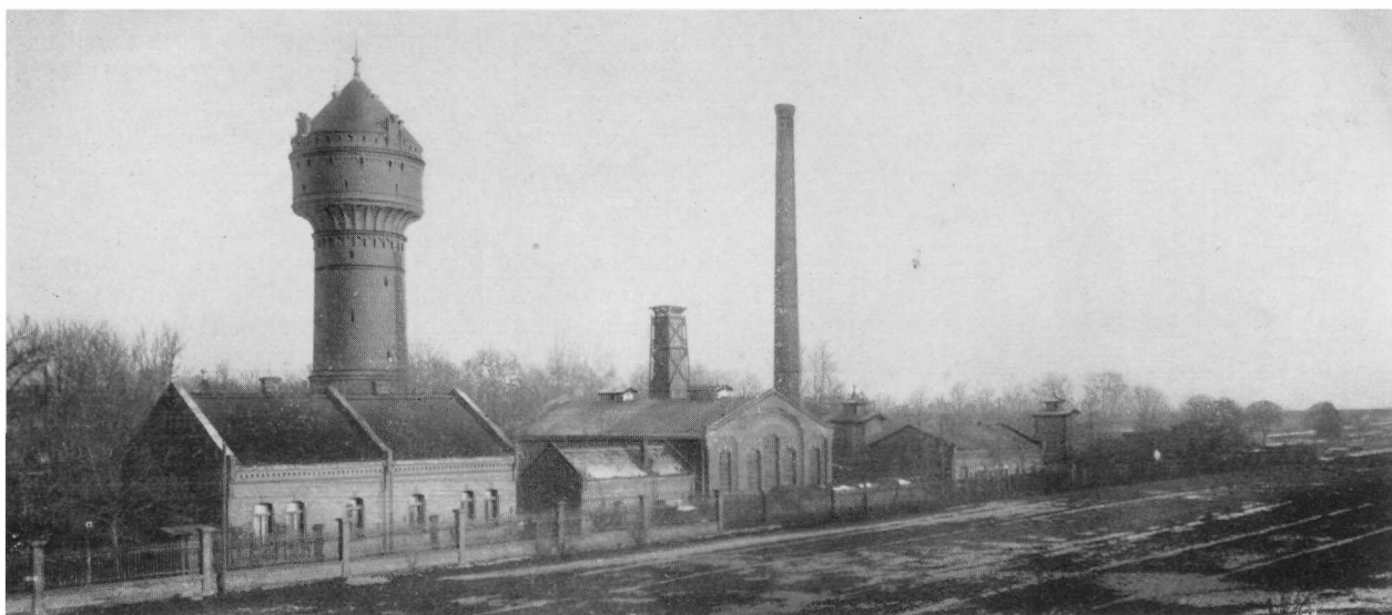
Gesamtansicht des Städt. Wasserwerkes, von der Stadt aus gesehen
