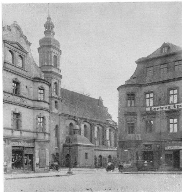
Evang. Pfarrkirche und südwestliche Ringecke
