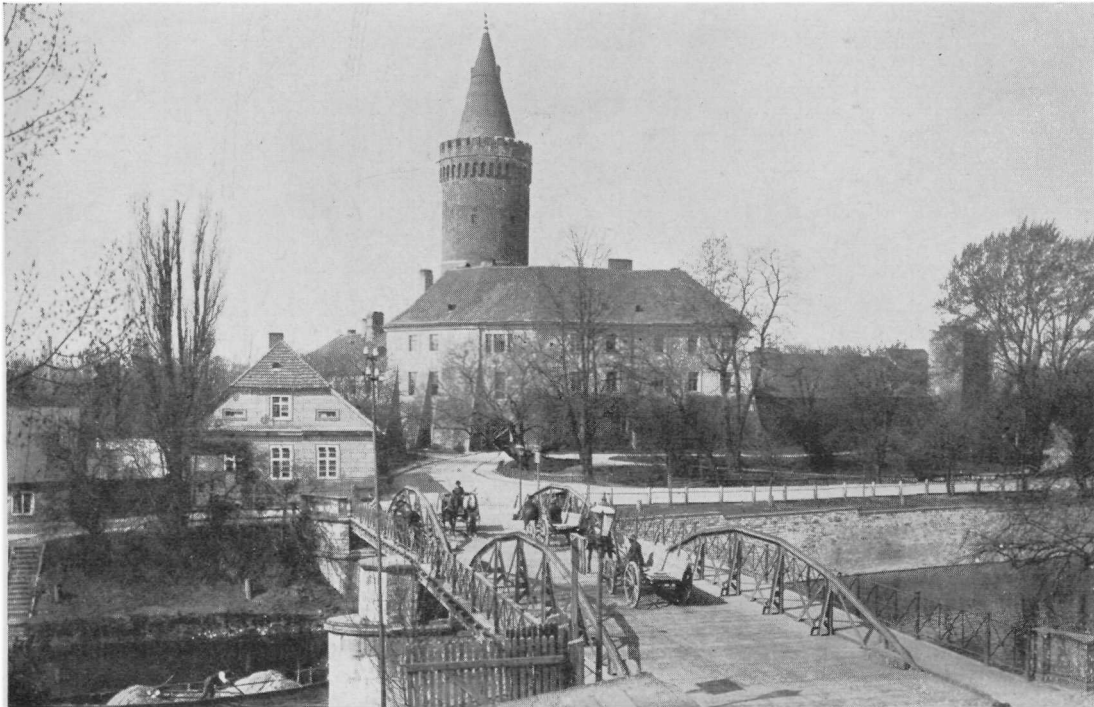
Ehemaliges Piastenschloß vor dem Umbau
