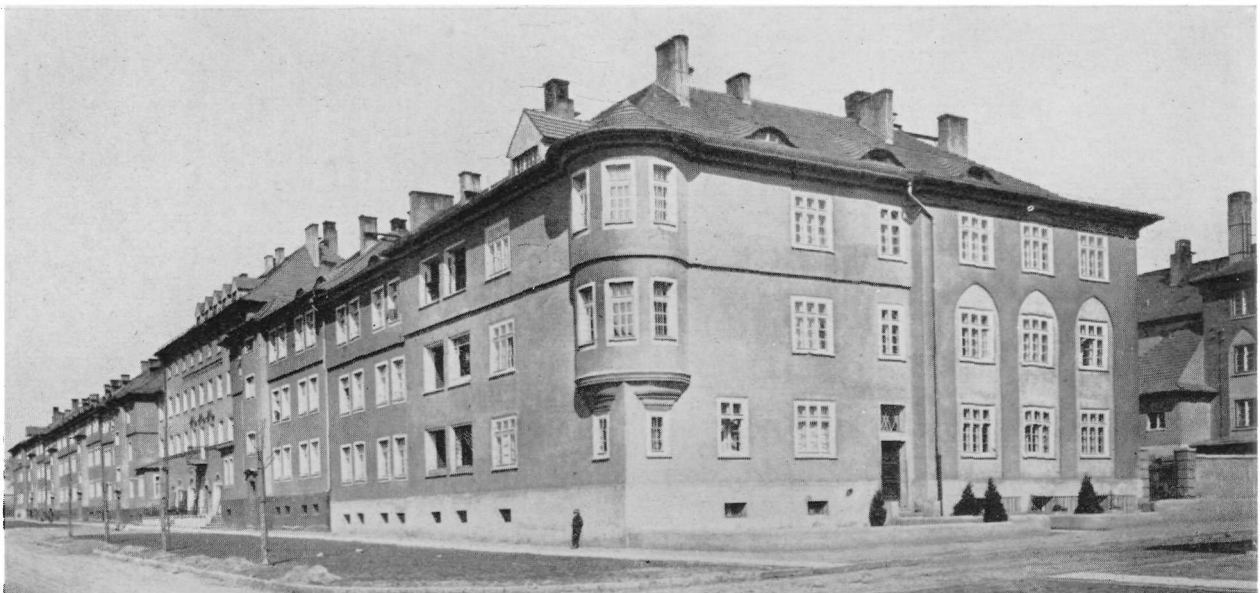
Wohnhäuser der Reichsbahndirektion
