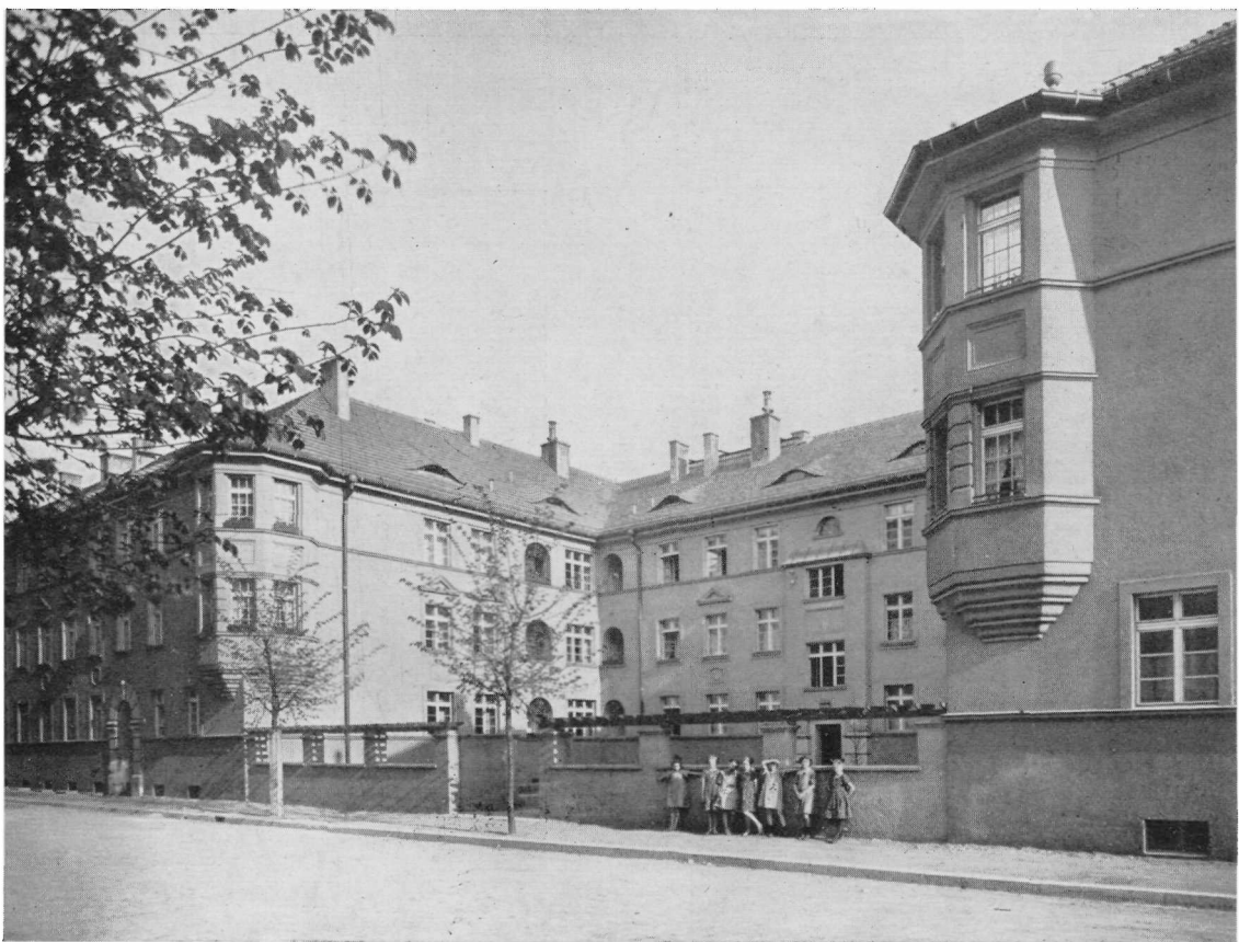
Wohnhausgruppe der Reichsbahndirektion an der Moltkestraße
