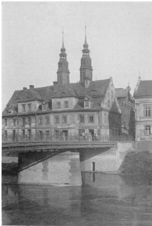
Mühlgrabenbrücke mit alten Häusern
