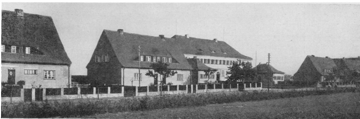
Kreisständehaus und Beamtenwohnungen in Guttentag
