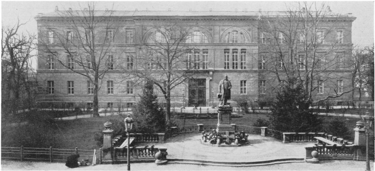
Regierungsgebäude (Oberpräsidium und Regierung)
