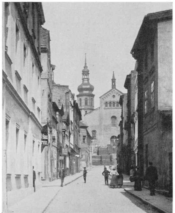
Adalbertstr. u. Kirche (sog. Bergelkirche)
