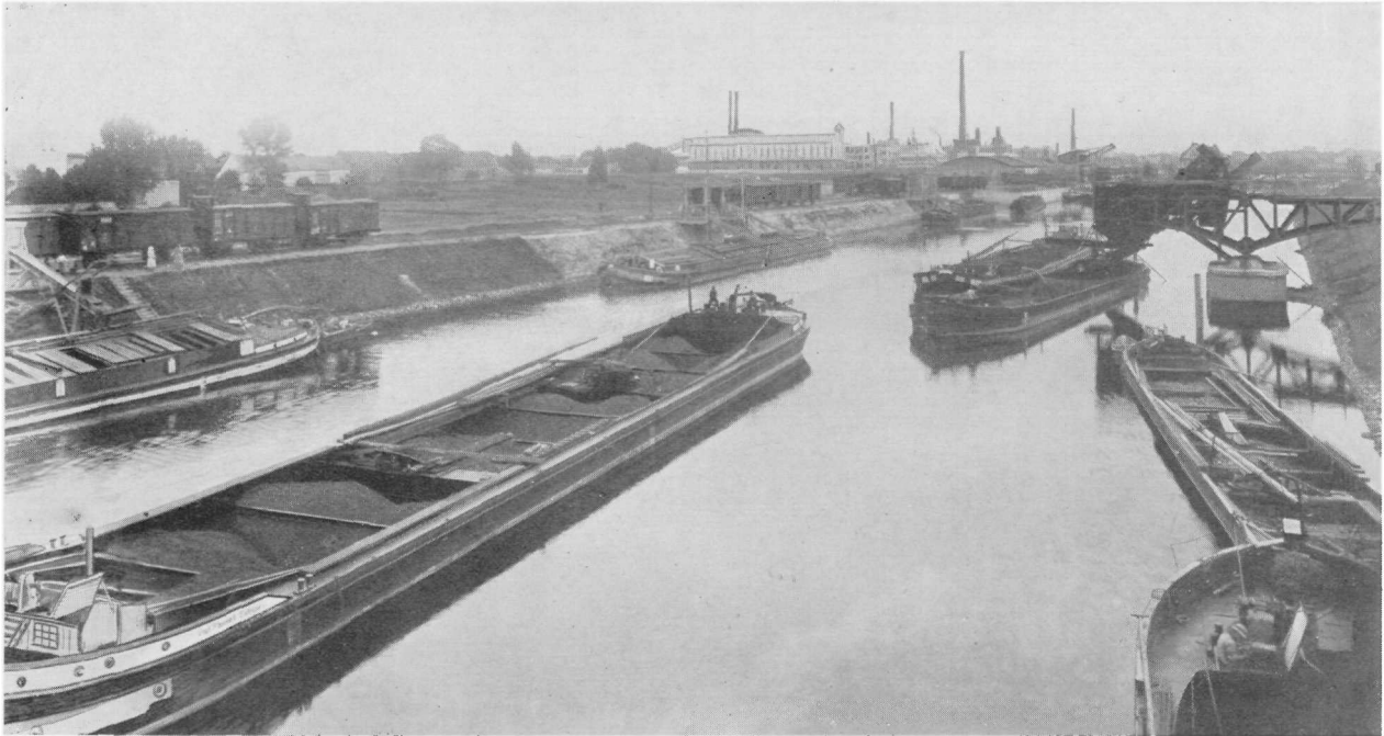
Gesamtansicht des Opperlner Hafens
