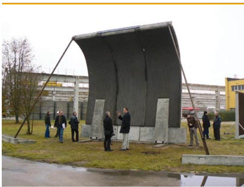
Odcinek ekranów próbnie zmontowany w Zakładzie Produkcji Prefabrykatów w Gralewie
