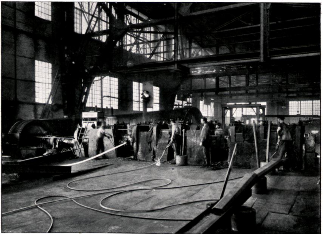
Abbildung 86. Stabstraße mit Handbedienung. Friedrich-Alfred-Hütte, Rheinhausen-Friemersheim.
