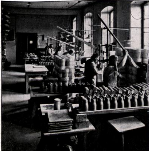
Abbildung 15. Porzellanfabrikation. Formung durch Pressen der Masse. (Herstellung von Isolatoren.)
