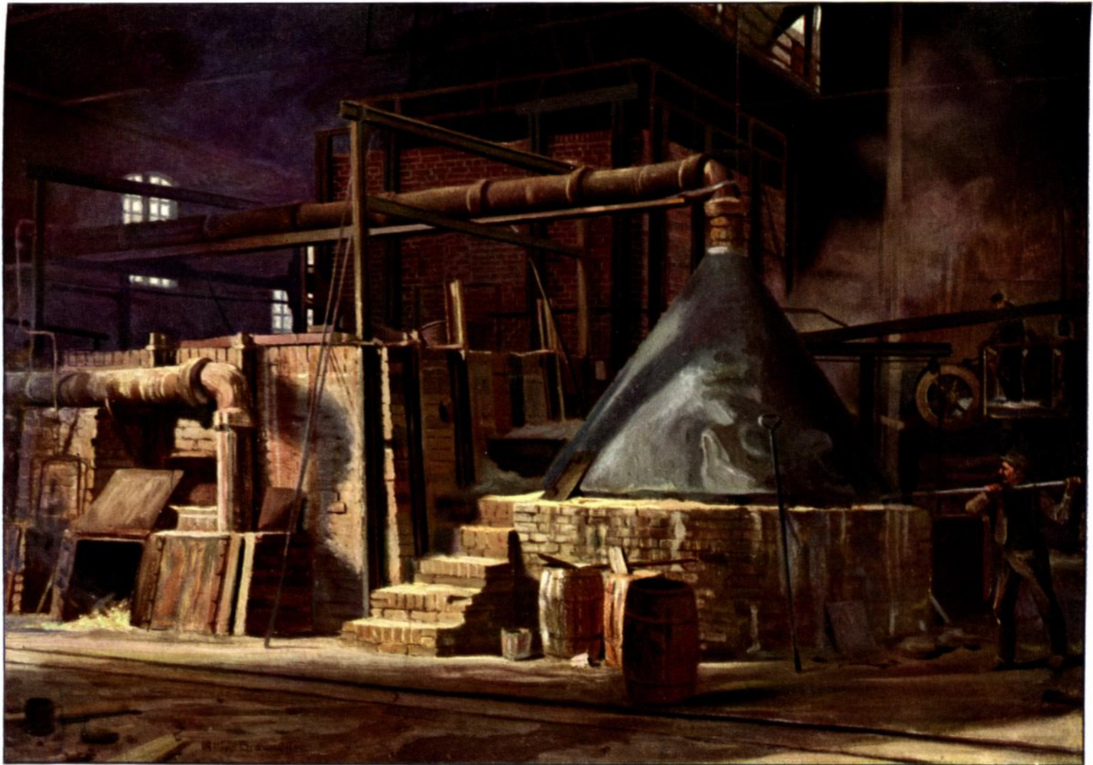
Alter und neuer Sulfatofen der Kunheimschen Fabrik.
