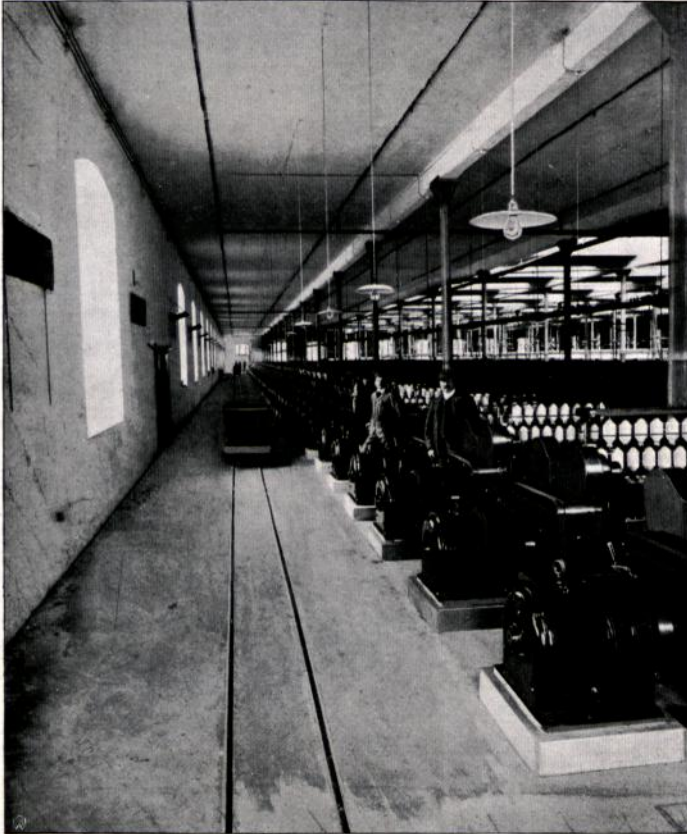
Abbildung 27. Ringspinnsaal mit direktem Antrieb von Ringspinnmaschinen durch Einphasen-Kollektormotoren von Brown, Boveri & Cie., A.-G., Mannheim-Käferthal.
