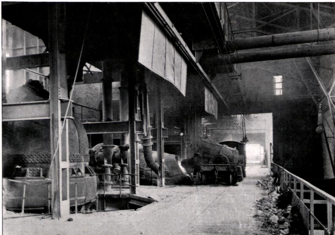
Abbildung 3. Konverteranlage der Friedrich-Alfred-Hütte, Rheinhausen-Friemersheim.
