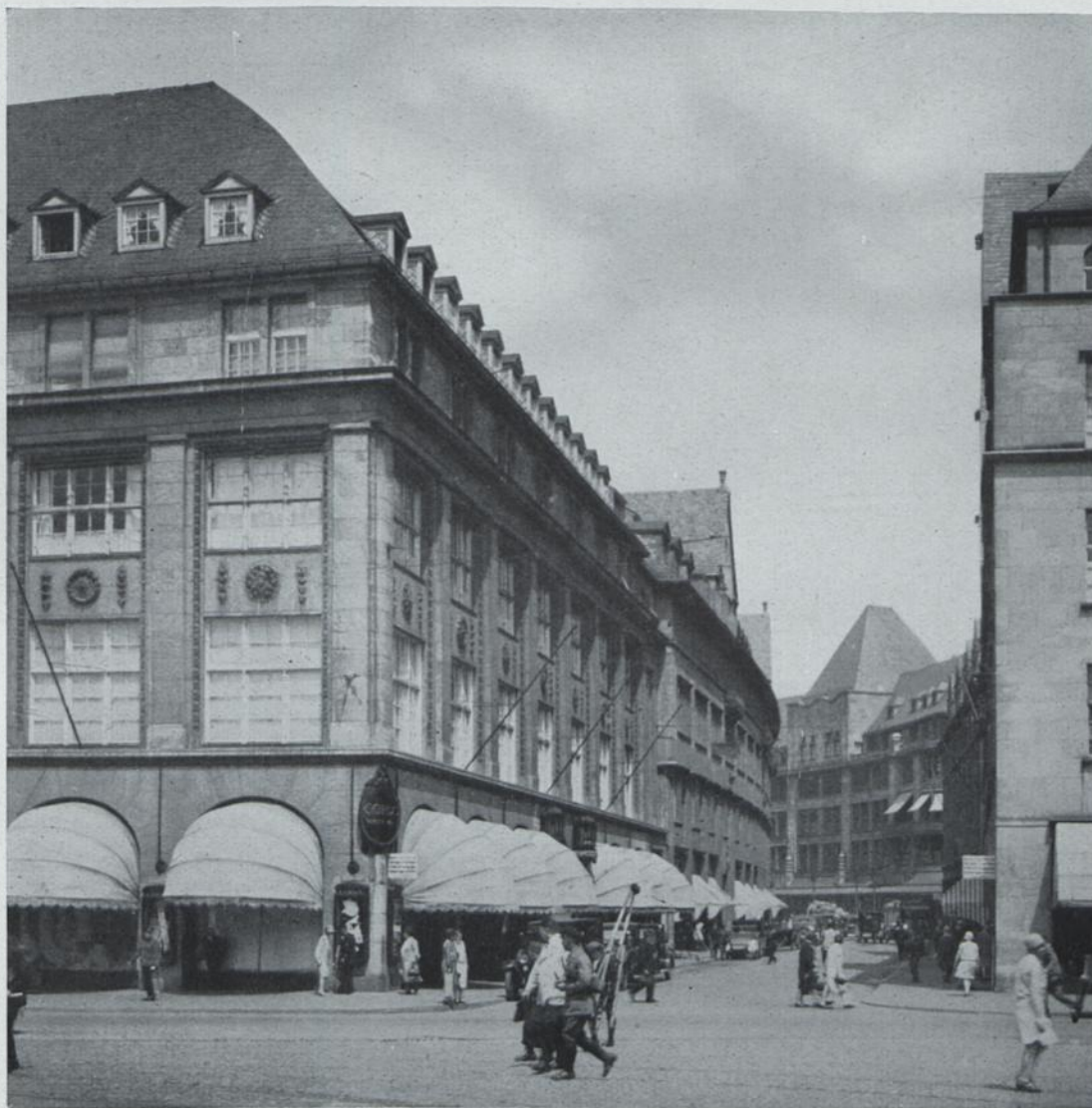
ZEPPELINSTRASSE · LINKS: CORDS · ARCH. SCHULZE-KOLBITZ · HINTEN: KAUFHAUS C. PETERS ARCH C. MORITZ
