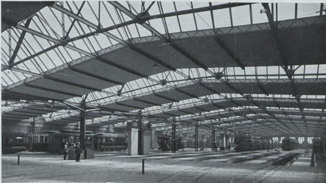
BAHNHOF SÜLZ · INNERES DER WAGENHALLE
