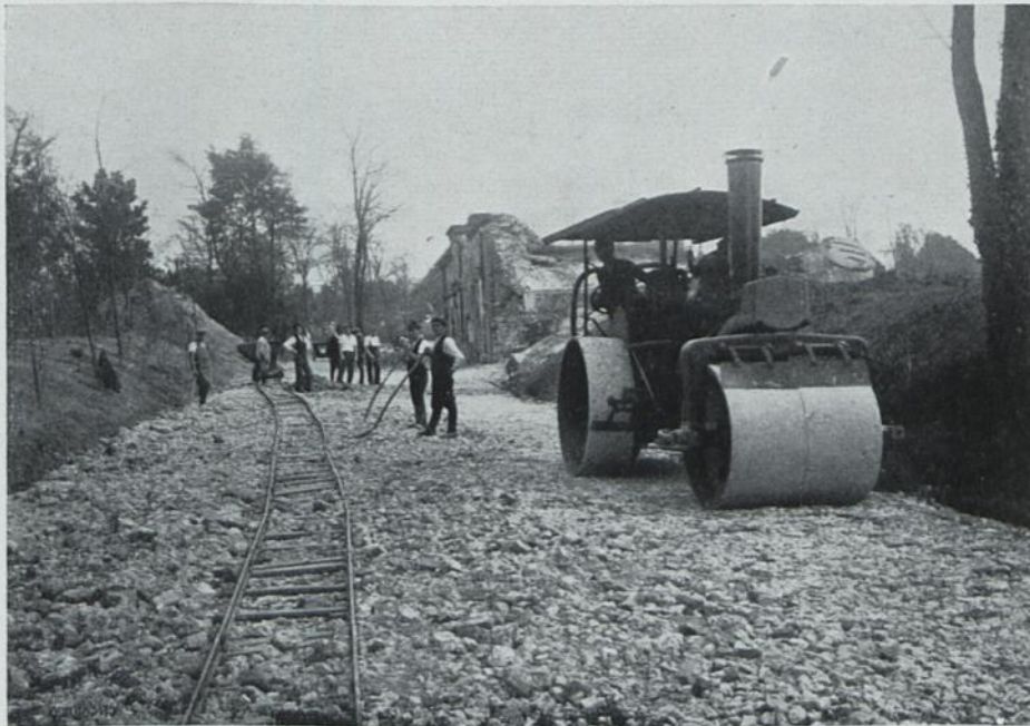
Straßenbau in der Stadtwalderweiterung in Köln
