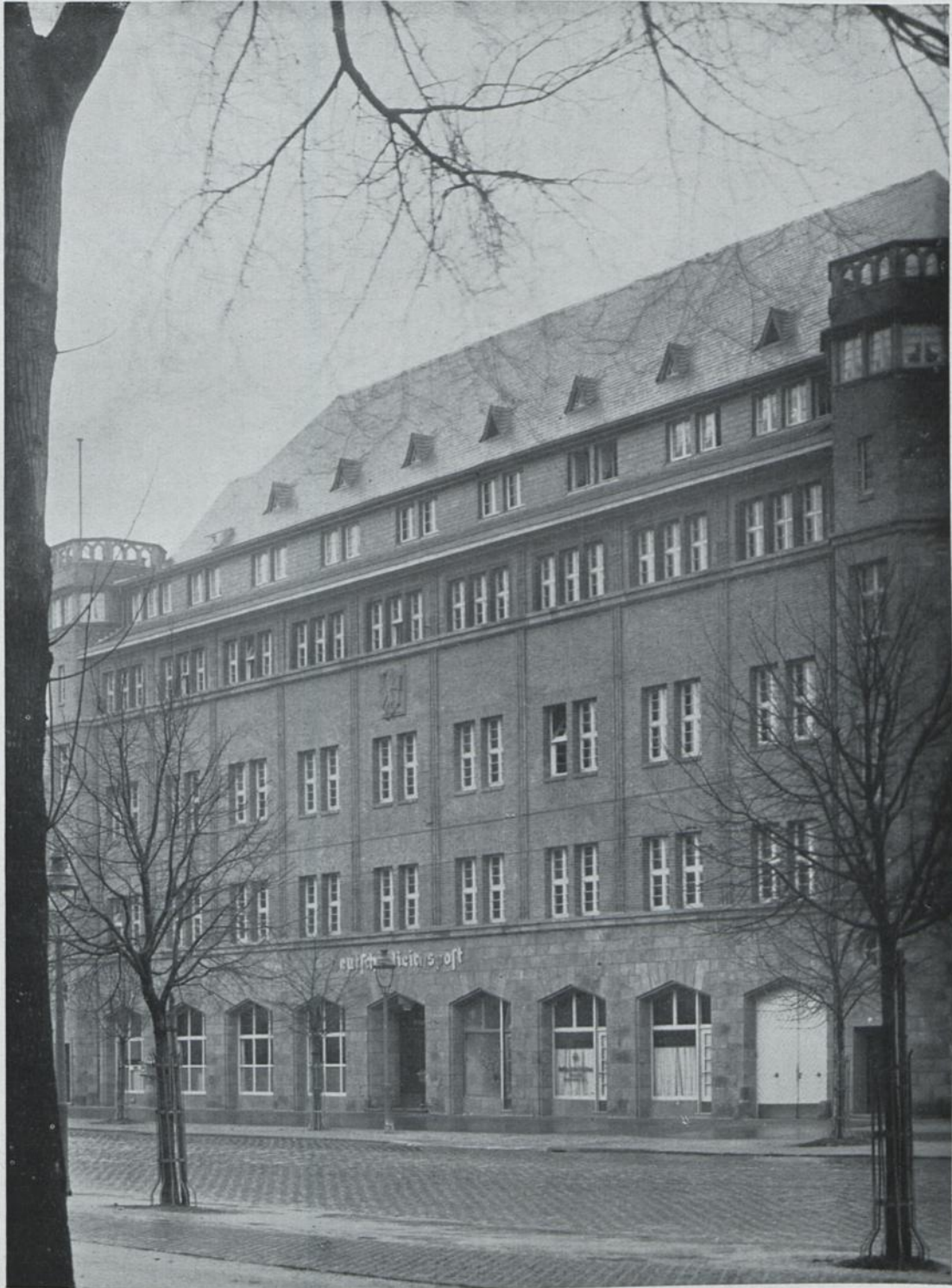
SELBSTANSCHLUSSAMT „NORDEN“ · NEUSSER STRASSE
