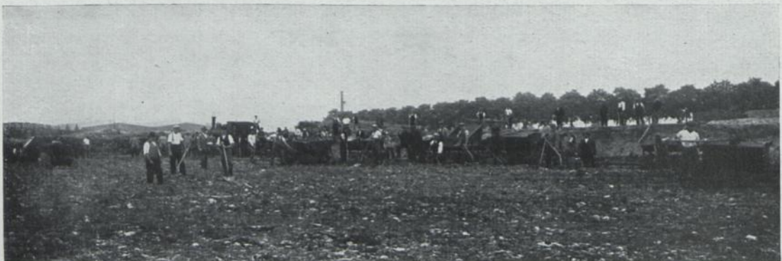
Erdarbeiten zur Herstellung eines Volksparks in Köln-Sülz.
