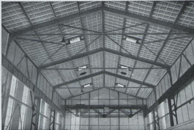
Turbinenhaus mit Kassettenplatten eingedeckt
