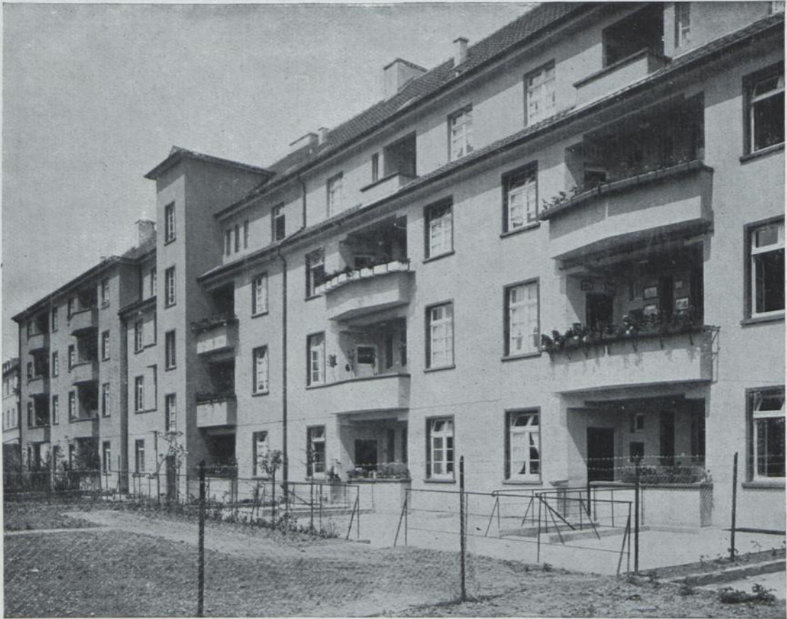
Wohnhausneubauten des Mieterschutz-Vereins E. V., Köln, Hofseite — Architekt V. R. A. Faensen, Köln, Baufirma J. C. Sesterhenn
