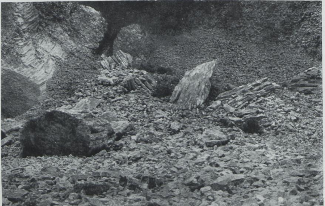
Wirkung eines Stollenschusses im Steinbruche Wilsenroth
