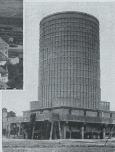
Kühlturm in Eisenbeton für das Großkraftwerk Trattendorf bei Spremberg. (Vereinigte Elektro-Werke, A.-G., Berlin).
