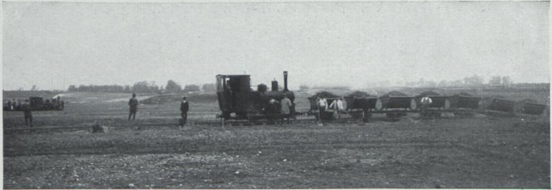
Erdarbeiten zur Herstellung eines Volksparks in Köln-Sülz.
