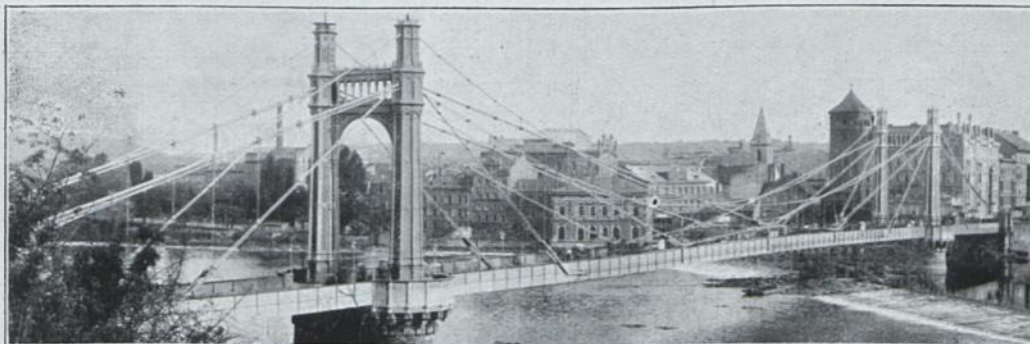
Kaiser-Franz-Josef-Brücke in Prag nach der Umänderung im Jahre 1898, Ketten ersetzt durch verschlossene Drahtseile des Carlswerks
