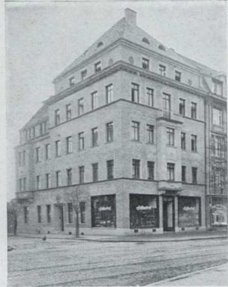
Haus Frankfurter Straße 42
