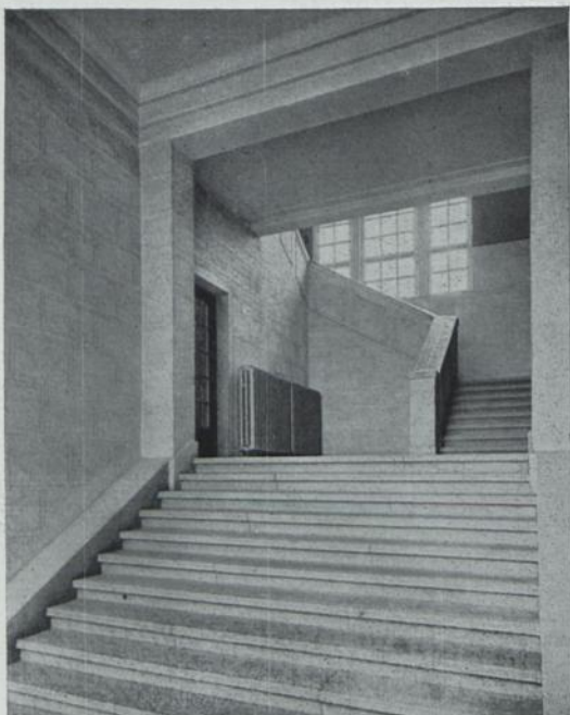
Bild 5 • Treppenaufgang zum Verwaltungsgebäude
