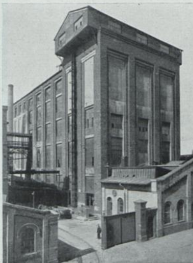
Salzbunker der Chem. Fabrik Kalk, A.-G., Köln-Kalk.
