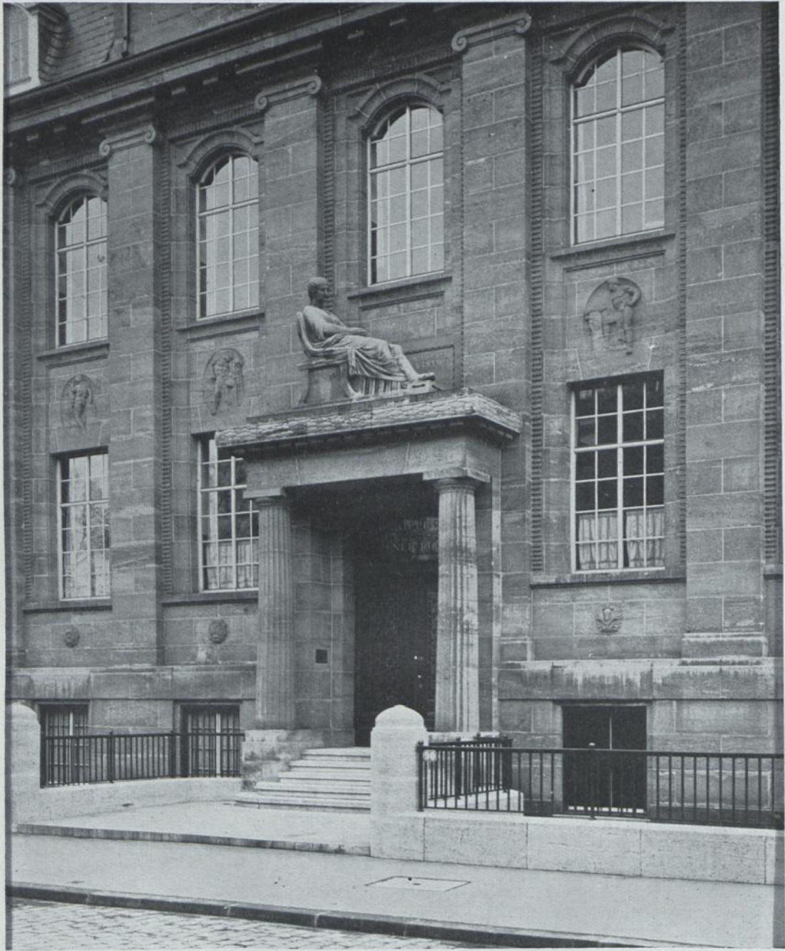
AGRIPPINA · RIEHLER STRASSE · ARCH. SCHREITERER UND BELOW
