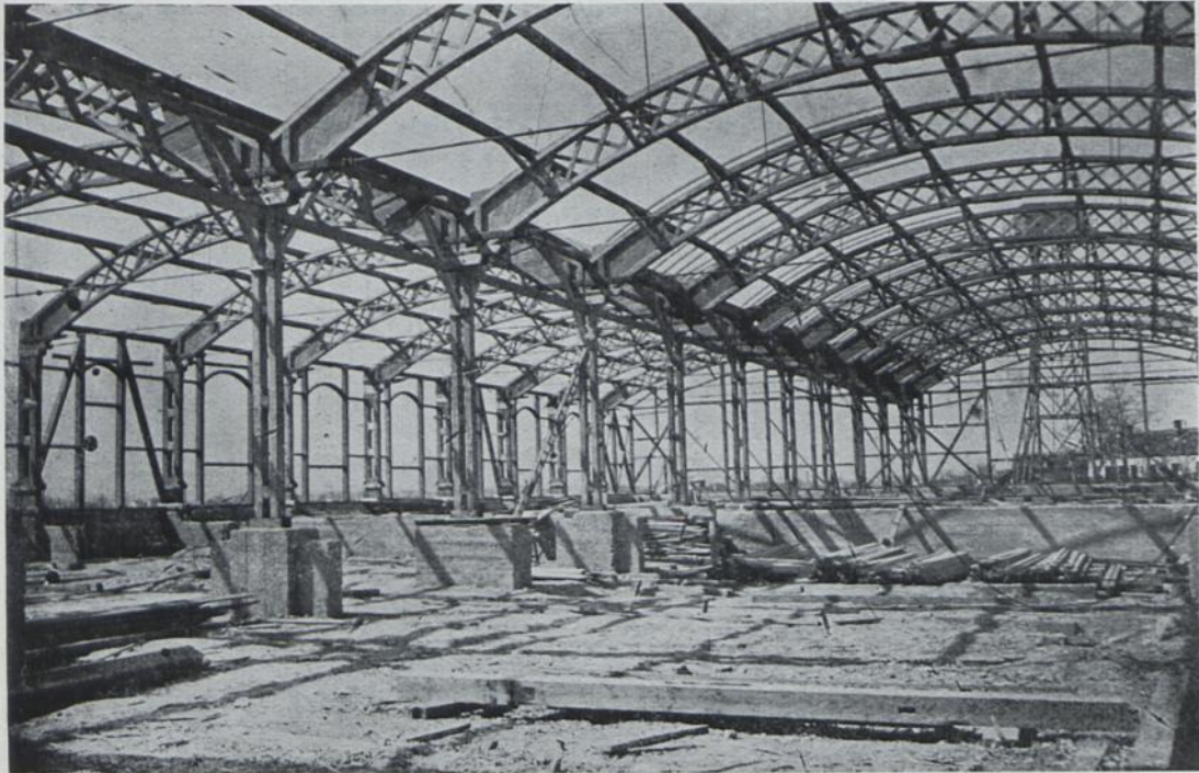
STÄDTISCHE TURNHALLE WÄHREND DER MONTAGE
