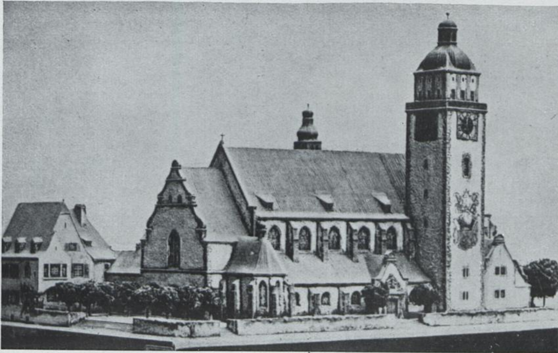
PFARRKIRCHE ST. PIUS · K.-ZOLLSTOCK · ARCHITEKT E. ENDLER
