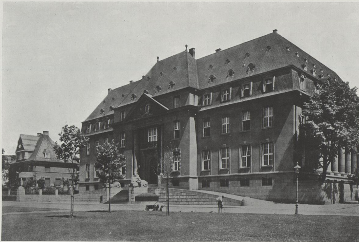
VERWALTUNGSGEBÄUDE DER BASALT-ACTIEN-GESELLSCHAFT, LINZ A. RH. · ARCH. B. D. A. HR. MATTAR & ED. SCHELER, KÖLN
