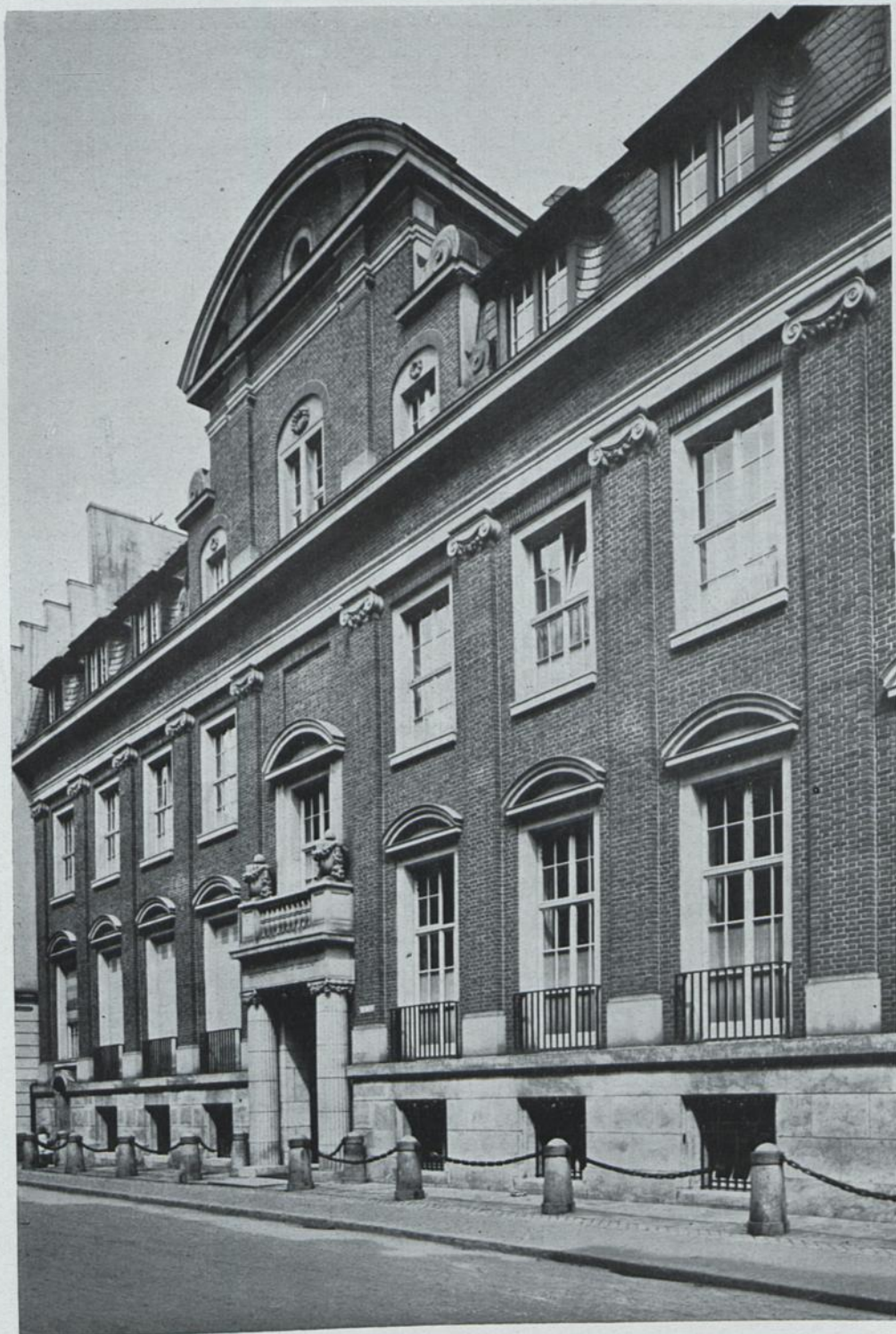
KÖLN. RÜCKVERSICHERUNGSGESELLSCHAFT · ARCHITEKT H. PFLAUME
