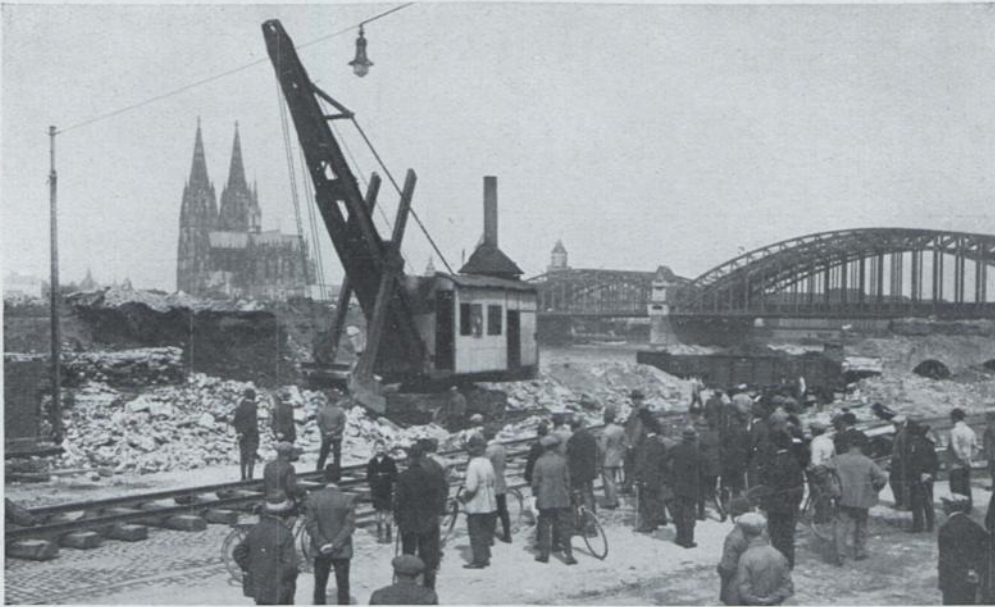
Abtragung der Brückenrampen Deutz
