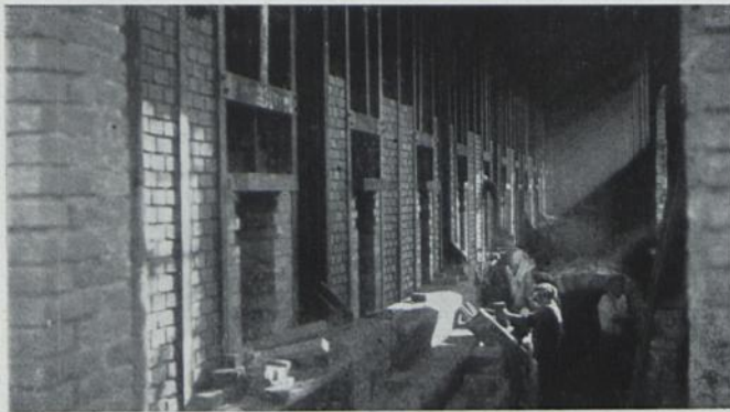
Steinzeugröhren-Brennofen, 135 qm Bodenfl., für Kleinsorg & Loevenich und Jak. Kalscheuer & Cie., Frechen
