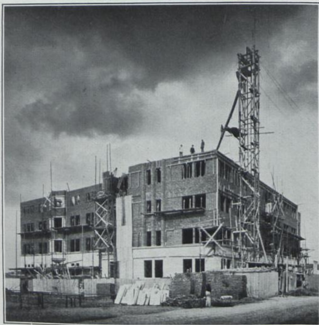
Neubau des Selbstanschlußamtes „Eifel“ (mit Turm zum Betongießverfahren)
