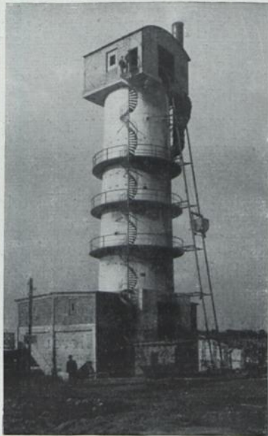
Kalkofen in Eisenbeton (Neandertal) Ausf.: Eckardt & Hotop, Köln Berechnung: Dr.-Ing. R. Gärtner, Köln
