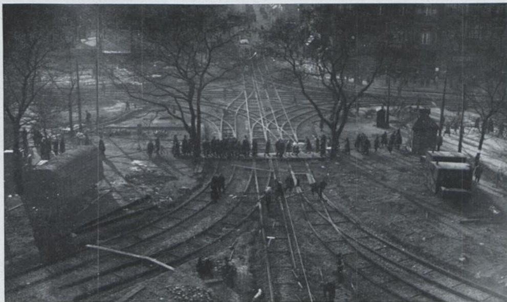
Gleisanlagen am Rudolfplatz
