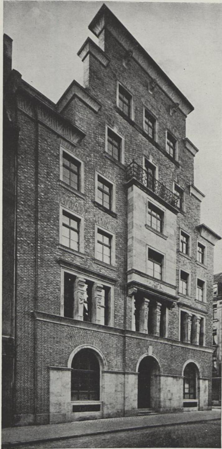
WESTDEUTSCHES RUNDfunkHAUS, DAGOBERtSTRASSE ARCHITEKTEN VOLBERG UND PHILIPPSON Photographie H. Schmölz
