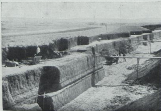
Bimsgrube, aus der der vorzügliche Rohstoff der „Moskopfsteine“ gewonnen wird
