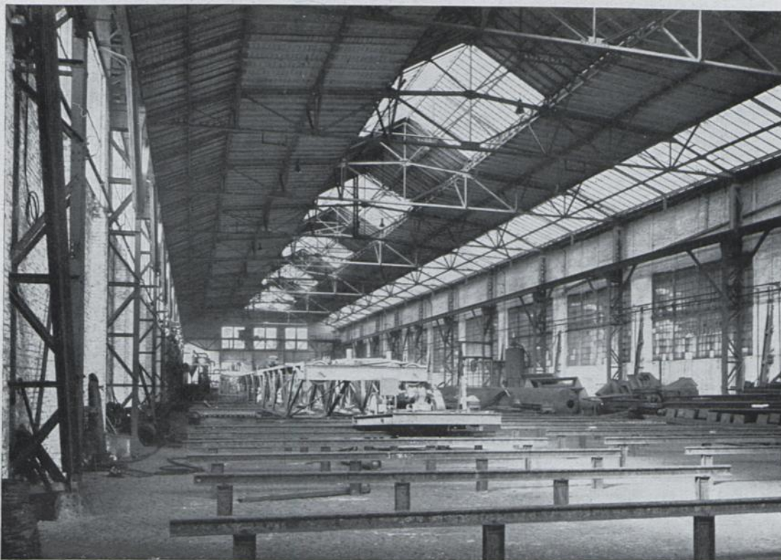
WERKSTATTHALLE NR. 0 DER MASCHINENBAUANSTALT HUMBOLDT · KÖLN-KALK
