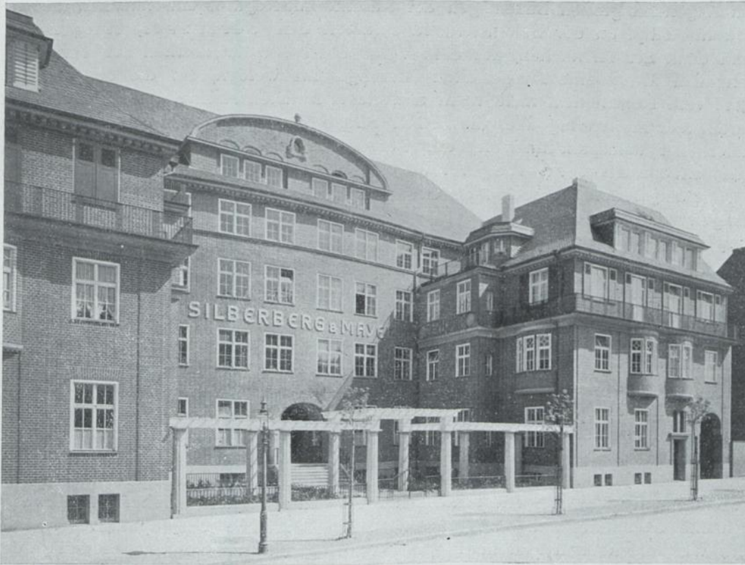
GESCHÄFTSHAUS SILBERBERG UND MAYER · ARCHITEKT J. BERNIS
