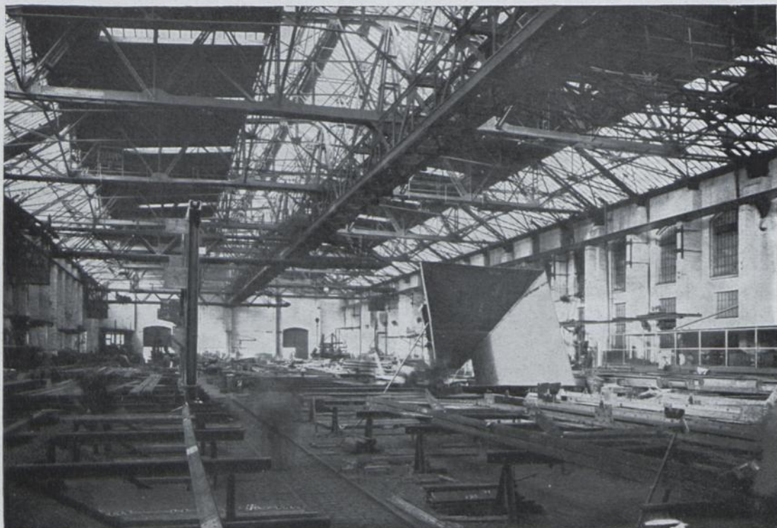
WERKSTATTHALLE NR. II DER MASCHINENBAUANSTALT HUMBOLDT · KÖLN-KALK
