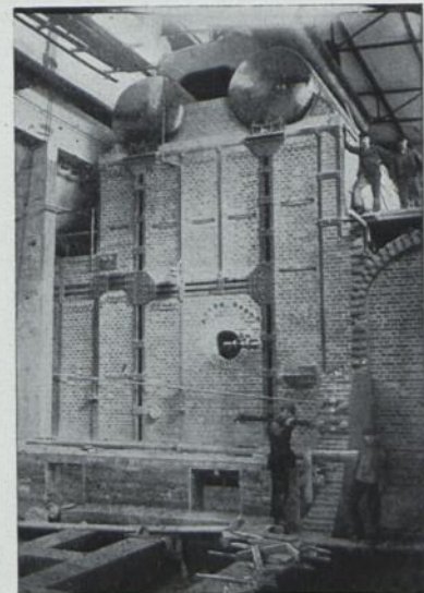
3 Kesseleinmauerungen für Rhein. Akt.-Ges. für Braunkohlenbergbau und Brikettfabrikation, Köln, Grube Donatus
