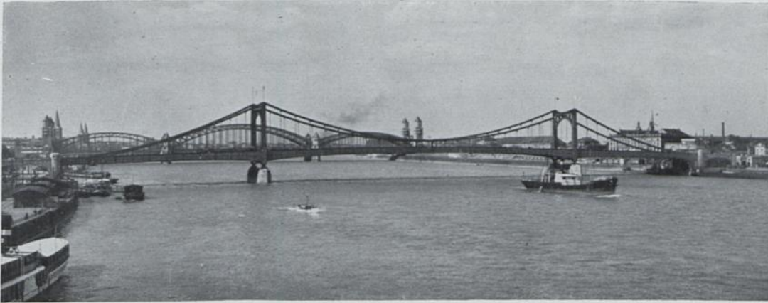
Hängebrücke. — Es betragen: Pfeilhöhe des mittleren Kettenzuges 21,54 m. Pfeilhöhe des mittleren Versteifungsträgers 3,04 m, Höhe der Pylonen über dem Strompfeiler 31,11 m, Höhe des Versteifungsträgers über den Endauflagern 3,30 m, Höhe des Versteifungsträgers über den Mittelaflagern 5,50 m, Höhe des Versteifungsträgers in Brückenmitte 3,20 m, Breite des Versteifungsträgers in Brückenmitte 0,90 m, Abstand der Haupttrügerebenen 19,10 m, Fahrbahnbreite 11,20 m, lichte Weite der Fußwege je 3,50 m.
