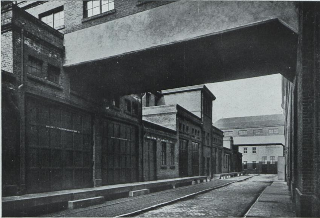
Bild 5 · Straße zwischen Maschinenhaus und 25 KV-Schaltheus
