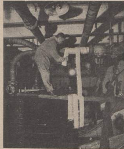
Fig. 4. Umwicklung eines Dampfrohres.
