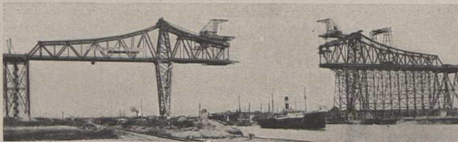
Abb. 22. Aufstellung der Hochbrücke bei Rendsburg.
