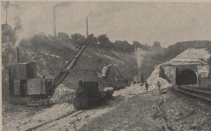
Felscoreinschnitt des zweiten Tunnels bei Lengerich i. W.
