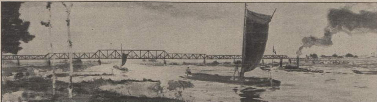
Abb. 19. Eisenbahnbrücke über die Elbe bei Hämerten.
