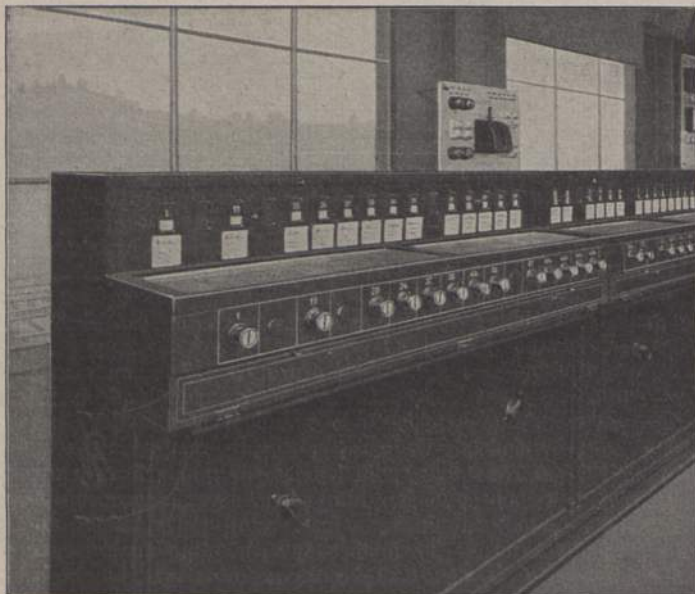
Abb. 12. Elektrisches Stellwerk.
