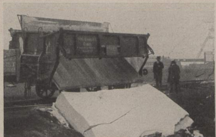
Abb. 26 und 27. Flachboden-Selbstentlader für beiderseitige Entleerung während der Entladung.
