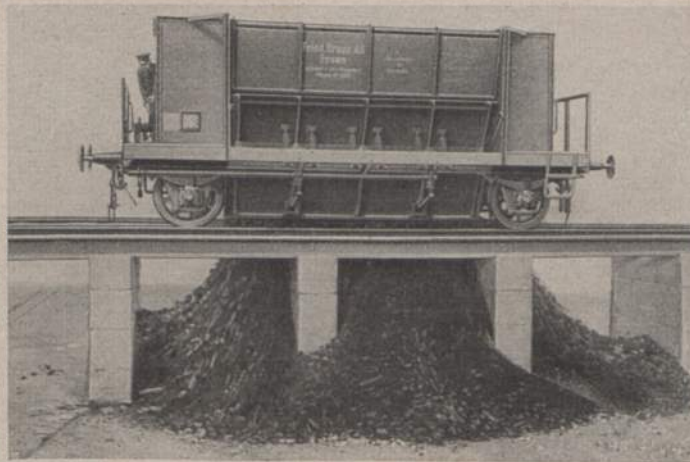
Abb. 24. Selbstentlader für Bodenentleerung während der Entleerung. Ladegewicht 20 000 kg.
