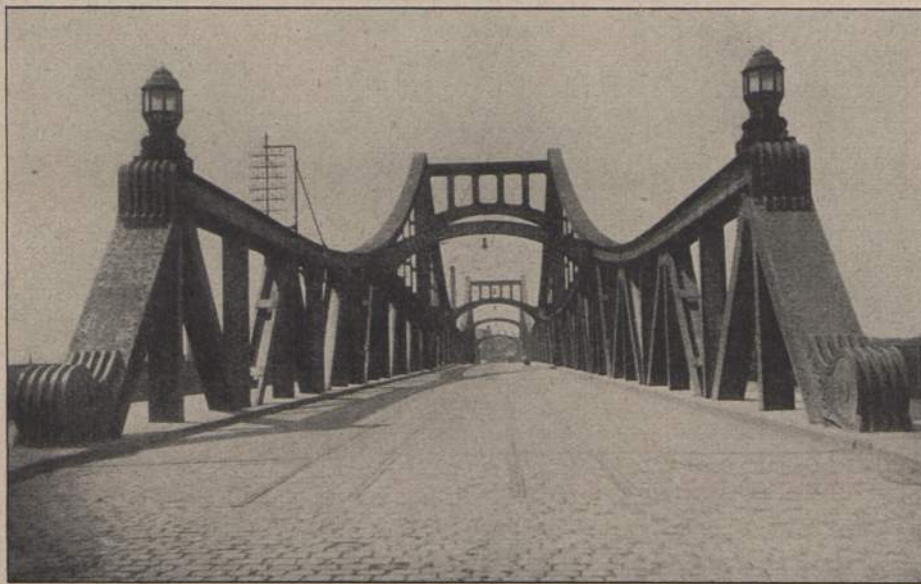
Abb. 8. Durchblick durch die Hindenburgbrücke in Halle a. d. Saale.
