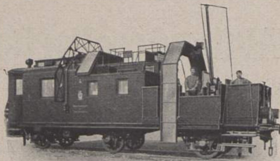
Abb. 2. Tunneluntersuchungswagen der Reichsbahn, ausgerüstet mit einer Fahrbatterie, bestehend aus 80 Elementen der Gattung VII J 100 und einer Lichtbatterie, bestehend aus 64 Elementen der Gattung VI J 100.
