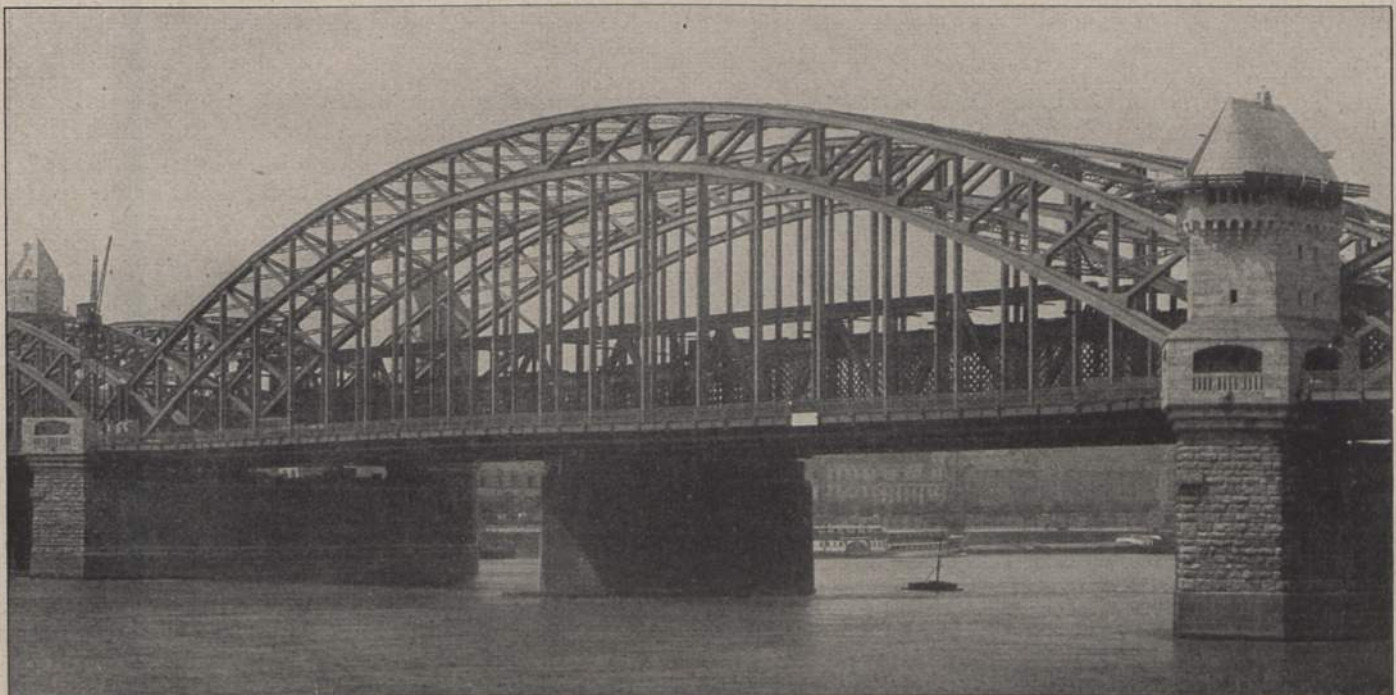
Abb. 6. Mittelöffnung der Hohenzollernbrücke über den Rhein bei Köln.
