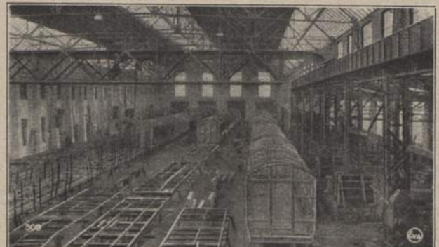
Waggonfabrik Wismar (Montagehalle für den Bau eiserner Wagen).
