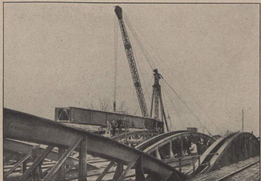
Abb. 12. Montage von Blechträgerbrücken in Heilbronn.
