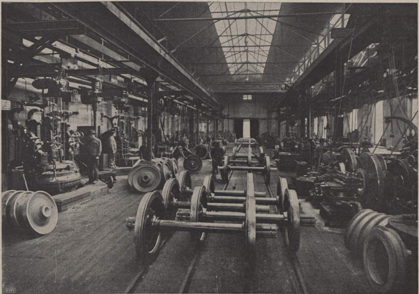
Räderdreherei der Stahlwerke Gleitwitz
