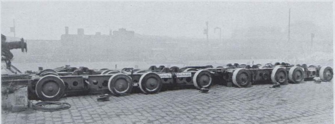
Abb. 127. Zwei Straßenfahrzeuge mit Verbindungsbrücke vor der Ueberladerampe. (Foto Reichsbahn.)
