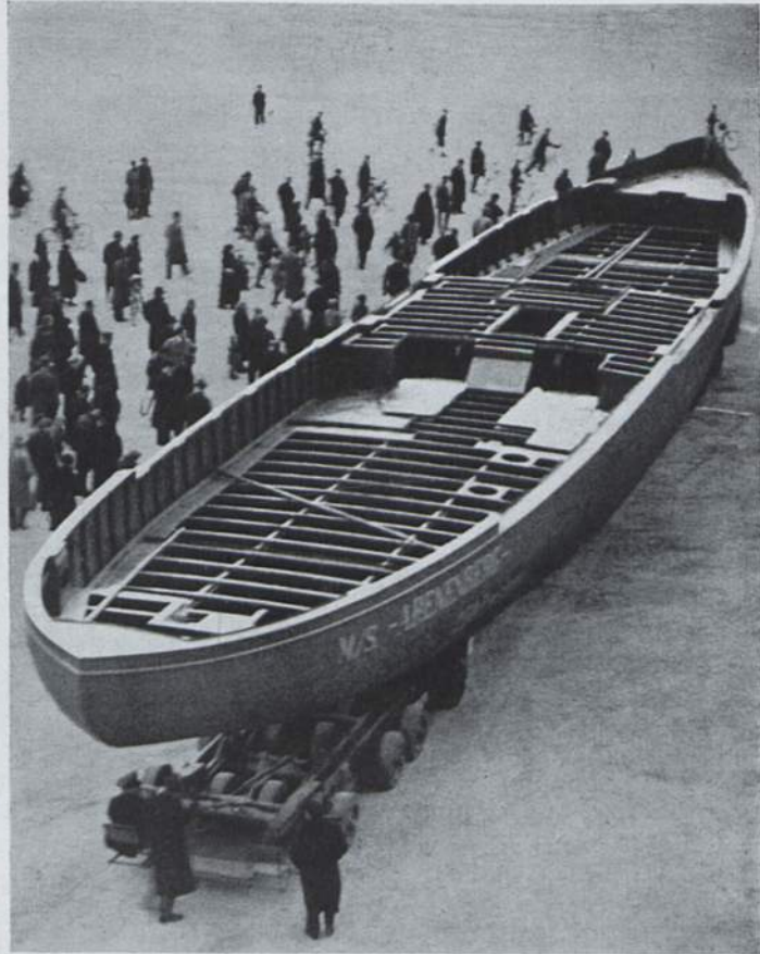
Abb. 332. Schiffsrumpf auf zwei Straßenfahrzeugen der Reichsbahn in der Schweiz. (Foto Sulzer.)
