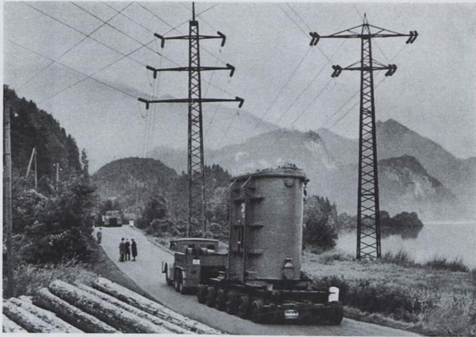
Abb. 340. Beförderung eines 60 t schweren Transformators zum Walchensee-Kraftwerk. (Foto Reichsbahn.)
