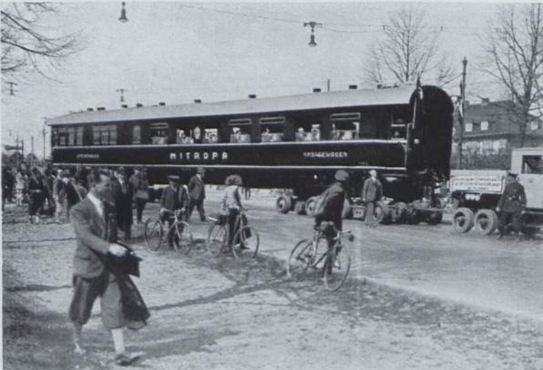
Abb. 120. Fahrt eines Mitropa-Speisewagens auf zwei Straßenfahrzeugen. (Foto Reichsbahn.)
