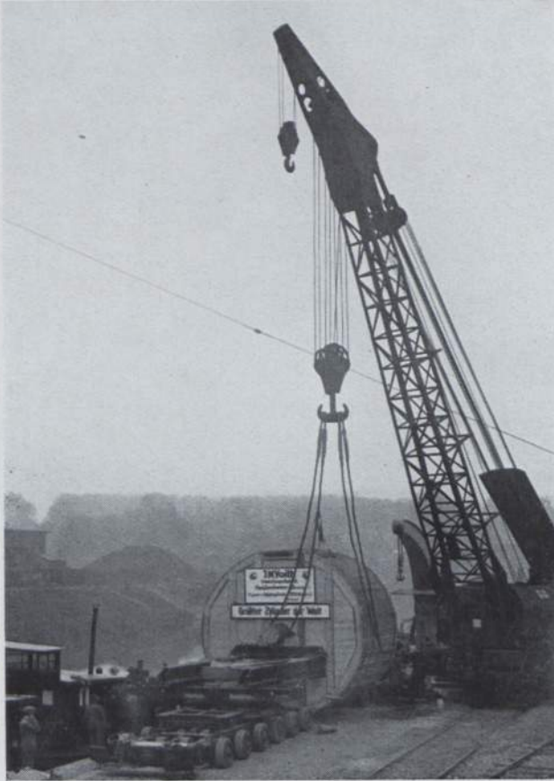
Abb. 370. Abheben des Zylinders vom Straßenfahrzeug ins Schiff mit dem 75 t-Kran der Reichsbahn. (Foto Reichsbahn.)
