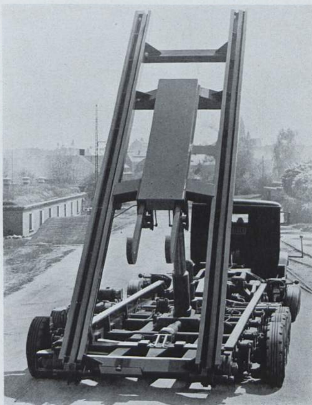
Abb. 173. Aufsicht auf den Straßenkipper der Reichsbahn, Kippbühne aufgerichtet. (Werkfoto Wumag.)
