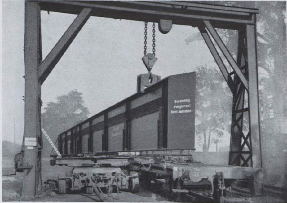
Abb. 328. Ueberladen eines langen Brücken- trägers vom Eisen- bahnwagen auf das Straßenfahrzeug. (Foto Reichsbahn.)
