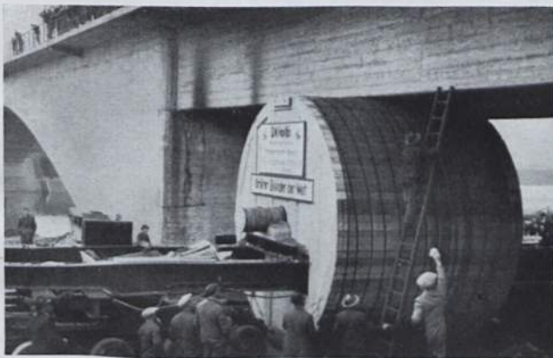
Abb. 369 a u. b. Absenken des Zylinders mit Hilfe hydraulischer Pressen. (Foto Reichsbahn.)
