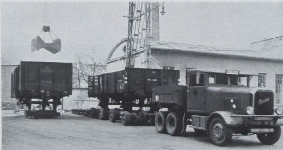
Abb. 253. Entladung von Kohlenwagen auf fahrbaren Absetzgleisen mittels Greiferhängebahn im Ueberlandkraftwerk Pulsnitz/Sa. (Foto Reichsbahn)
