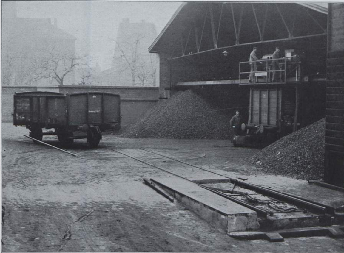
Abb. 251. Feste Absetzanlage mit Drehscheibe und zwei Stichgleisen im Hof des Kesselhauses (Firma Kaiser, Viersen). (Foto Reichsbahn.)
