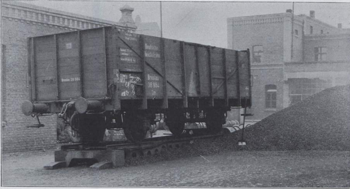
Abb. 278. Absetzgleis mit Kohlenwagen am Kohlenlager einer Spinnerei in Viersen. (Foto Reichsbahn.)
