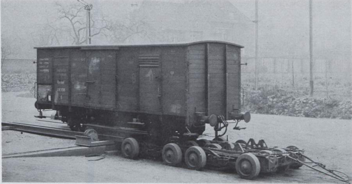
Abb. 258. Absetzen eines Güterwagens auf die vordere Schiebebühne. (Foto Reichsbahn)
