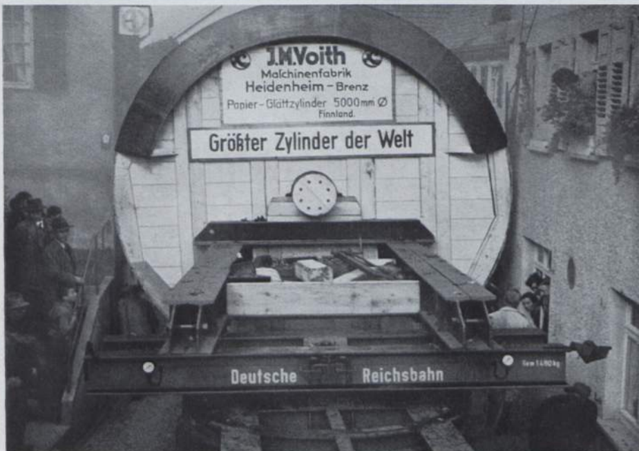
Abb. 367. Der Lastzug in enger Gasse. (Foto Reichsbahn.)
