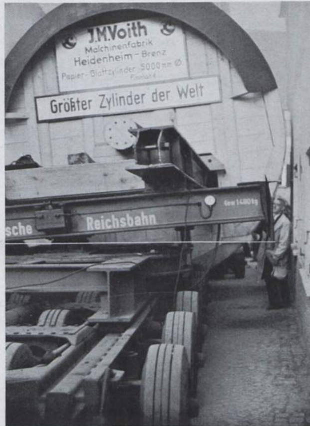
Abb. 368. Der Zylinder wird mittels hydraulischer Pressen verkippt, um die Durchfahrt zu ermöglichen. (Foto Reichsbahn.)
