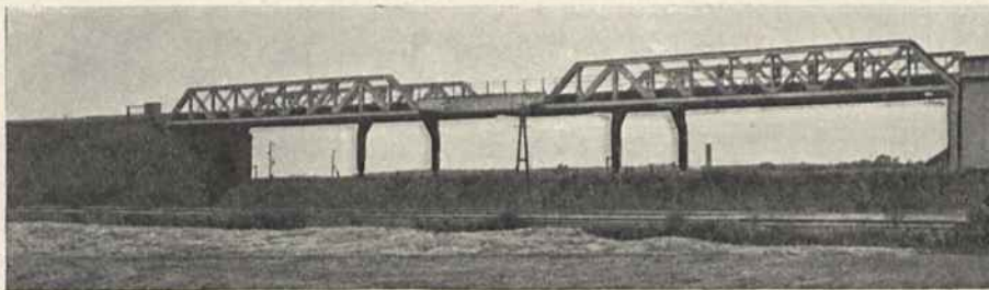
Abb. 326. Eisenbahnüberführung bei Westend.
