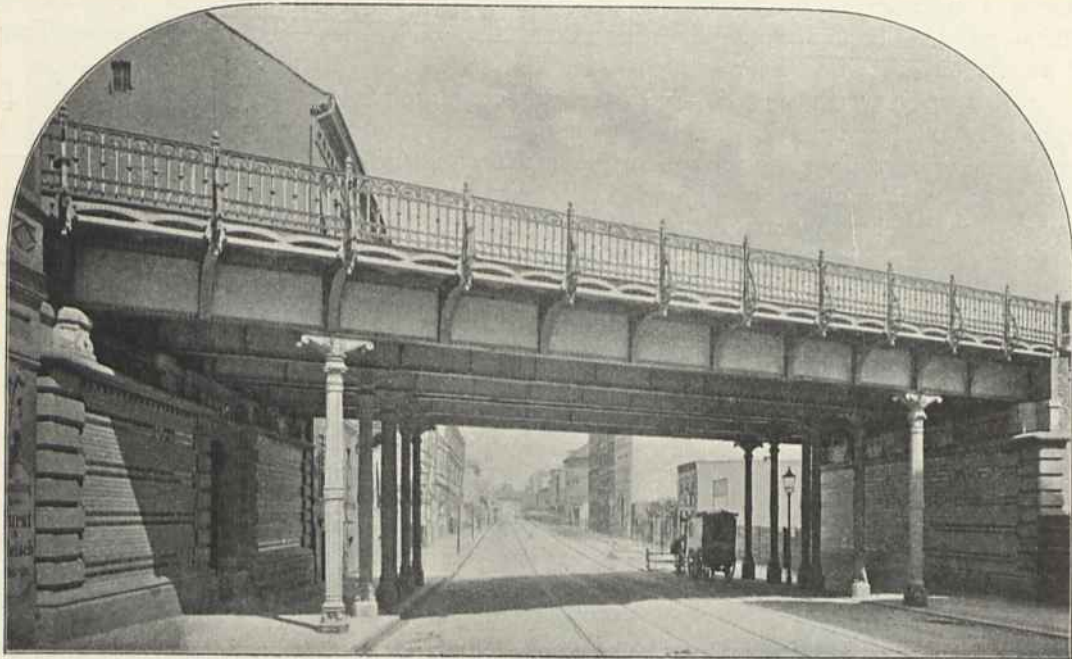
Abb. 283. Unterführung der Karlstraße.
