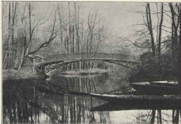
Abb. 214. Eiserne Bogenbrücke am Neuen See.
