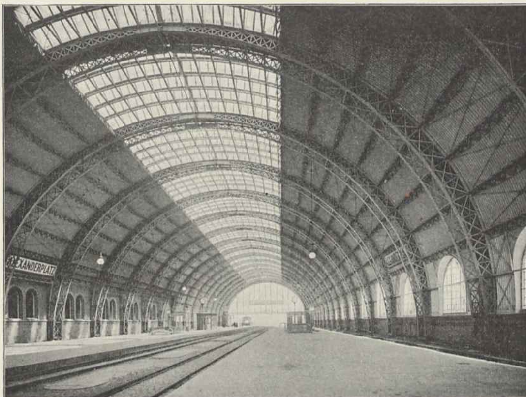
Abb. 297. Bahnhof Alexanderplatz, Innenansicht.
