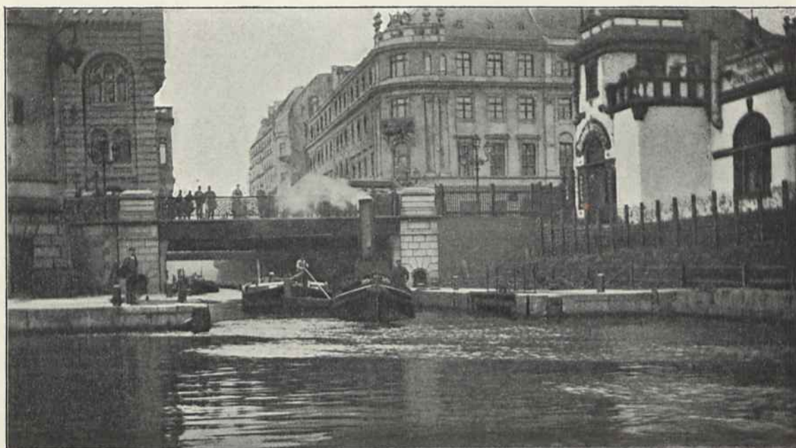
Abb. 91. Oberhaupt der Mühlendammschleuse.
