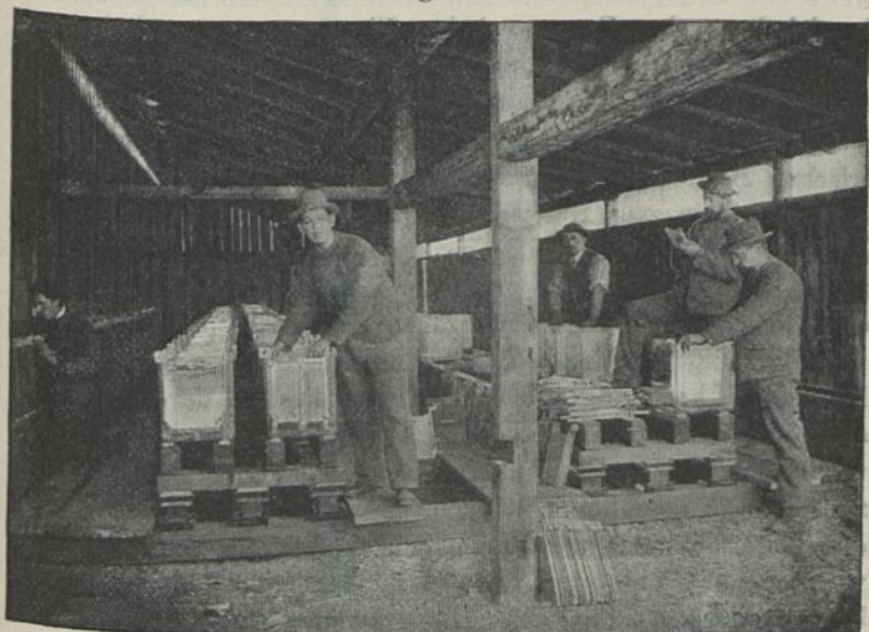
Aufstellung einer Pufferbatterie.
