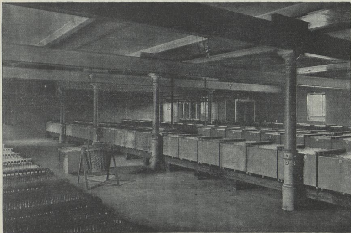
Batterie der Hafenzentrale in Mannheim. (Kölner Accumulatorenwerke G. Hagen in Kalk bei Köln).
