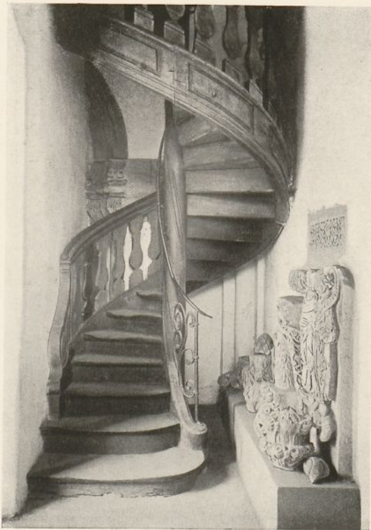
Trebnitz. — Wendeltreppe in der katholischen Pfarrkirche
