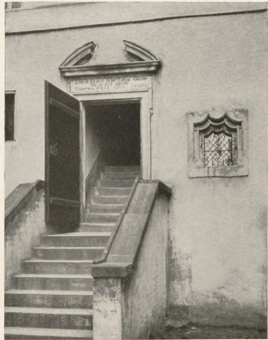
Glatz. — Sakristeitreppe an der kath. Pfarrkirche
