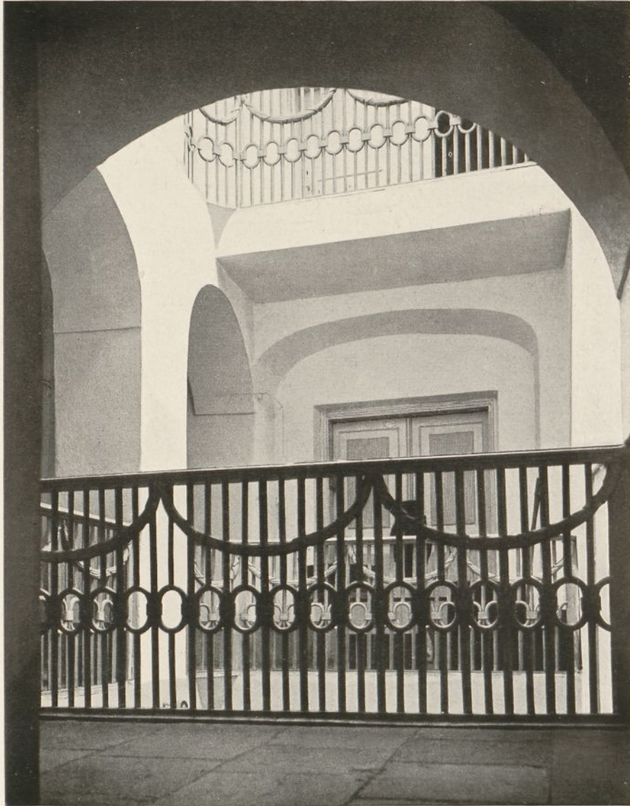
Hirschberg. — Treppenhalle eines Hauses am Ring
