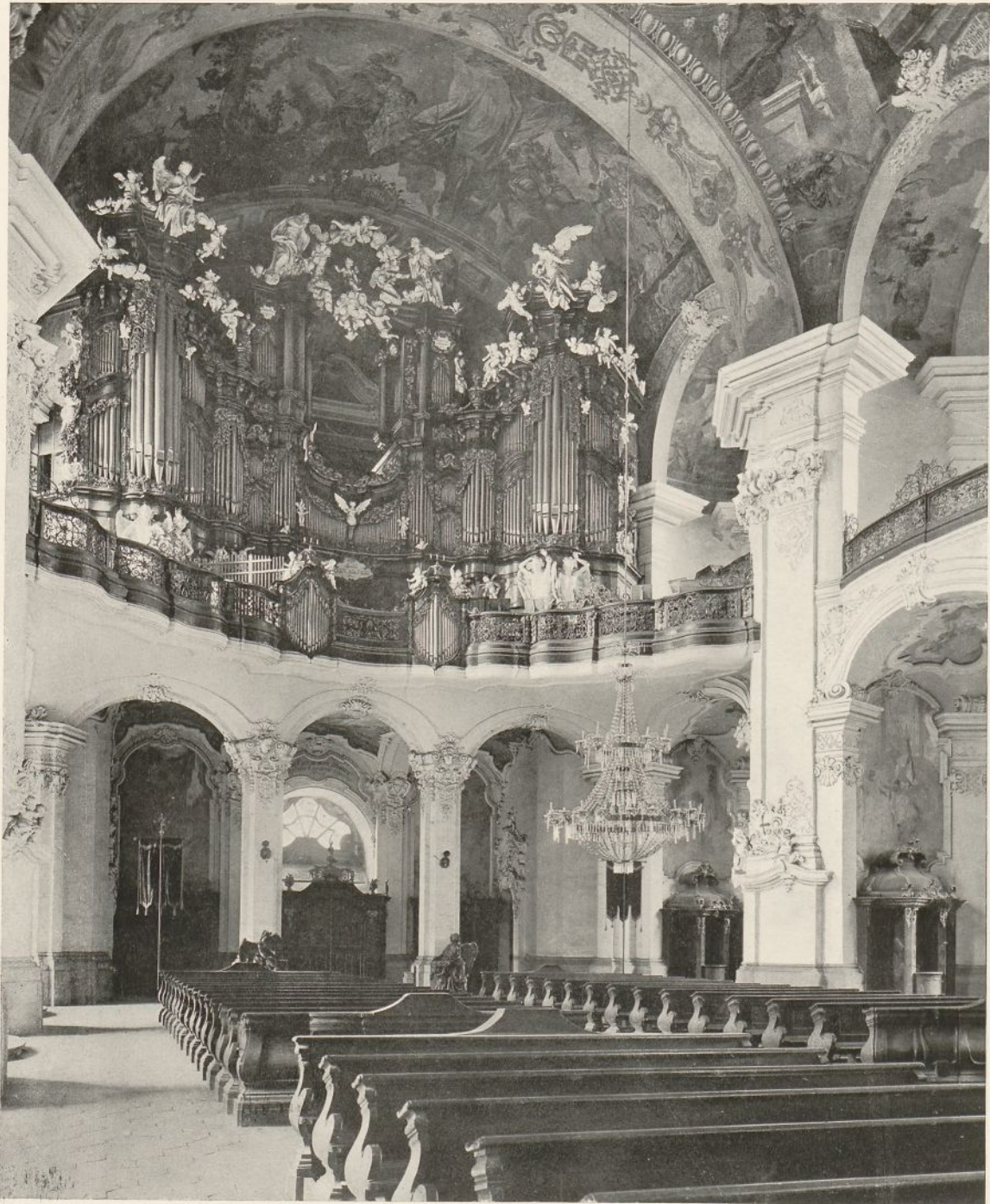
Größau. — Ehemalige Zisterzienserklsterkirche. Orgelempore
