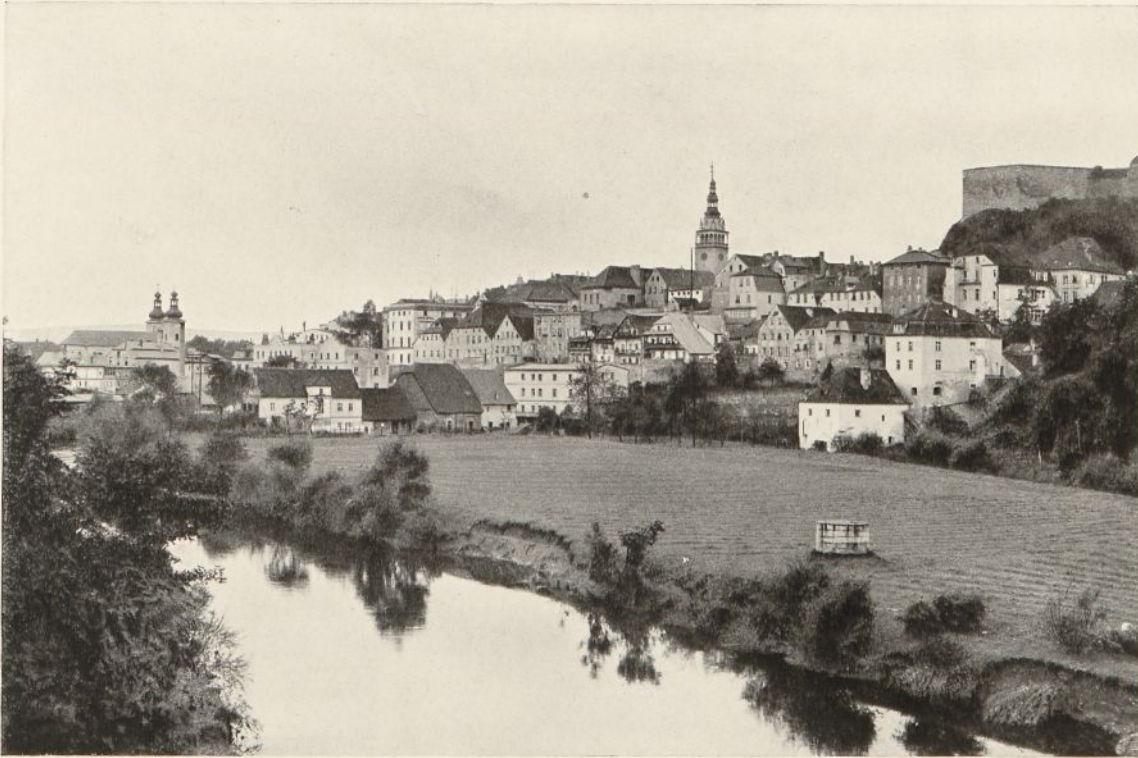
Glatz. — Gesamtansicht von der Neißebrücke aus
