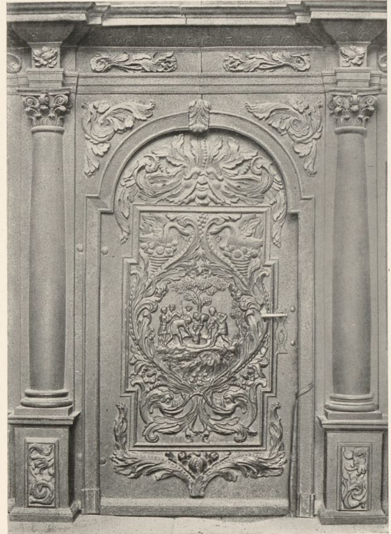
Breslau. — Dom. Geschnitzte Tür des Haupteingangs
