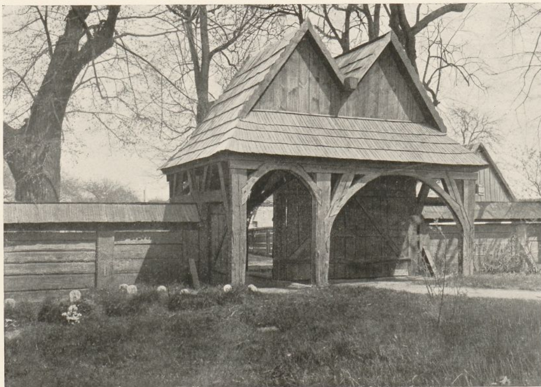
Bürgsdorf (O. Schl.). — Das Torhaus des Kirchhofs
