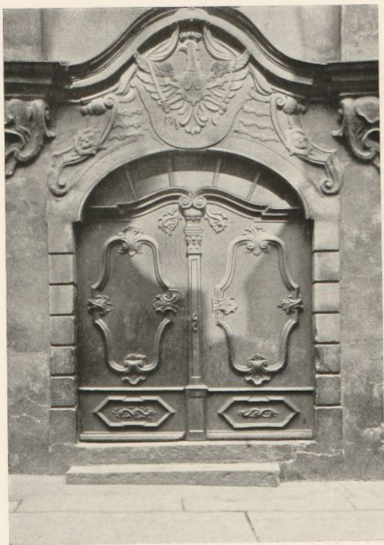
Breslau. — Portal des Hauses Weißgerber Gasse 43
