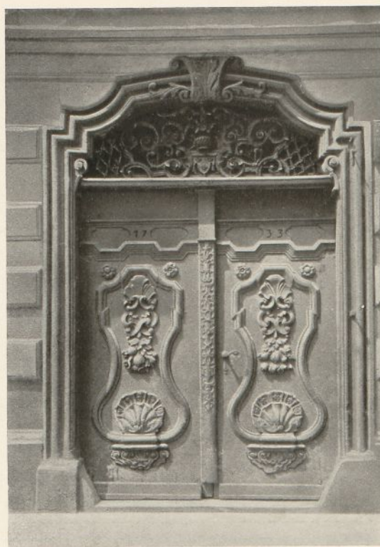
Breslau. — Portal des Hauses Altbüßerstraße 61, von 1733
