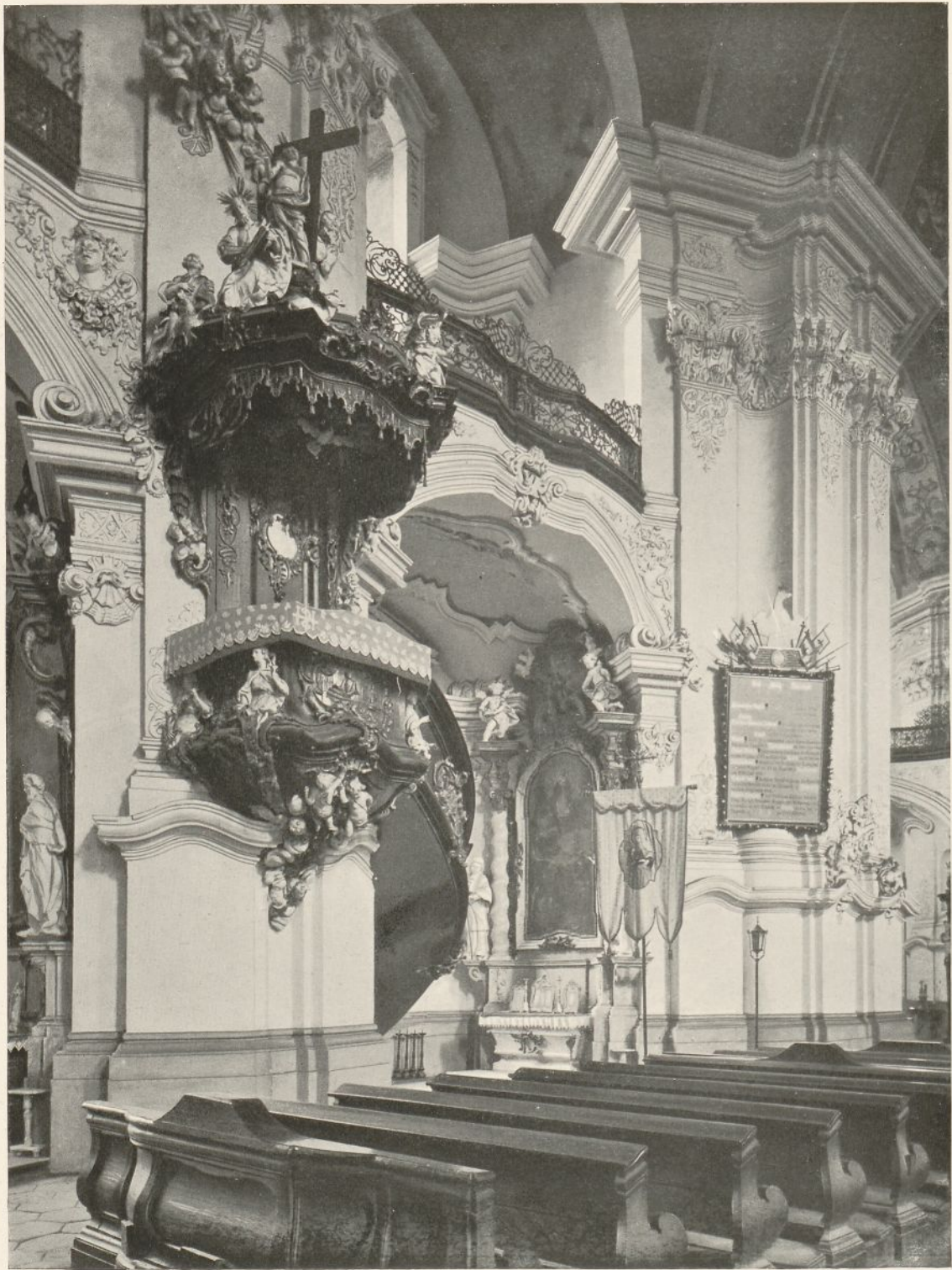
Grüßau. — Ehemalige Zisterzienserklosterkirche. Inneres
