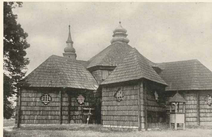
Rosenberg (O. Schl.). — Die Wallfahrtskirche St. Anna. — Zentralbau um 1669
