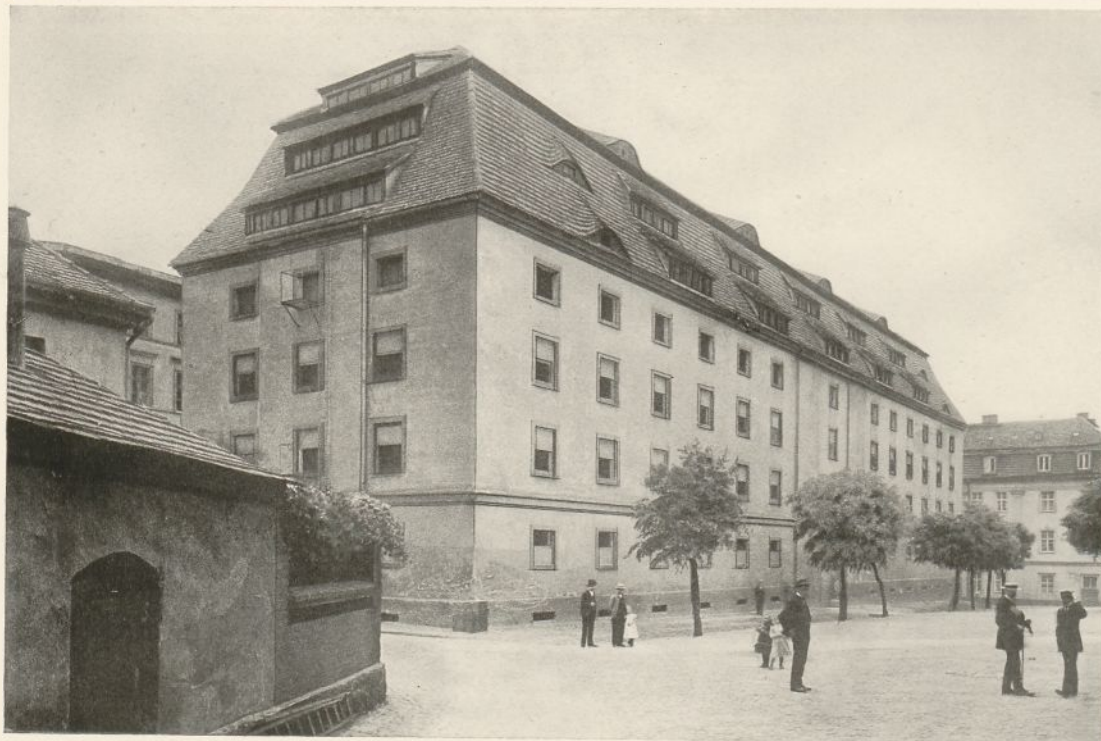
Schweidnitz. — Ein Magazingebäude, 18. Jahrh.
