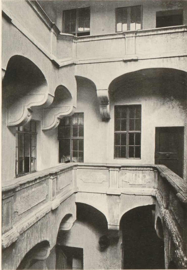
Görlitz. — Hof mit Laufgängen im Hause Petersstraße 4
