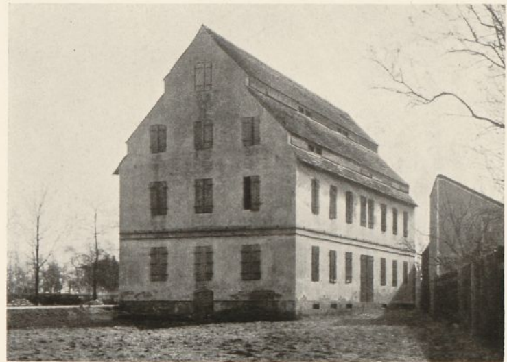
Ohlau. — Ein Lagerhaus
