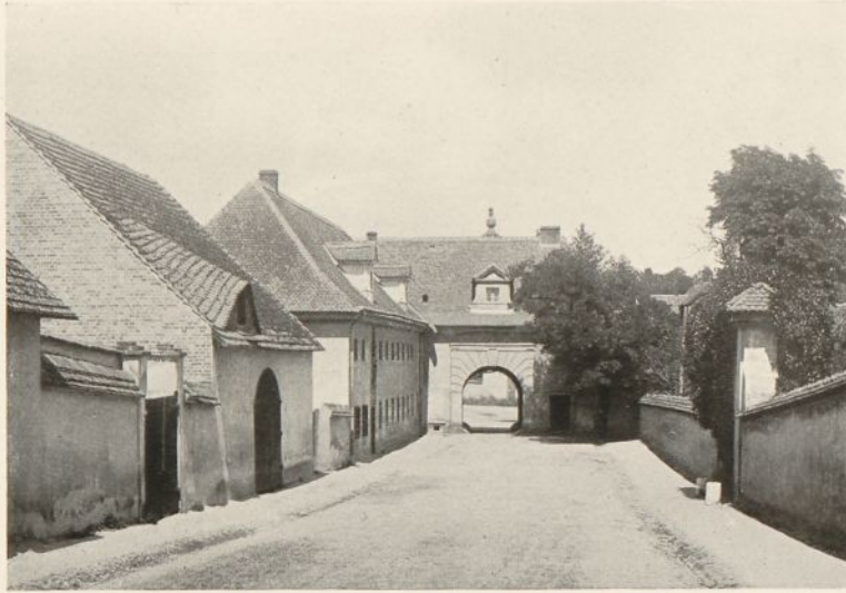
Leubus. — Blick in die Dorfstraße
