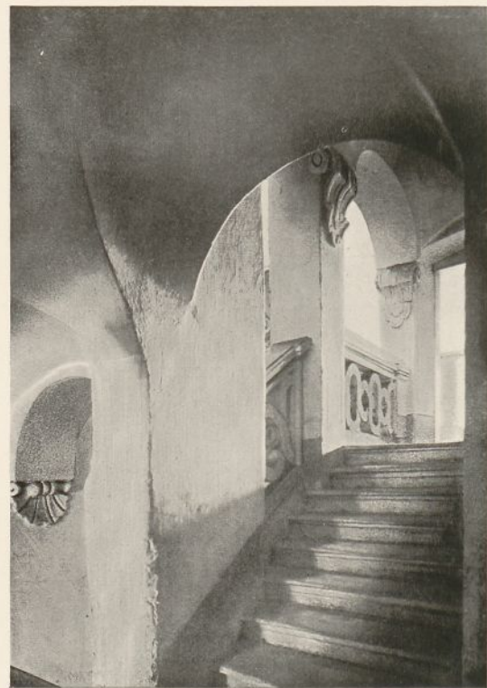
Greiffenberg. — Treppenhaus eines Ringhauses (jetzt abgebrochen)
