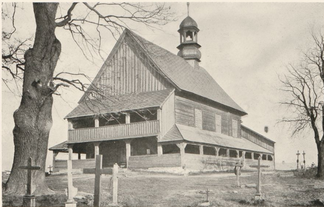
Groß-Döbern (O. Schl.). — Wallfahrtskirche, 1680 bzw. 1752
