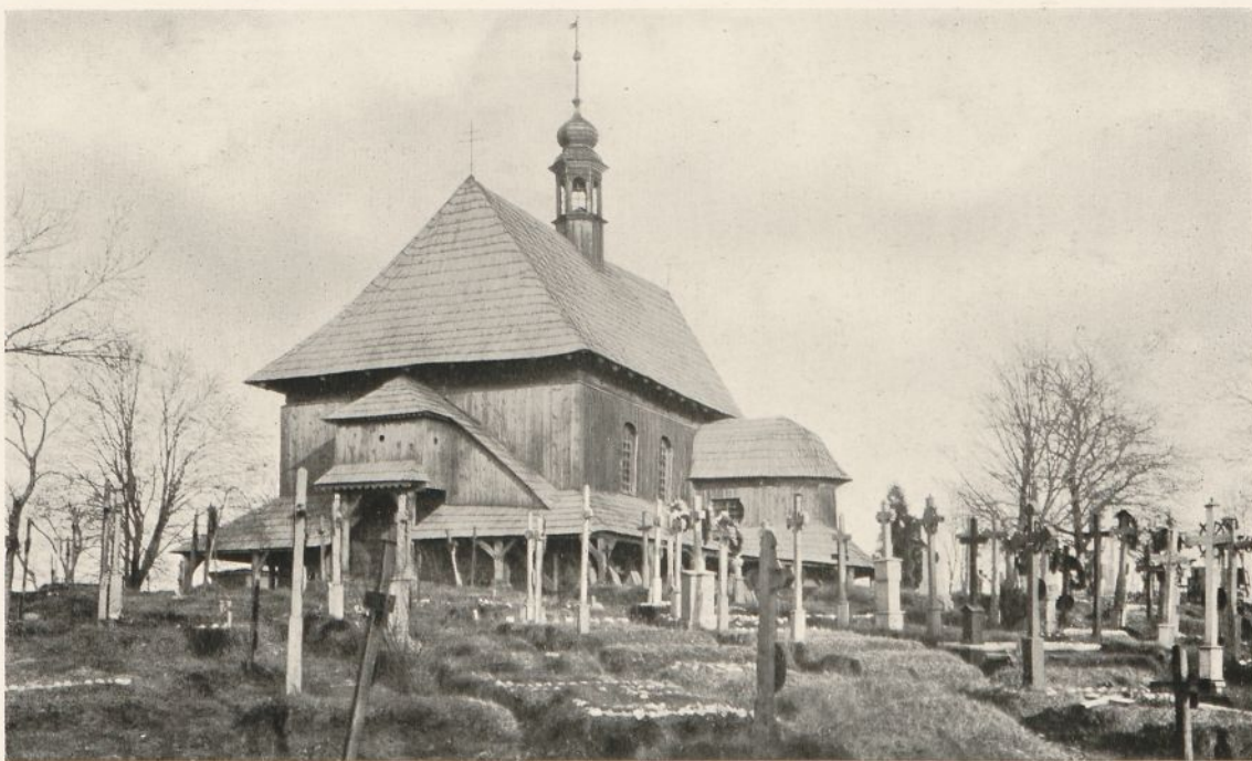
Czarnowanz (O. Schl.). — Wallfahrtskirche, 1684 erneuert
