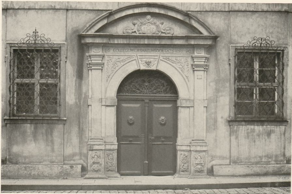
Glatz. — Portal des Gymnasiums, ehemals Jesuitenkollegium 1655—1689 nach Plänen von Karl Luraggo erbaut
