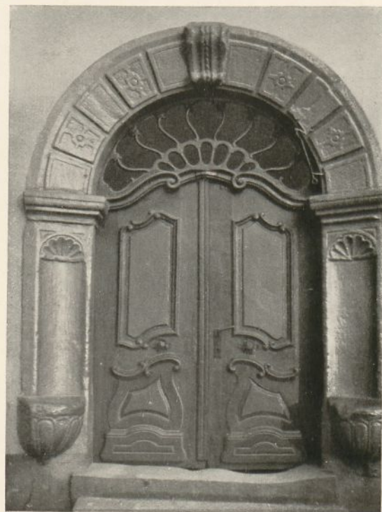
Goldberg. — Portal des Hauses Ring 13
