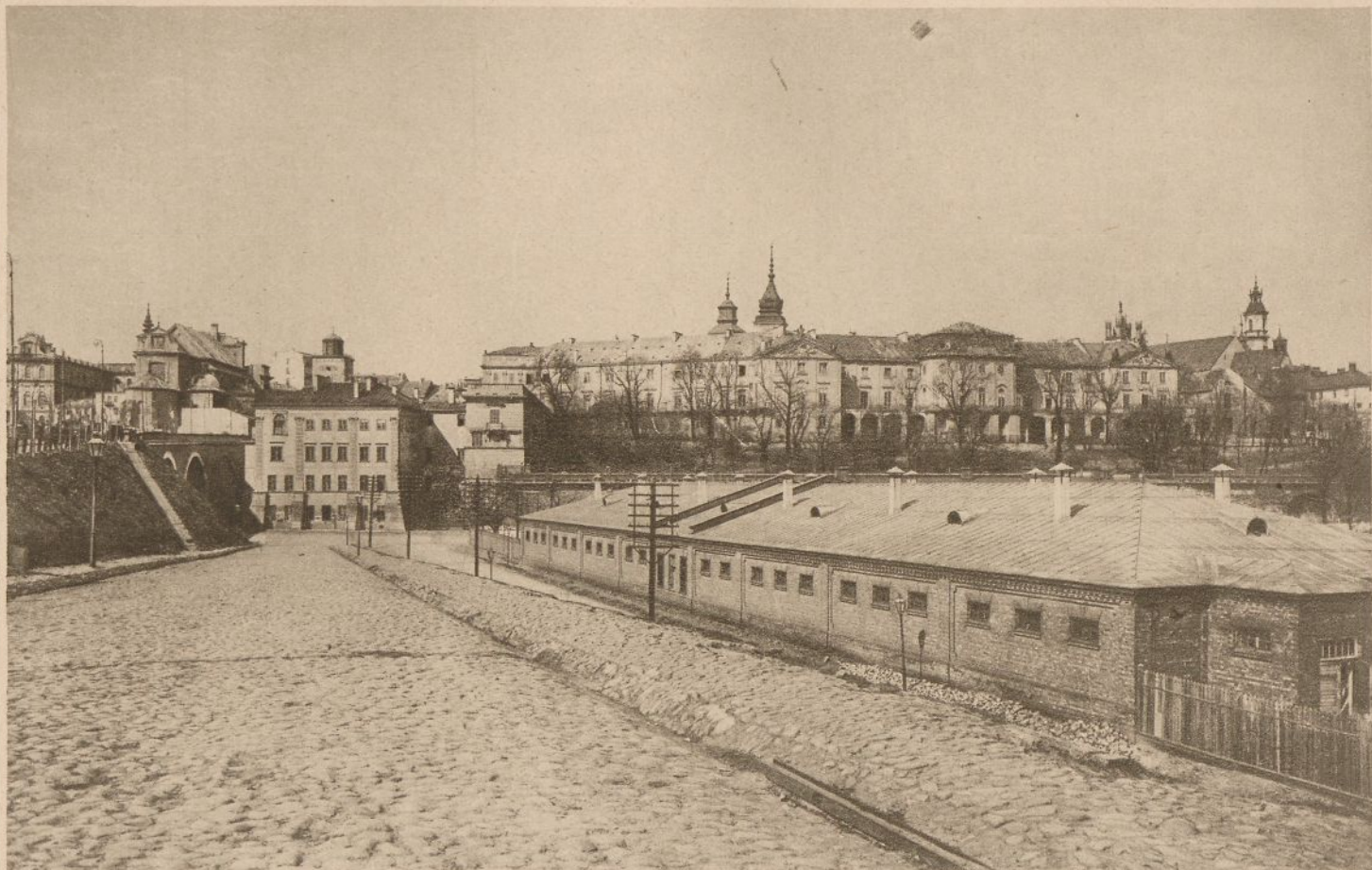
TRZECI WIDOK OGÓLNY ZAMKU KRÓLEWSKIEGO OD STRONY WISŁY
