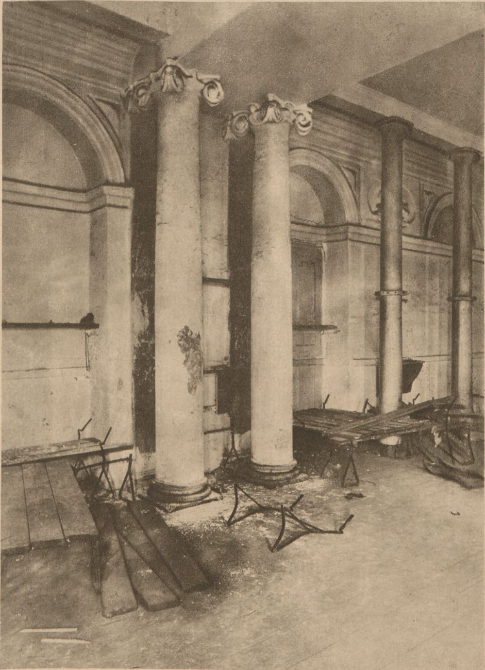
RUINY BIBLIOTEKI PRZED JEJ RESTAURACJĄ
