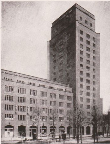
185. Jakob Köfer: Hochhaus am Hansaring in Köln. 1924/25
