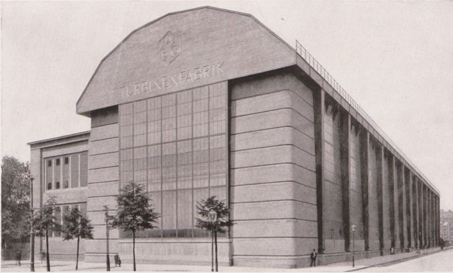
116. Peter Behrens: Turbinenhaus der AEG. in Berlin. 1909
