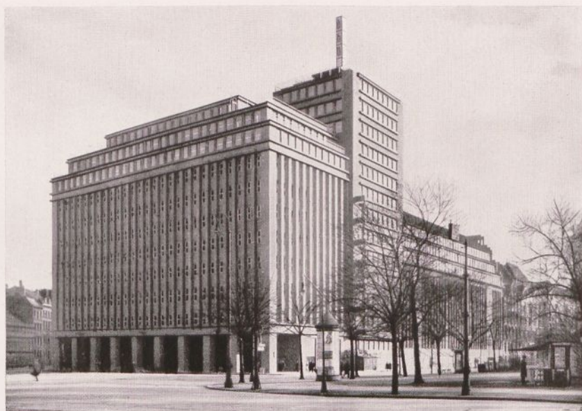
193. Skopp und Vortmann: Gebäude des Deutschnationalen Handlungsgehilfen-Verbandes in Hamburg. 1928
