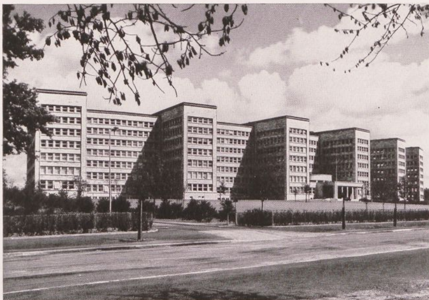
192. Hans Poelzig: Gebäude der I. G. Farben, Frankfurt a. M. 1930
