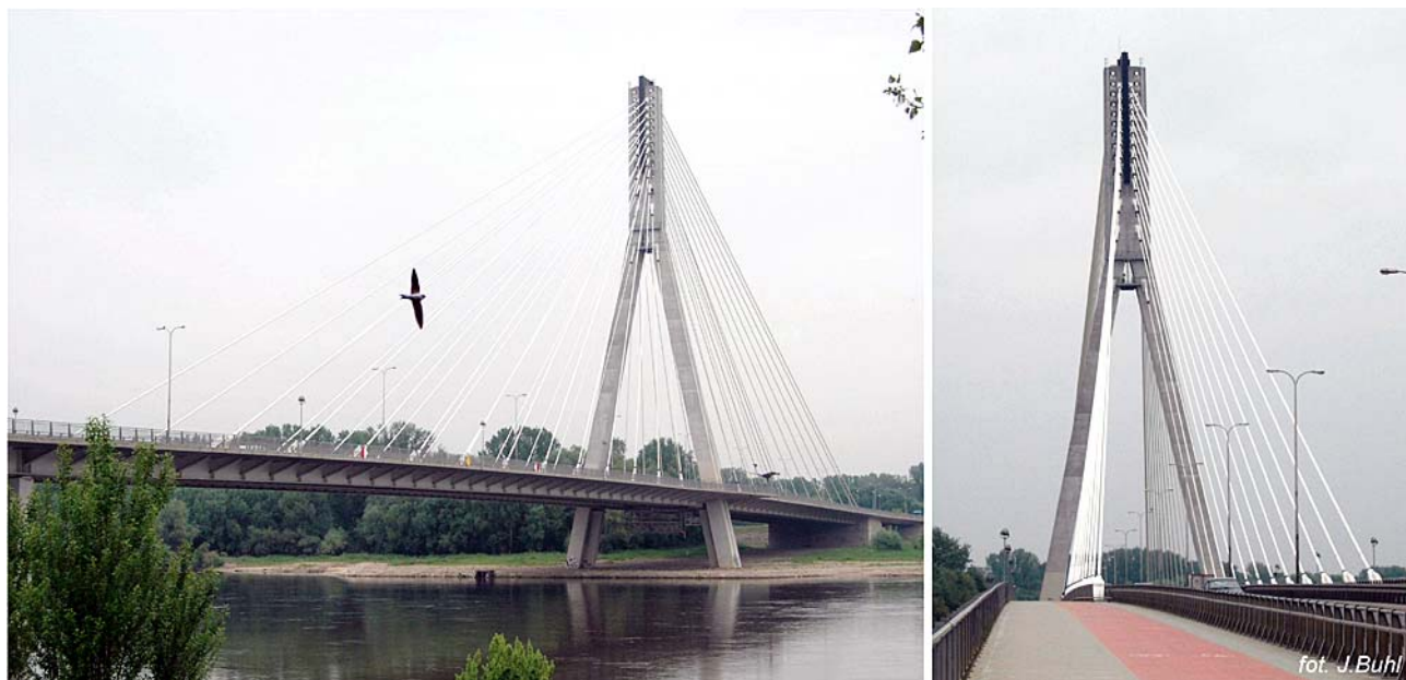
Most Świętokrzyski w ujęciach od strony lewobrzeżnej części Warszawy
