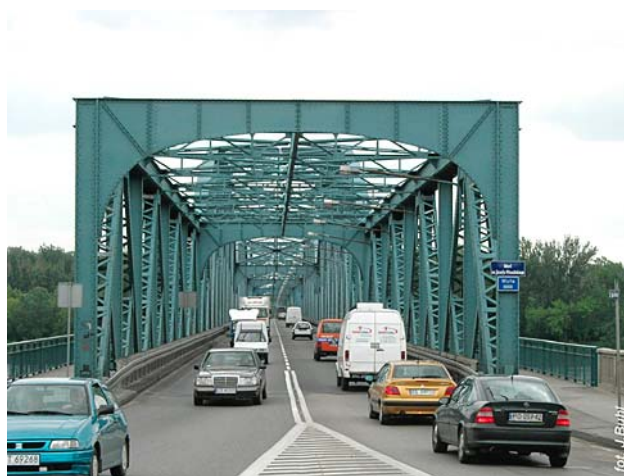
Brama portalowa kratownicowego mostu im. J. Piłsudskiego w Toruniu
