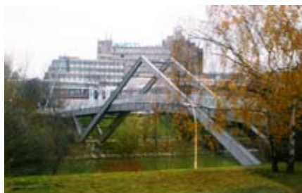
Widok na kładkę dla pieszych Erdberger z drewna klejonego, Wiedeń
