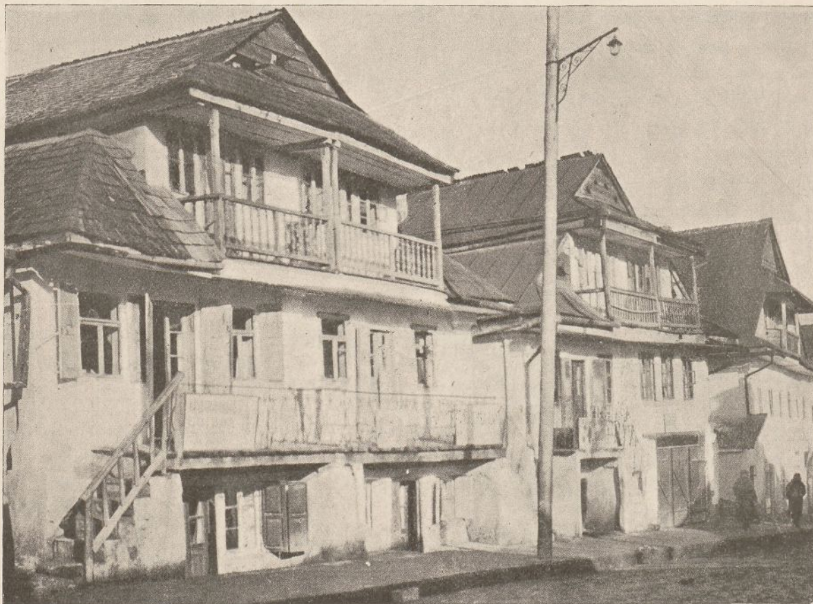
Wiz: 129. Domy w Krzemieńcu z gankami, u góry trzystupowymi, od strony ulicy. Ciesiołka w szczegółach bardzo zniszczona i przy naprawach zastępowana słupami bez ozdób żadnych. Założenie atoli całości i rozkład brył ogromnie malowniczy. Okaz jeden z najpiękniejszych w Polsce. (Zdjęcie własne: J. S. Z.)
