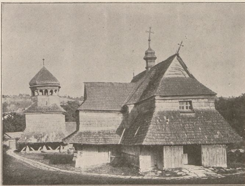
Wiz: 159. Widok cerkwi drewnianej na Czortkowie Starym, tuż koło Czortkowa nad Seretem. Budowla niema kopuł żadnych. Dzwonnica jest wzorem wieży baniastej. Na przedzie cerkwi dwa okienka „w kątomir“.
