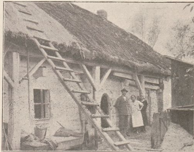
Wiz: 214. Dom „z przyźbą” to jest ze słupami mieczowanymi a oddalonymi od ściany o grubość słupa. (Grzegórzki, koło Krakowa). Zdjęcie własne.
