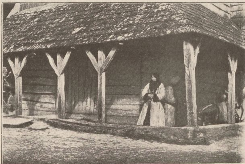
Wiz: 158. Sobótki dookoła cerkwi w Tłustém na Podolu. Mieczowania nie na czopy, lecz na nakładki w ogón jaskółczy.
