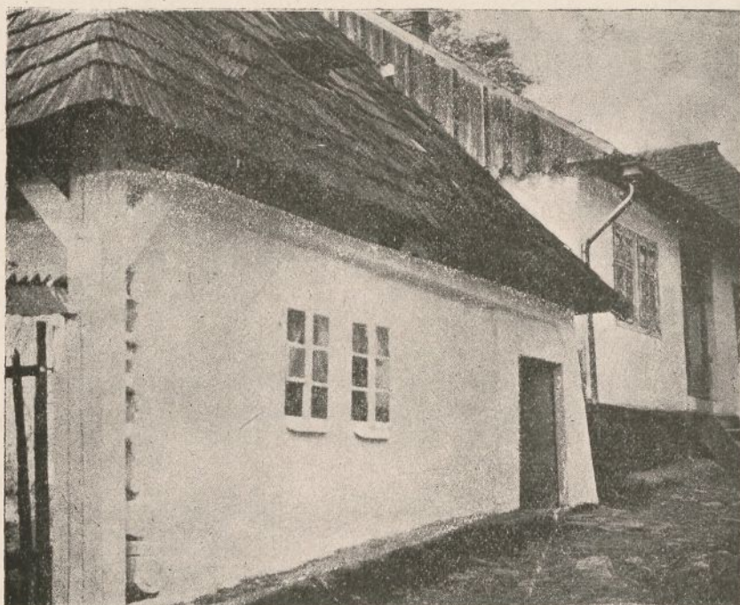
Wiz: 42. Dom rodzinny Ks. Bronisława Markiewicza w Próchniku, koło Przeworska. Przykład doskonały słupów mieczowanych, przyłapu staropolskiego. Ściany wieńcowe wzmocnione słupami „przyłapu“.
