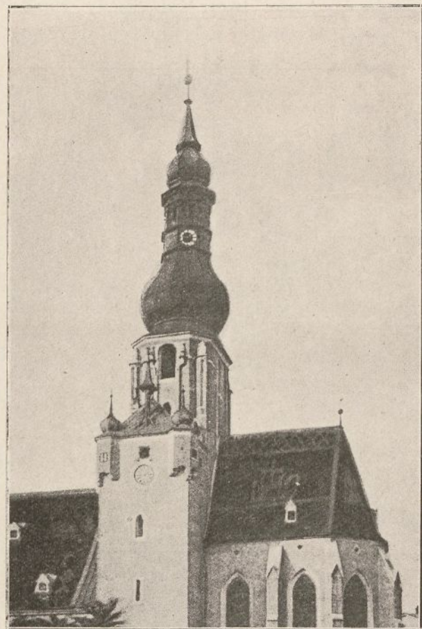
Wiz: 174. Zwieńczenie wieży baniastej na kościele parafjalnym w Badenie koło Wiednia. Kopuła szesnastoboczna dołem, górą ośmioboczna — z krawędziami po osiach.
