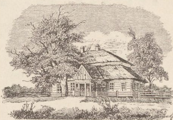
Rys: 210. Dom rodzinny Tadeusza Kościuszki (Mereczowszczyzna) — przed odnowieniem. Dach dwoisty, ze ścianką kolankową w połowie wysokości. Ganek cztero-słupowy.
