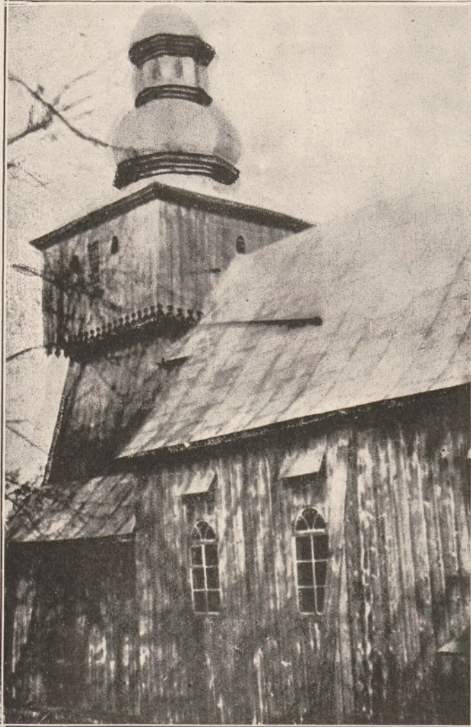
Wiz: 172. Kościół drewniany w Rogowie koło Dukli, na Podkarpaciu. Wieża z dzwonnica nadwieszoną koronkowo i z banią o krawędziach po osiach głównych i przekątniowych.
