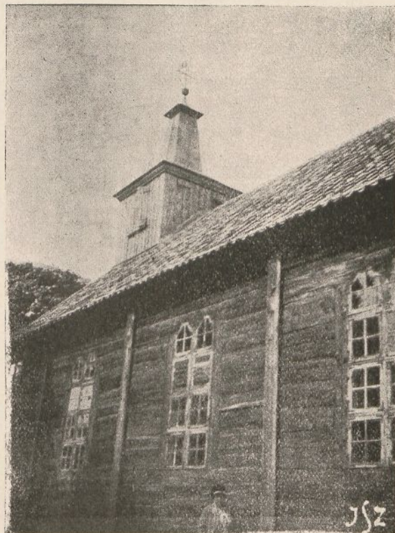
Wiz : 43. Kościół drewniany w Jastarni koło Heli. Okno czyste polskie podwójnie dwudzielne w kierunku poziomym, zaś poczwórnie dwudzielne w kierunku pionowym. Pola pojedyncze wedle „Kątomira“.
