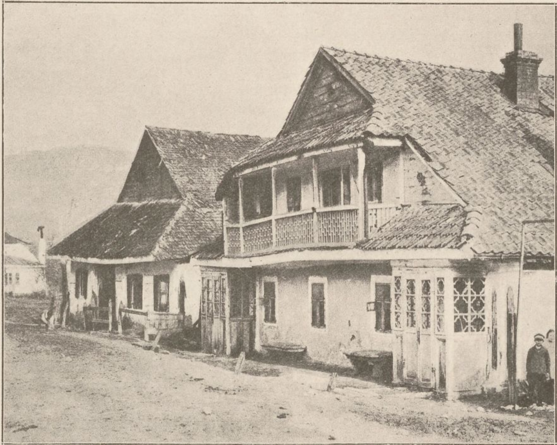
Wiz: 184. Domy w Krzemieńcu. Dom pierwszy z gankami dwoma u dołu i z gankiem na piętrze o 5. słupach. Dom dwuganeczkowy. (Zdjęcie własne).
