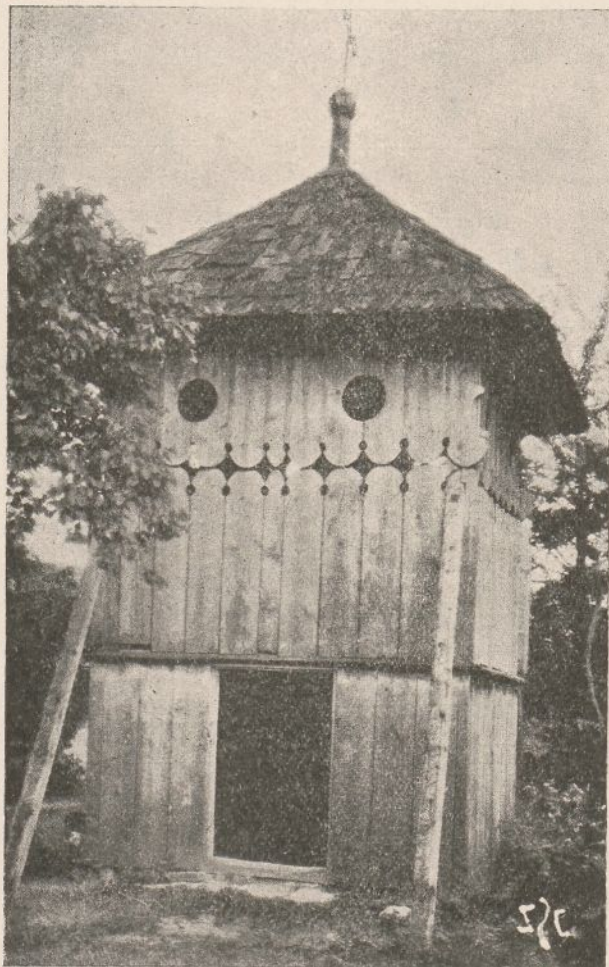
Wiz: 47. Dzwonnica przy cerkwi w Zaleszczykach nad Dniestrem. Okienka na zasadzie dwudziątu. (Zdjęcie własne).
