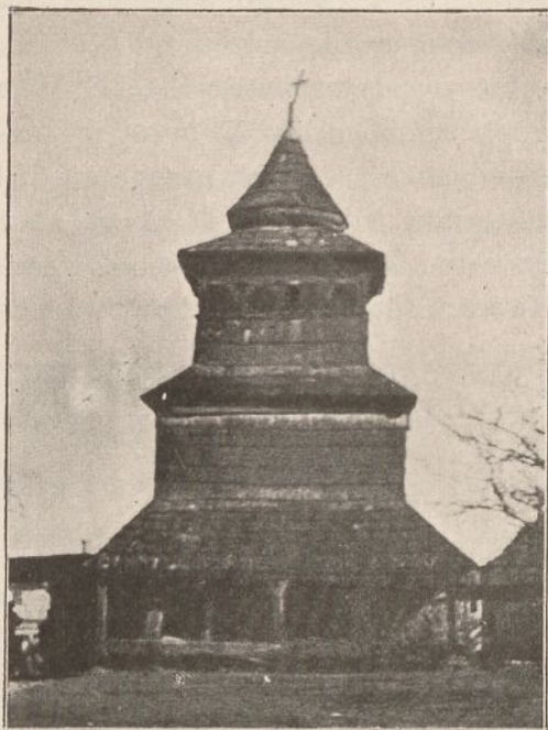
Wiz: 157. Dzwonnica stara obok cerkwi w Tłustém na Podolu, wychodząca z czwartaka 9-słupowego u dołu. Górą zwieńczenie opiera się o ośmiobok, z węglami w osiach głównych i przekątniowych.
