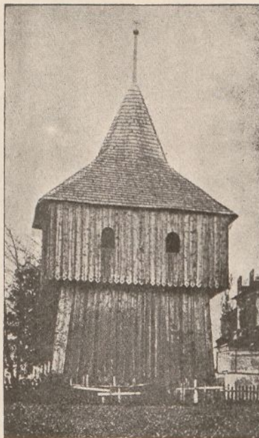
Rys: 130. Dzwonnica z daszkiem ostrosłupowym, ośmiościennym, o krawędziach z osi głównych i osi przekątniowych. (Przy kościele w Beszowej.)
