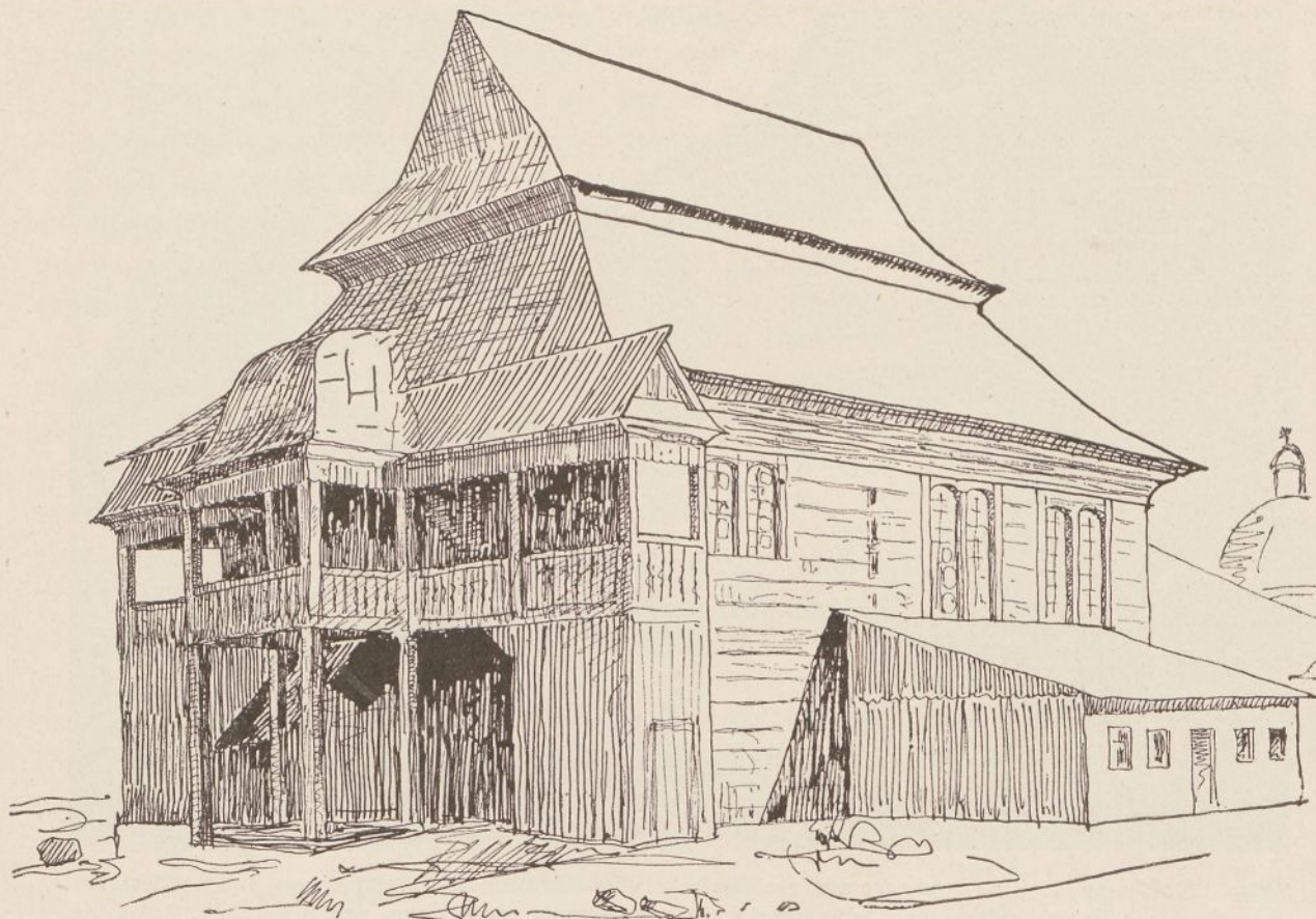
Rys: 128. Bóznica w Kamionce Strumiłowej — drewniana — z dachem polskim „łamanym”, w połowie wysokości pomiędzy okapem a kalenicą — za pochyłością jedną i tą samą. Okna zbliżnione. Ganki piętrowe.
