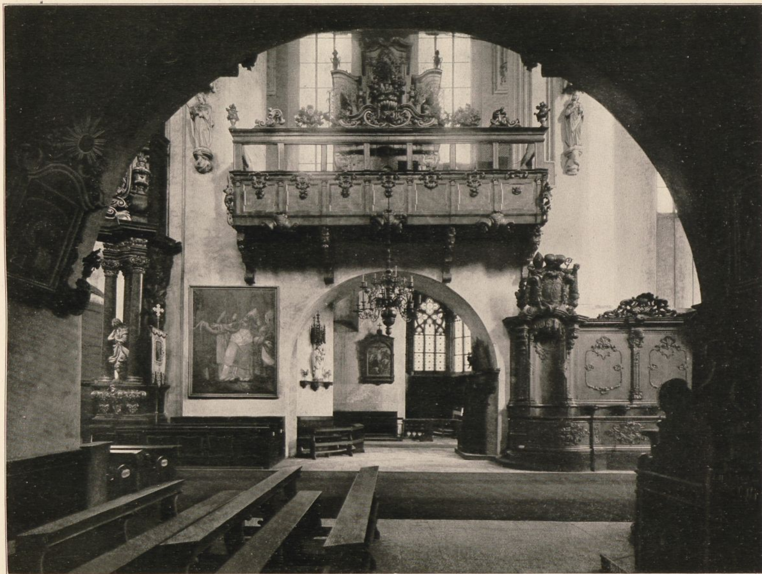
SANDKIRCHE BLICK AUF EMPORE UND CHORGESTÜHL
