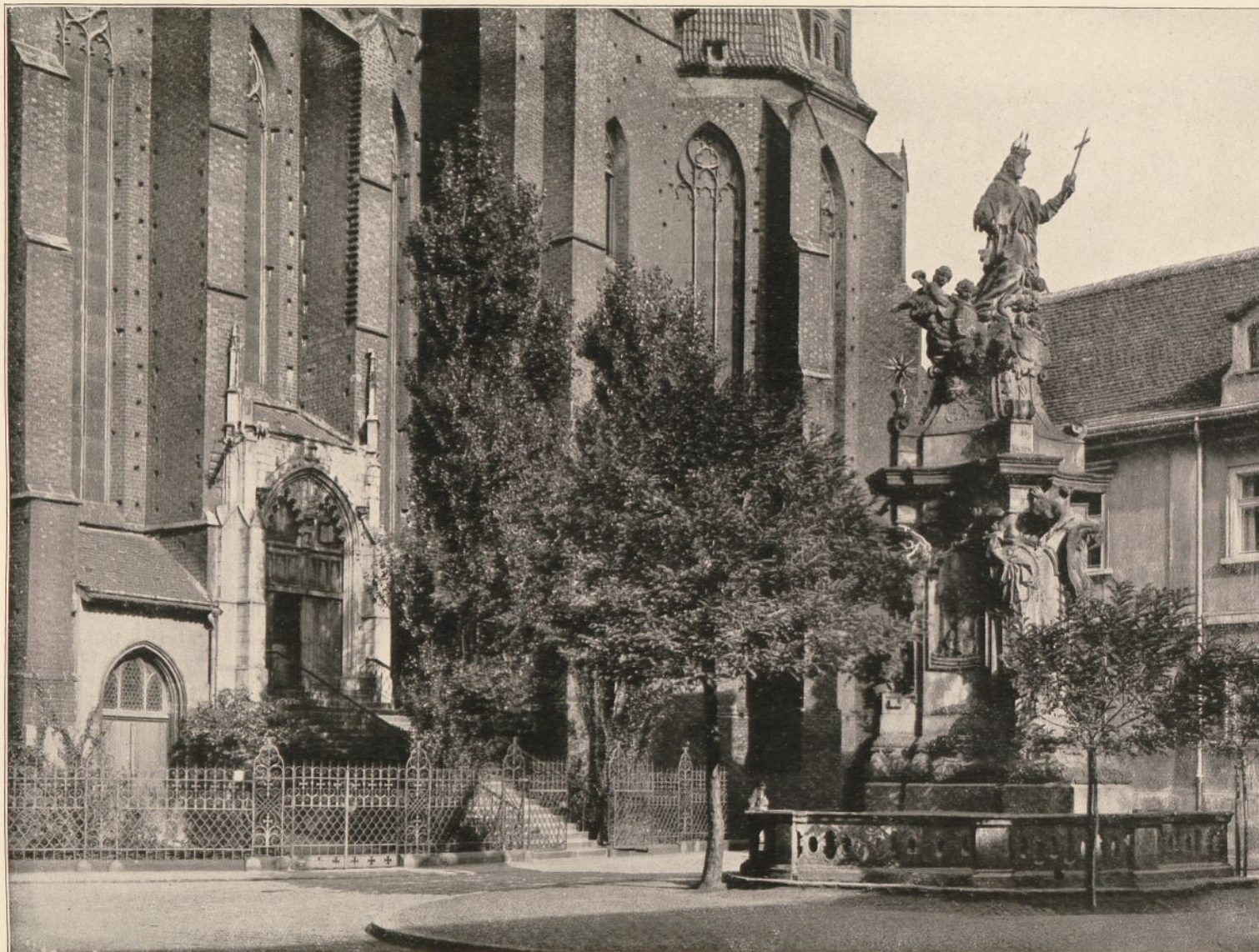
AUFGANG ZUR KREUZKIRCHE UND EINGANG ZUR KRYPTA
