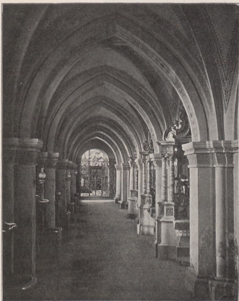
Fig. 97. Mogiła. Widok wnętrza nawy bocznej kościoła klasztornego.
