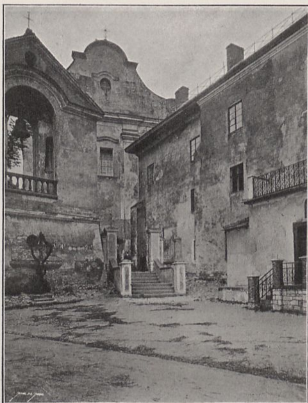
Fig. 128. Morawica. Widok dzwonnicy, kościoła i plebanii od zajazdu.
