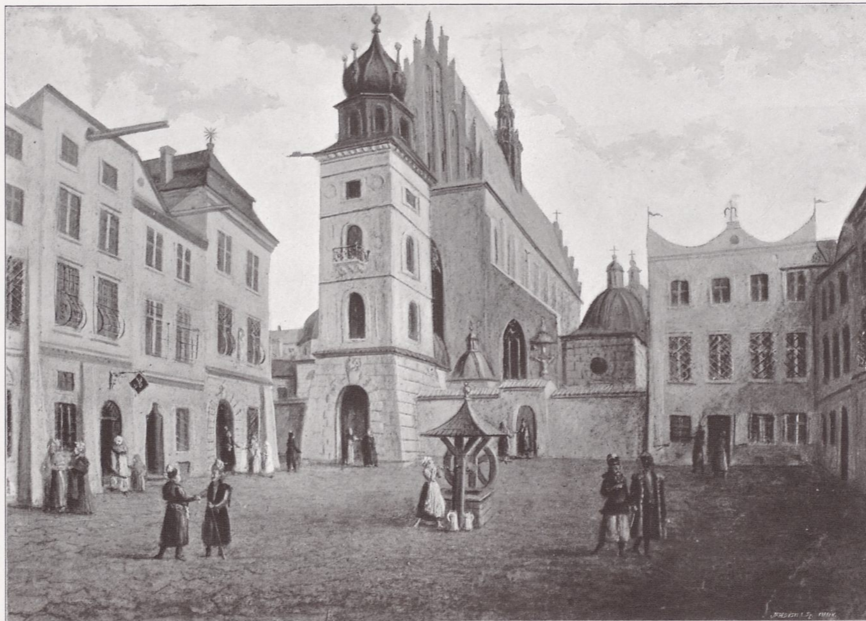
KOŚCIÓŁ ŚTEJ TRÓJCY O.O. DOMINIKANÓW W KRAKOWIE (W POCZĄTKU XIX WIEKU).
