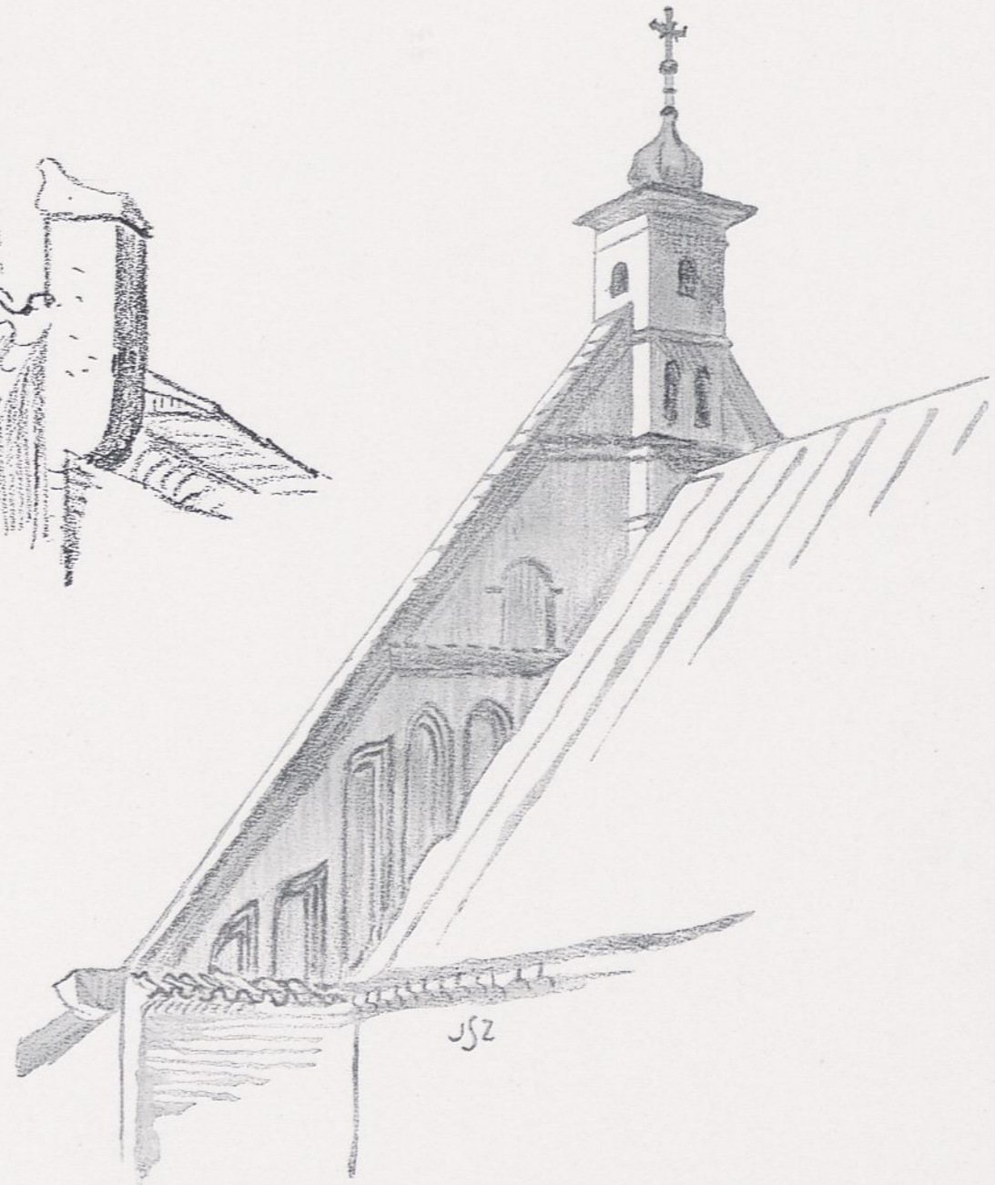
ŚCIANA SZCZYTOWA OD STRONY CZĘŚCI KAPŁAŃSKIEJ Z WNEKAMI PÓŻNO-GOTYCKIEJ I ZE SYGNATURKĄ MUROWANĄ, (WŁAŚCIWĄ W ARCHITEKTURZE NASZEJ) — NA KOŚCIELE PARAFJALNYM W KROŚNIE.
