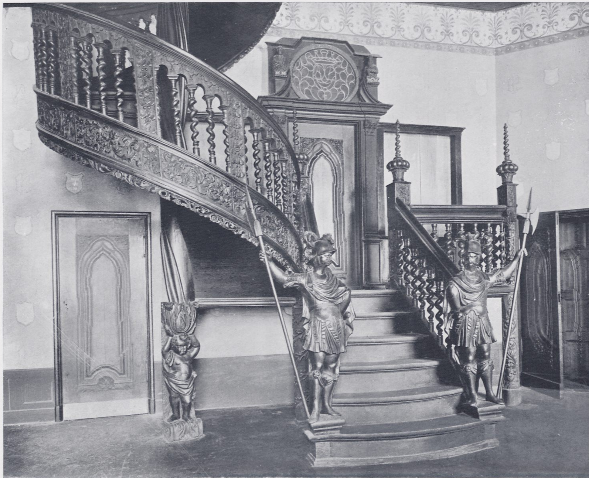
SCHODY I DRZWI GDAŃSKIE W PAŁACU HR. POTOCKICH W KRZESZOWICACH. WIEK XVI I XVII.
