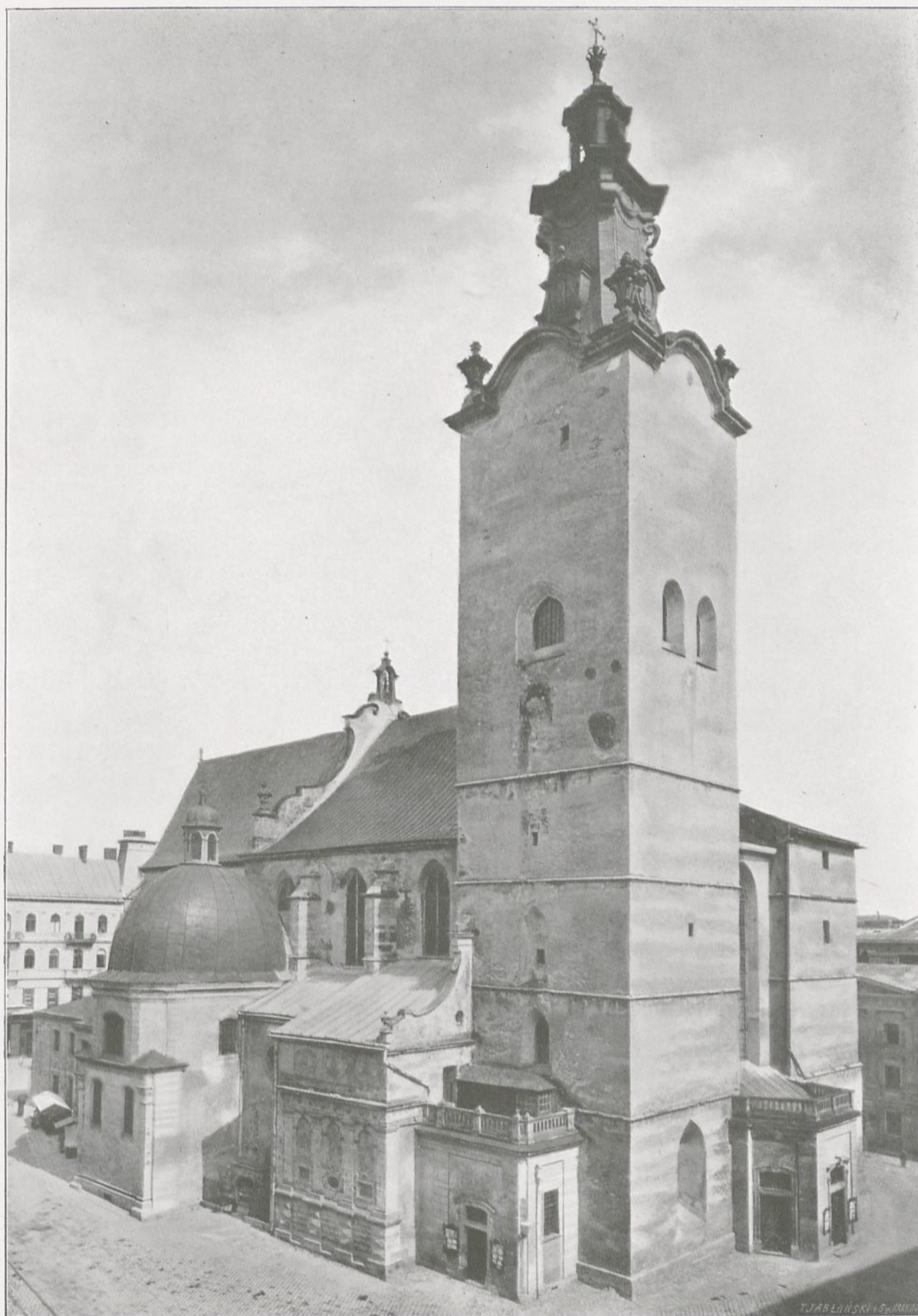
KATEDRA POD WEZWANIEM WNIĘBOWZIĘCIA P. MARJI WE LWOWIE PRZEZ KAZIMIERZA W, w t. 1350. ROZPOCZĘTA I DALEJ PROWADZONA PRZEZ WŁADYSŁAWA JAGIEŁŁĘ. TWÓRCĄ KOŚCIOŁA PIOTR STECHER ÓWCZESNY BUDOWNICZY MIEJSKI. BUDOWĘ UKOŃCZYŁ JOACHIM PROM (GROM) Z WROCŁAWIA W R. 1479. STAN OSTATNI POCHODZI (1760—1776.) Z CZASÓW ARCYBISKUPA W. HIER. SIERAKOWSKIEGO, WEDLE POMYSŁU ARCH. PIOTRA POLEJOWSKIEGO, SYGNATURKA NA SZCZycIE PONAD ŁĘKIEM TĘCZOWYM I OKNA Z ŁASKOWANIEM PROSTOLINIJNEM, NALEŻĄ DO CHARAKTERU NADWIŚLAŃSKIEGO.
