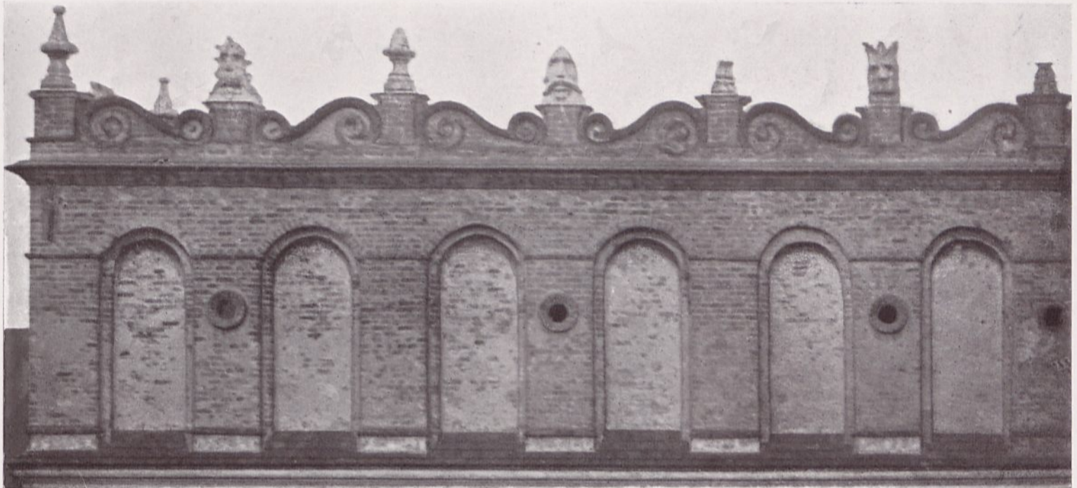
ŚCIANA PRZYCZÓŁKOWA CZYLI ATTYKA Z RATUSZA W TARNOWIE. (DO TABL. LXXIII).
