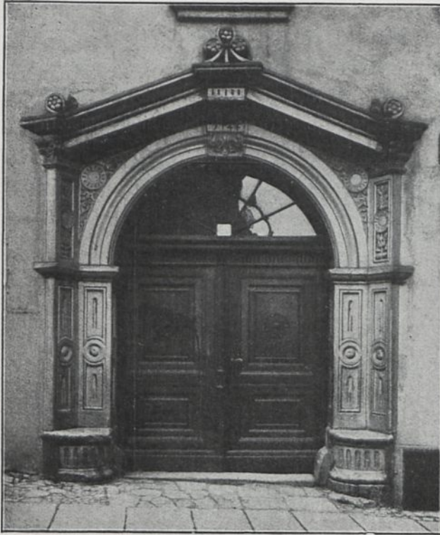
Portal des Hauses Petersstraße 7 in Görlitz.
