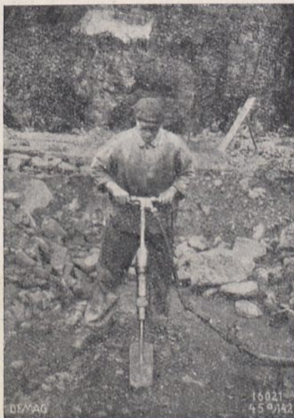
Rys. 27b: Świder mechaniczny „Demag” mniejszy, zastosowany jako łopata do dobywania gruntów cięższych: skok tłoka 105 mm; ilość uderzeń na minutę 1370, porusz. sprężonym powietrzem do 5 atm.
