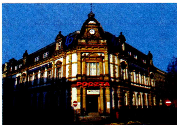
Ryc. 7. Widok budynku poczty. Stan z 2003 r.
