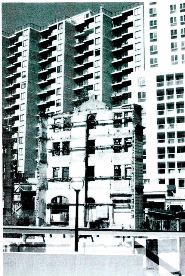
Ryc. 4. Dystopia techniczno-fizyczna: Sydney – budynek mieszkalny w stanie „śmierci fizycznej”
