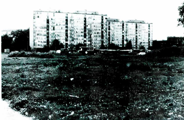
Ryc. 3. Dystopia programowo-funkcyjna: Wrocław – zespół wielorodzinnej zabudowy mieszkaniowej (blokowsko) pozbawiony zagospodarowanych terenów sportu i rekreacji
