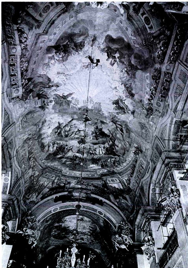
Wnętrze kościoła pw. Imienia Jezus we Wrocławiu Widok na strefę sklepienną
