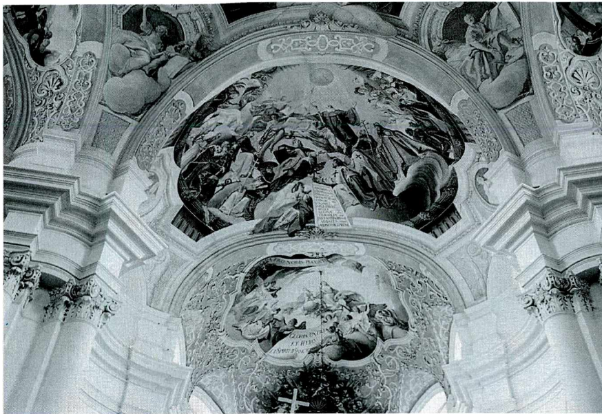
Widok strefy sklepiennej prezbiterium kościoła św. Jadwigi na Legnickim Polu View of the vaulting area in the presbytery of the Church of St. Hedwig in Pole Legnickie
