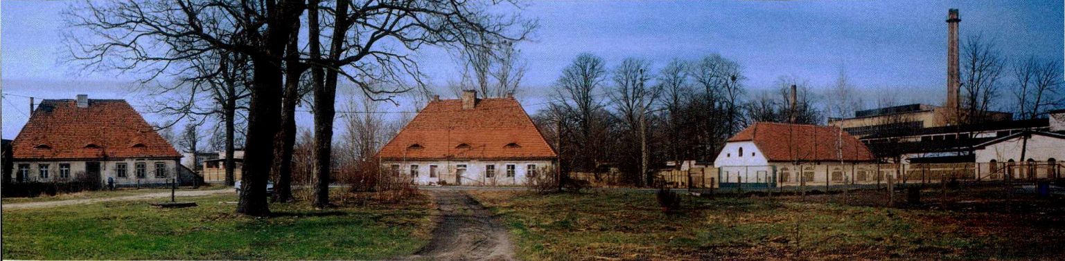
Ryc. 7. Widok ogólny zabudowań huty i dwóch budynków zespołu mieszkaniowego
