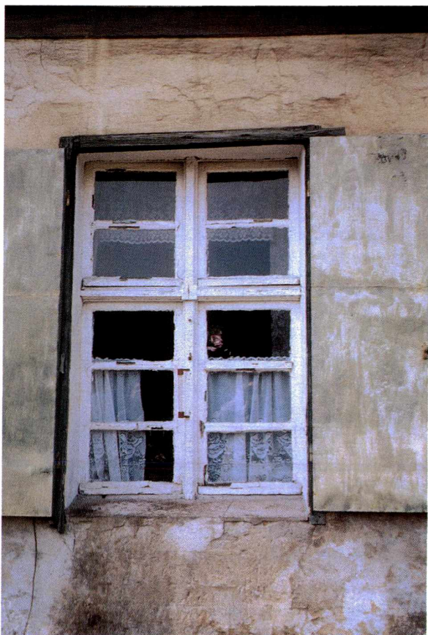
Ryc. 8. Detal okna budynku
