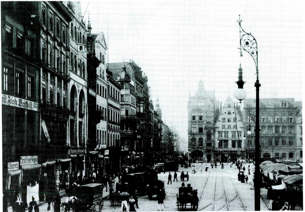
Ryc. 1. Widok wschodniej pierzei Rynku w kierunku ul. Świdnickiej, 1898 r. Na narożniku z Kurzym Targiem dom handlowy Sachssche Haus Fig. 1. View of the east frontage of the Town Square in the direction of Świdnicka street, 1898. At the cross-roads with Kurzy Targ (Hen Market) is the Sachssche Haus department store
