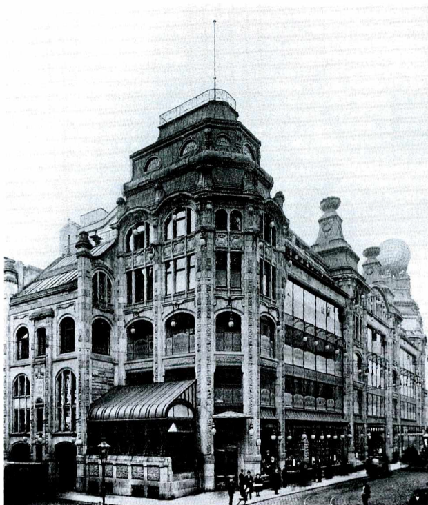
Ryc. 8. Barasch od strony ul. Szewskiej; na pierwszym planie narożne wejście i pawilon z ogrodem zimowym, na parterze widoczne wypukłe witryny i centralne wejście od strony Kurzego Targu. Stan z 1905 r.
