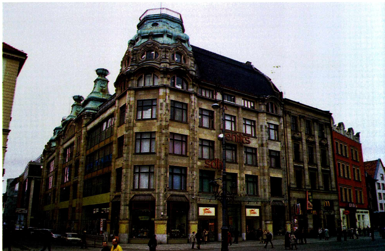
Ryc. 30. Widok narożnika od strony Rynku, po rewaloryzacji elewacji północnej i parteru elewacji zachodniej dokonanych w latach 2000–2002. Stan z marca 2003 r.
