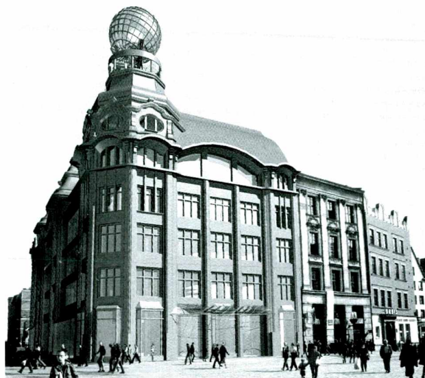
Ryc. 32. Feniks widziany od strony Rynku – po wykonaniu wszystkich planowanych prac
