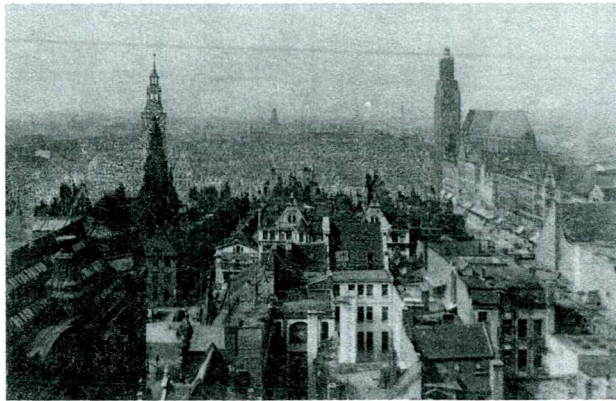
Ryc. 11. Widok wież i dachów, z wielkimi oknami połaciowymi. Globus na narożnej wieży góruje nad otoczeniem. Stan po 1905 r.
