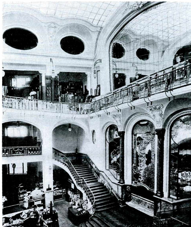
Ryc. 9. Wewnętrzny czteropiętrowy dziedziniec, widok na schody reprezentacyjne i lustrzaną ścianę południową. Stan z 1905 r.
