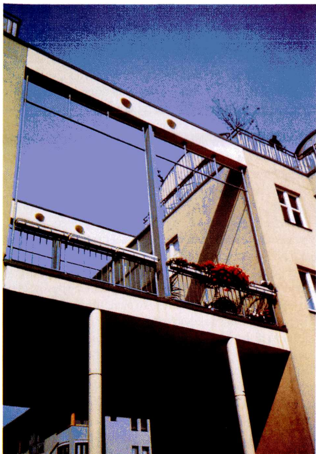
Ryc. 6. Fragment budynku mieszkalnego, Berlin 1982, D. Bangert, B. Jansen, St. Scholtz, A. Schultes Fig. 6. Fragment of a habitation building, Berlin 1982, D. Bangert, B. Jansen, St. Scholz, A. Schultes
