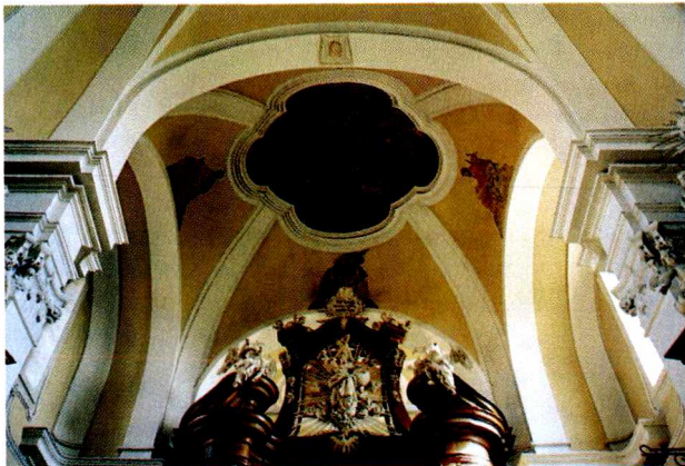
Ryc. 20. Sklepienie prezbiterium Fig. 20. Presbytery vault
