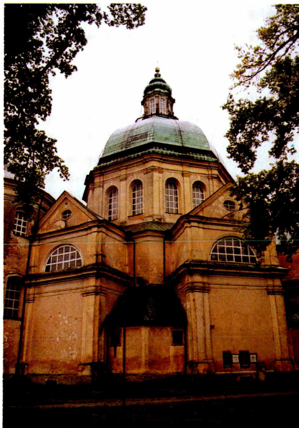
Ryc. 15. Widok od północy Fig. 15. View from the north
