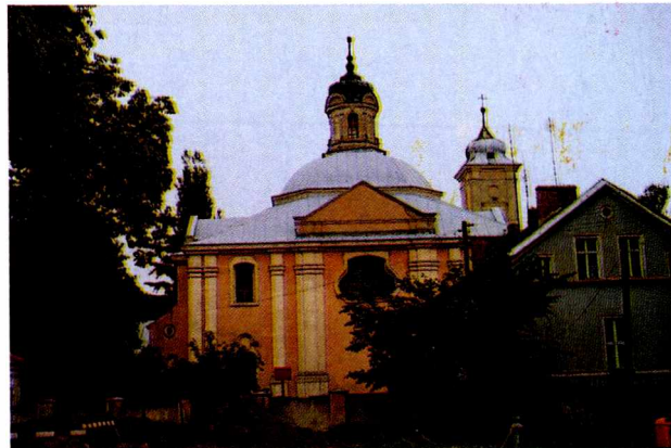
Ryc. 9. Widok od północy Fig. 9. View from the north
