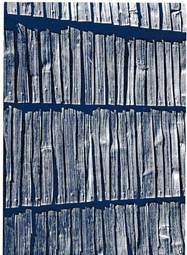
Ryc. 1. Trójboczne zakończenia prezbiterium w kościołach: a) Gręboszów (obecnie Bierkowice) z 1613 r., b) Popielów z 1654 r., c) konstrukcja wieńcowa prezbiterium (Strzelce Opolskie), d) opierzenie ścian (Olesno)
