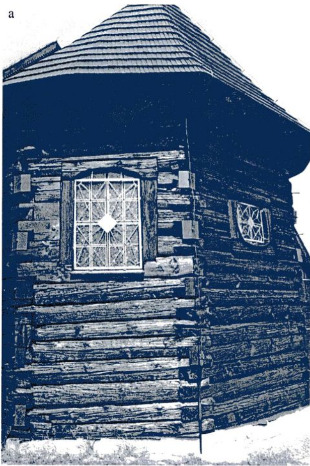
Ryc. 1. Trójboczne zakończenia prezbiterium w kościołach: a) Gręboszów (obecnie Bierkowice) z 1613 r., b) Popielów z 1654 r., c) konstrukcja wieńcowa prezbiterium (Strzelce Opolskie), d) opierzenie ścian (Olesno)
