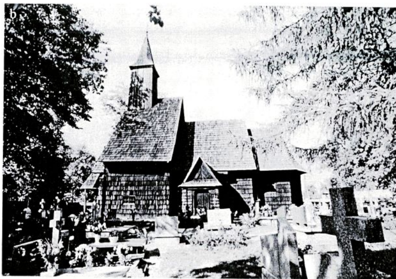
Ryc. 2. Kościoły drewniane o konstrukcji wieńcowej z XV i XVI w.: a) św. Anny z 1518 r. (odpustowy) w Olesnie), b) Narodzenia N.M.P. z ok. 1550 r. (Brzezinki), c) Serca Jezusa z 1580 r., z wieżą z 1773 r. (Proślíce), d) Wszystkich Świętych z 1599 r. (Lasowice Wielkie)
