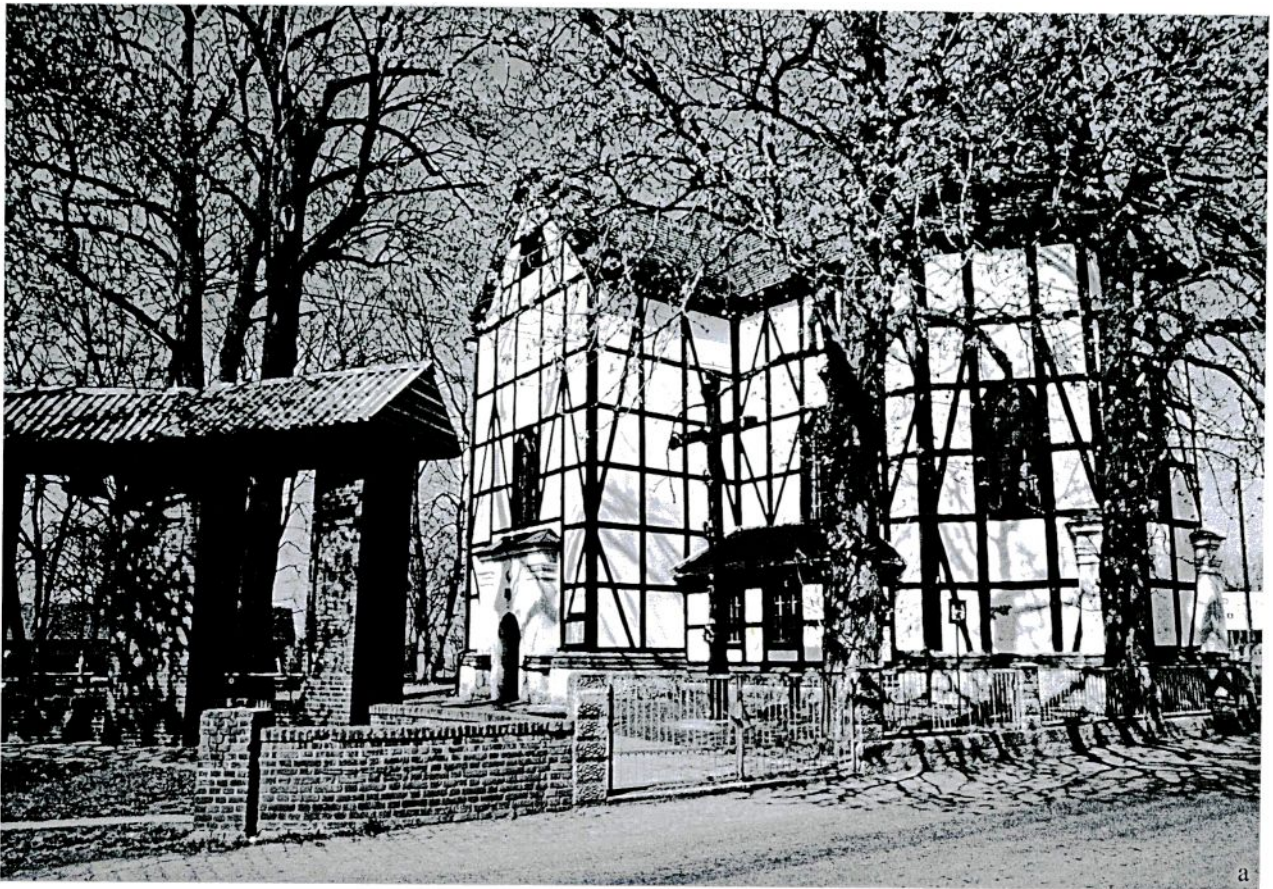
Ryc. 5. Kościoły o konstrukcji mieszanej: a) ryglowy protestancki z l. 1719–1722 (Wierzbica Górna), b) murowany, z ryglową wieżą (Kościerzycy), c) wieńcowo-ryglowy z XVI w. (Obórki)
