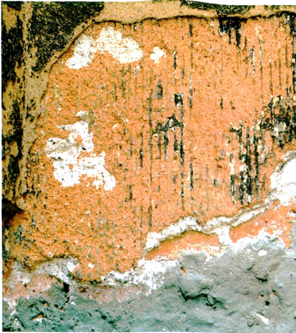
Ryc. 1. Fragmenty tynków barwnych odkryte na elewacjach barokowych kaplic św. Elżbiety i Bożego Ciała – Elektorskiej (po prawej u dołu, fot. autora)
