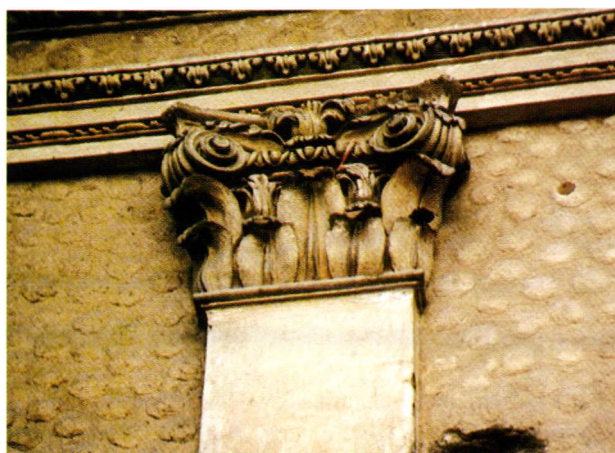
Ryc. 7. Kłasztorek w Kamieńcu Żąbkowickim. Fasada. Głowica pilastra i fragment ściany z widocznym krążkowym narzutem tynkowym
