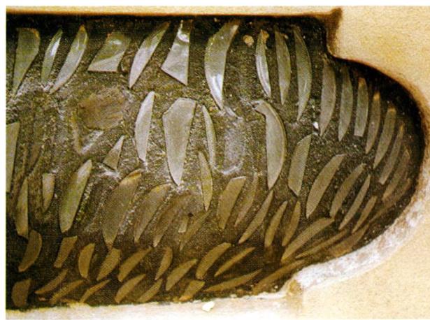
Ryc. 6. Kłasztorek w Kamieńcu Żąbkowickim. Fasada. Fragment płyciny pod oknem pierwszego piętra
