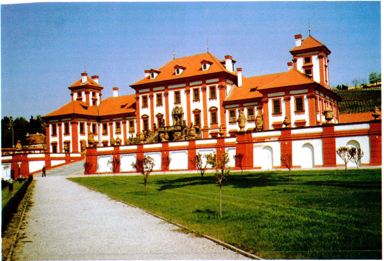
Ryc. 8. Pałac Troja w Pradze. Kolorystyka elewacji
