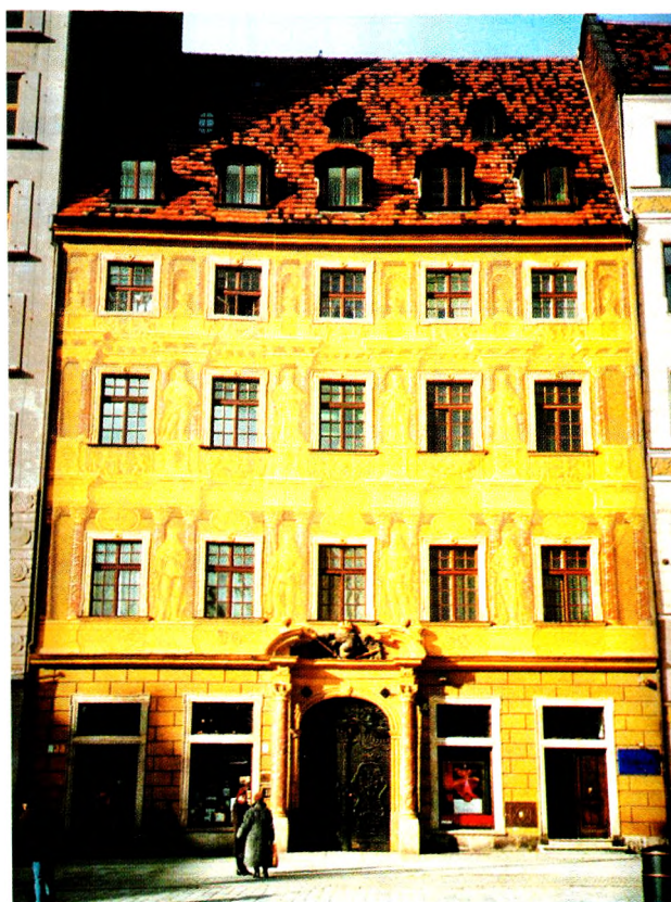
Ryc. 14. Kamienica przy Rynku nr 8 Pod Elektorami we Wrocławiu. Fasada
