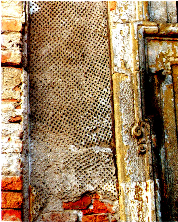
Ryc. 4. Klasztor w Lubiążu. Fragment dziurkowanej faktury tynku na elewacji
