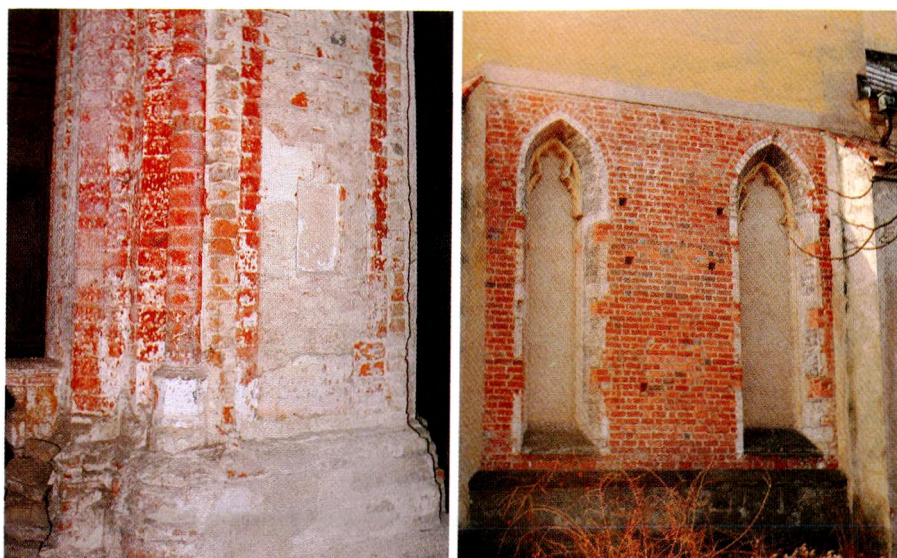
Ryc. 4. Lubiąż. Kościół klasztorny – fragment filara nawy po odpadnięciu tynków. Z prawej – resztki na biało malowanych ościeży okiennych na zewnętrznej elewacji chóru (fot. autora)
