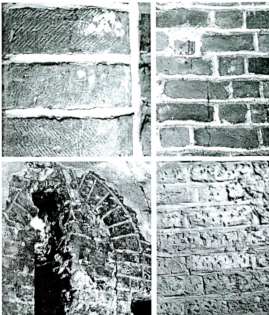
Ryc. 1. Wrocław. Relikty dekoracji i korekty lica murów ceglanych: Katedra – szrafowane lico cegieł; kościół św. Klary – biało podkreślone spoiny; tzw. Dom Panien Trzebnickich – poprawki białych spoin łęku nadproża; kościół św. Bernarda – jednolicie zabarwione czerwienią lico ścian, nadziobane pod późniejsze tynki (fot. autora)
