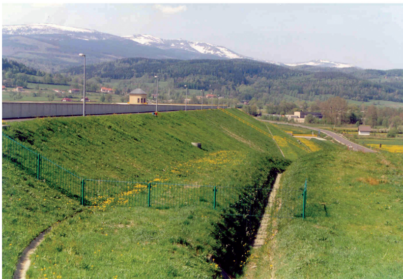
Fot. 3.7. Rów opaskowy zapory ziemnej zbiornika wodnego Sosnówka (fot. H. Orzeszyna, 2002) Phot. 3.7. Drainage ditch of earth dam of Sosnówka reservoir (phot. H. Orzeszyna, 2002)
