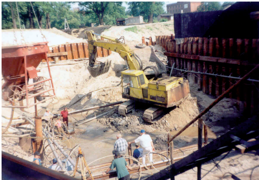
Fot. 3.8. Wykop ziemny pod małą elektrownię na rzece Bóbr w Szprotawie (fot. T. Molski, 1992) Phot. 3.8. Earth cut under low power station at the Bóbr River in Szprotawa (phot. T. Molski, 1992)
