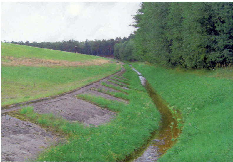
Fot. 3.6. Rów opaskowy zapory ziemnej zbiornika wodnego w Kobylej Górze (fot. T. Molski, 2006) Phot. 3.6. Drainage ditch of earth dam of reservoir in Kobyla Góra (phot. T. Molski, 2006)
