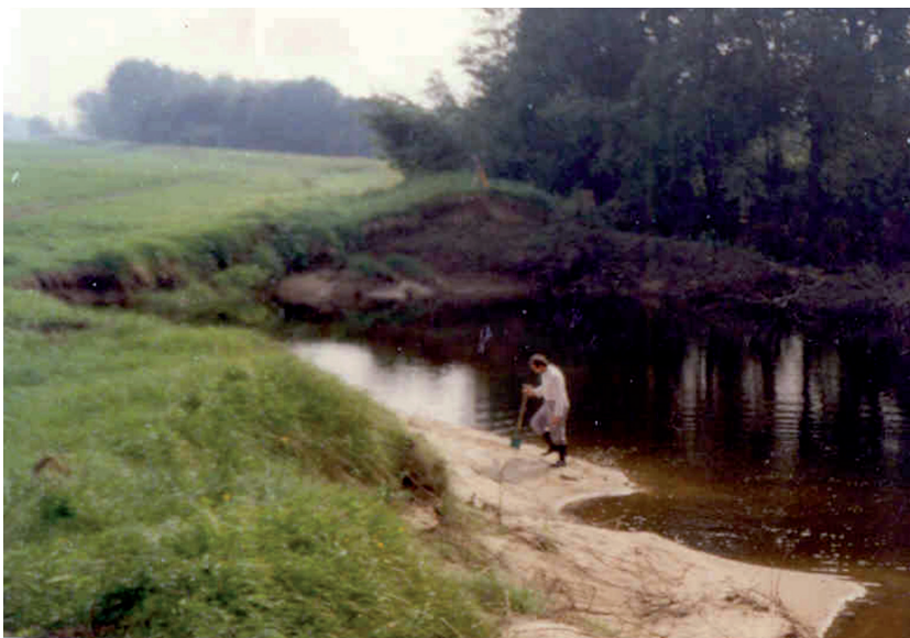
Fot. 3.2. Wał przeciwpowodziowy rz. Oławy w Oławie (fot. H. Orzeszyna, 1997) Phot.2. The embankment of Oława River in Oława (phot. H. Orzeszyna, 1997)
