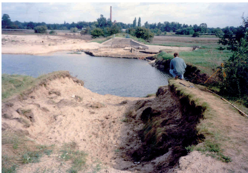
Fot. 3.1. Wał przeciwpowodziowy rz. Oławy we Wrocławiu (fot. H. Orzeszyna, 1997) Phot. 1. The embankment of Oława River in Wrocław (phot. H. Orzeszyna, 1997)
