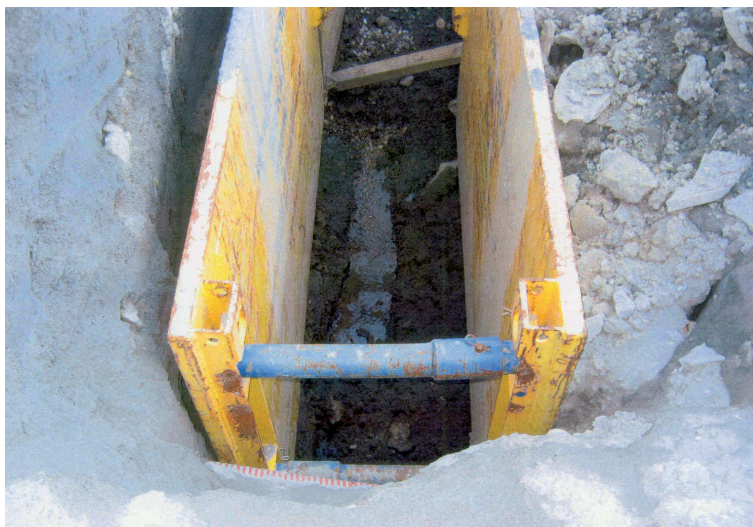
Fot. 3.9. Wykop ziemny pod sieć wodno-kanalizacyjną przy ul. Zatorskiej we Wrocławiu (fot. T. Molski, 2008)
