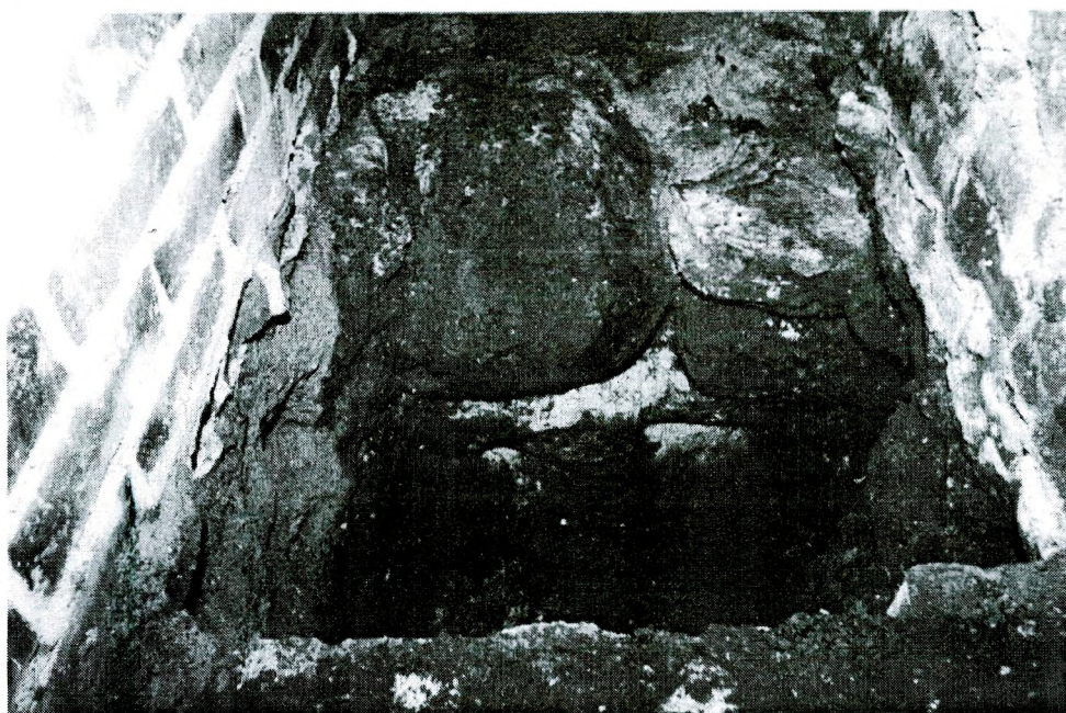
Ryc. 7. Katedra wrocławska. Fragmety murów fundamentowych drugiej i trzeciej budowli katedralnej (fot. E. Małachowicz)
