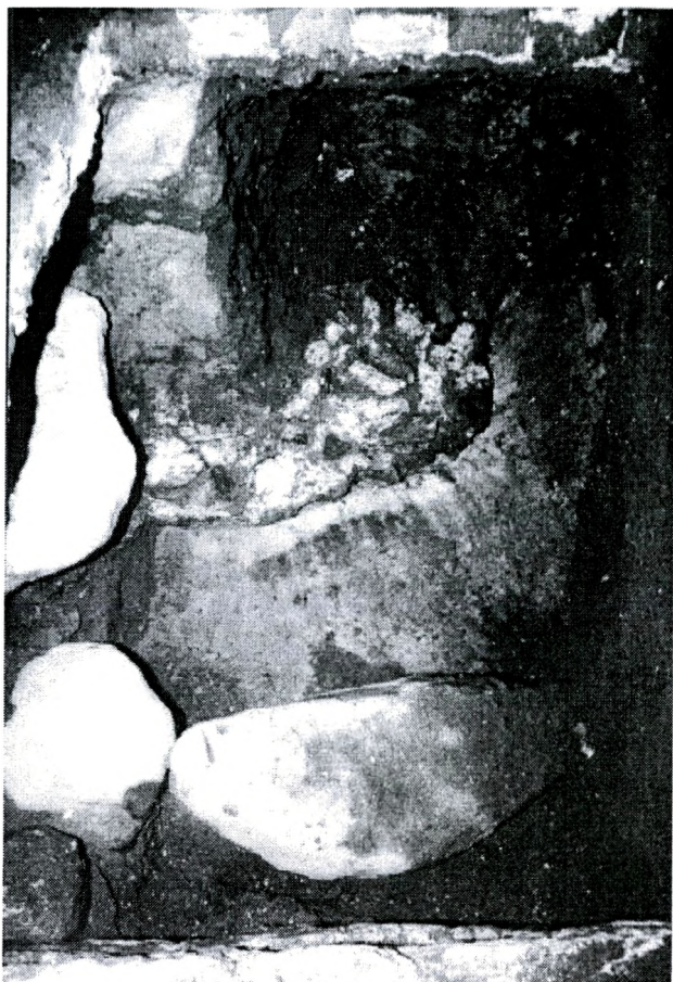
Ryc. 15. Katedra wrocławska. Fragment muru fundamentowego południowego ramienia kościoła z X wiku (fot. E. Małachowicz)
