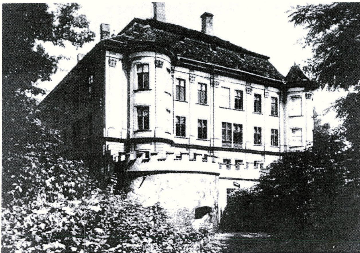
Ryc. 8. Widok pałacu od południowego zachodu wg Junga [20, s. 102]
