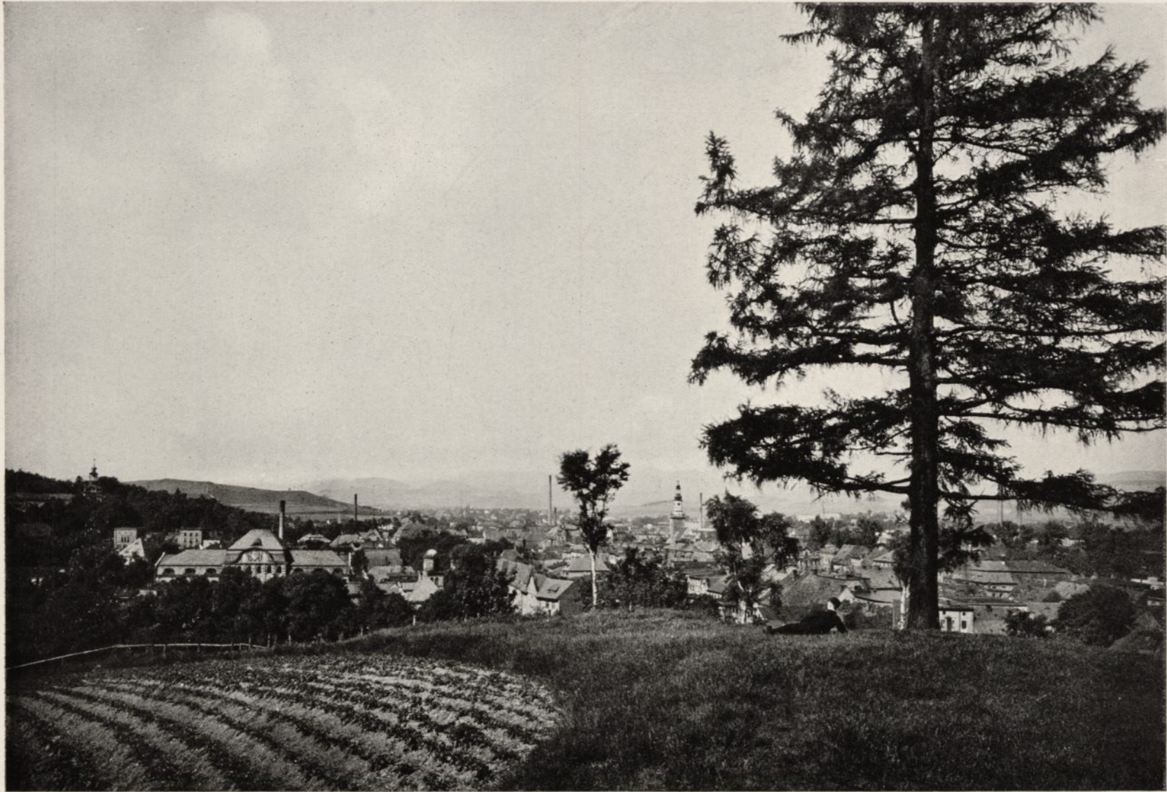
Gesamtansicht von Landeshut vom Burgberg aus (das Geschäftshaus links)
