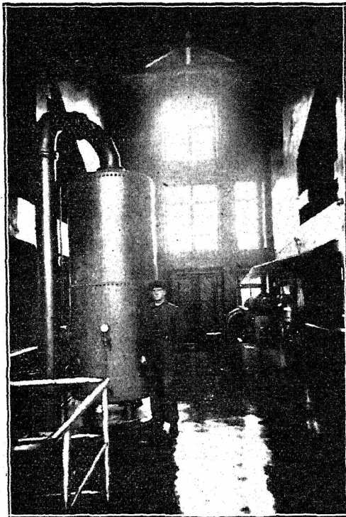
Chodnik środkowy filtrów z utleniaczem i dmuchawą do mechanicznego płókania.
