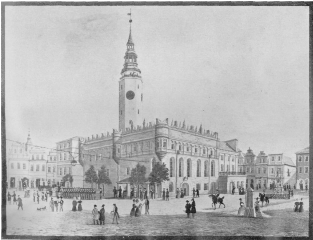
67. Leobsdorf, Rathaus vor dem Umbau von 1863/64
