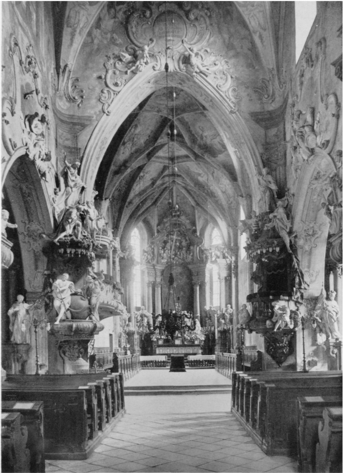
114. Oberglöckau, Kath. Pfarrkirche, Ansicht gegen O
