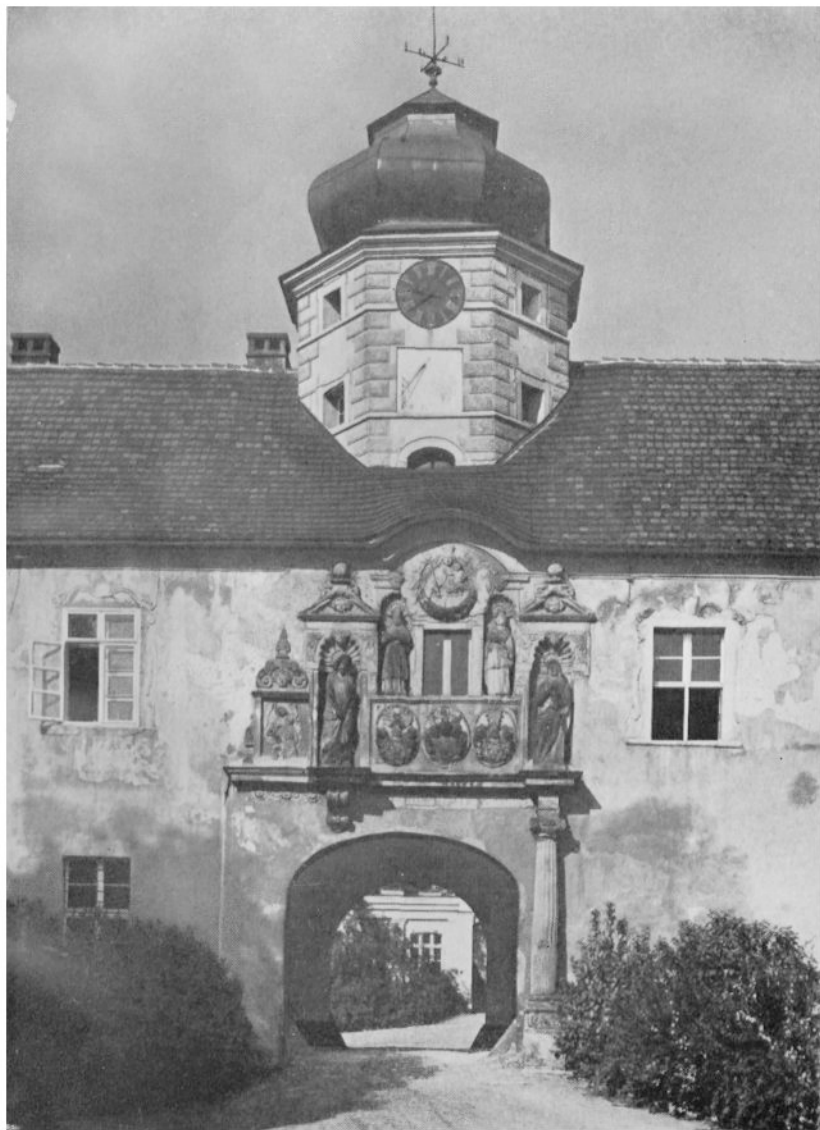
81. Oberglöckau, Tor des Unterschlusses
