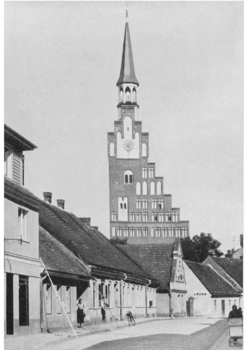
10. Falkenberg, Kath. Pfarrkirche, Westfassade
