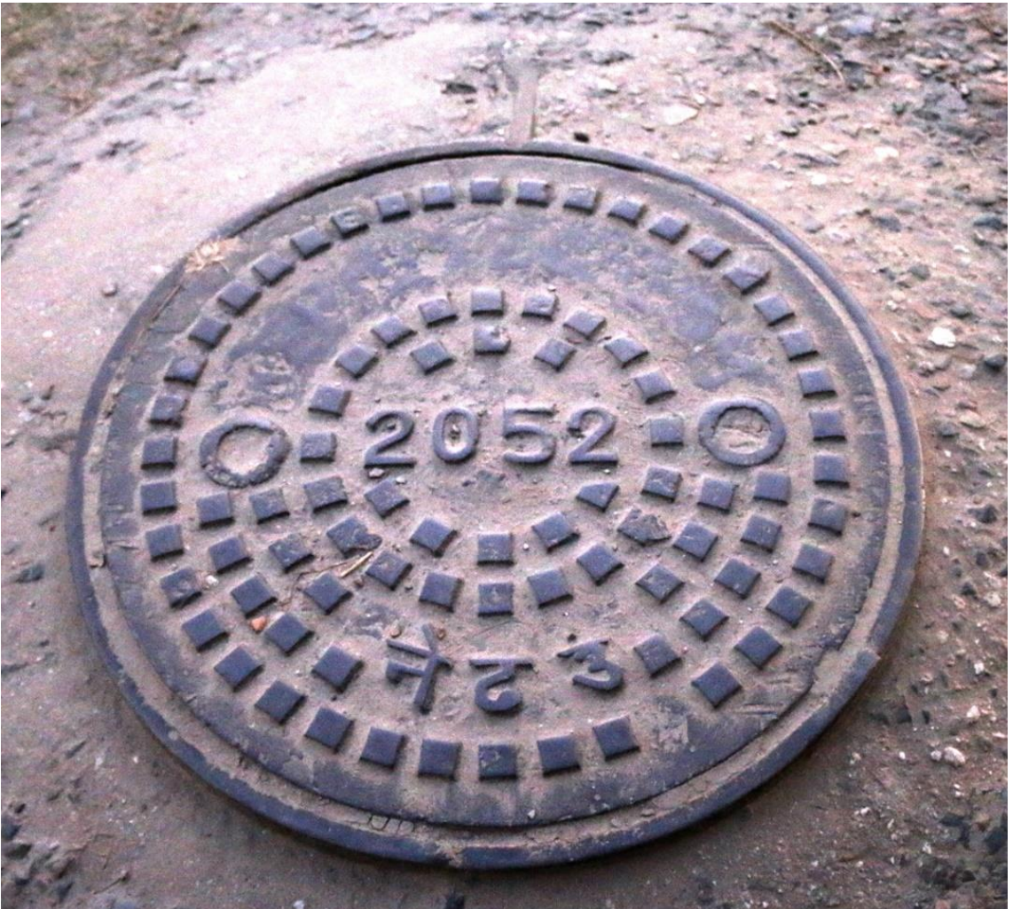
Fig. 3. Manhole in Katmandu, Nepal. M. Flisykowska 2016
