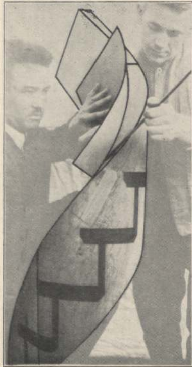
Abb. 872. Ermittlung der oberen, inneren Schwungschablone.
