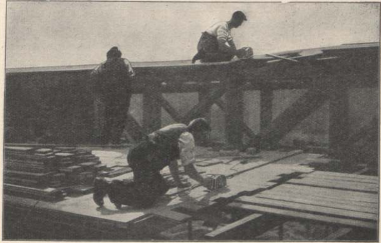
Abb. 1056. Die elektrische Handkreissäge im Betrieb.
