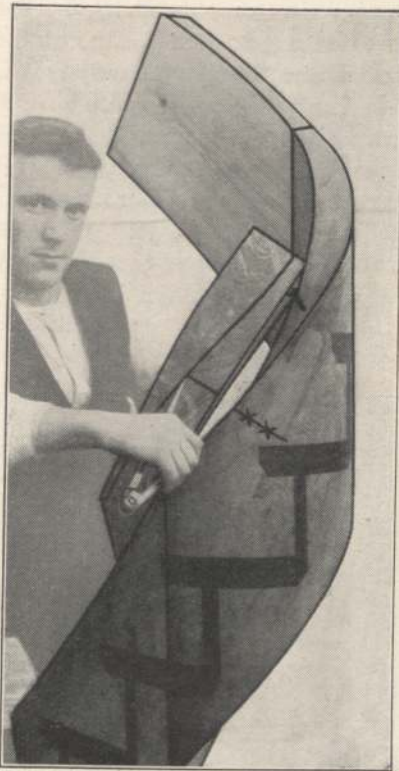
Abb. 868. Der untere Krümmling ist nach der Papierschablone (s. Abb. 866) ausgesägt und auf das Kropfstück aufgelegt. Der Geländermacher wendet die seitliche Winkelverkantung an (beachte die rechtwinklige Zirkelstellung).
