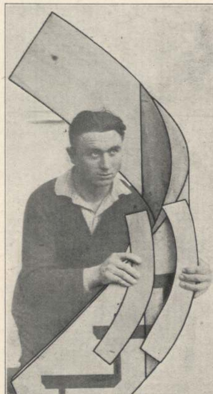
Abb. 867. Die in Abb. 865 und 866 ermittelte Brett- bzw. Papierschablone nebeneinander liegend. Wie ersichtlich, ist die Papierschablone (in der rechten Hand des Geländermachers) etwas runder (krümmter).
