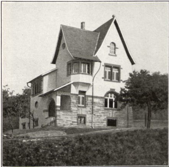
PROF. HEINRICH METZENDORF -BENSHEIM LANDHÄUSER IN BENSHEIM AN DER HESSISCHEN BERGSTRASSE
