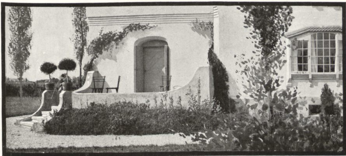
TERRASSE UND FENSTER VON OBIGEM LANDHAUS
