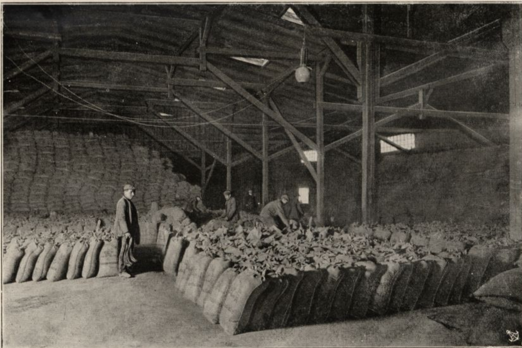
Abb. 5. Lagerraum in der Thomasschlackenmühle, Betriebsstätte Friedenshütte bei Morgenroth Zunähen, Plombieren und Verladen der Säcke mit Thomasmehl „Sternmarke“
