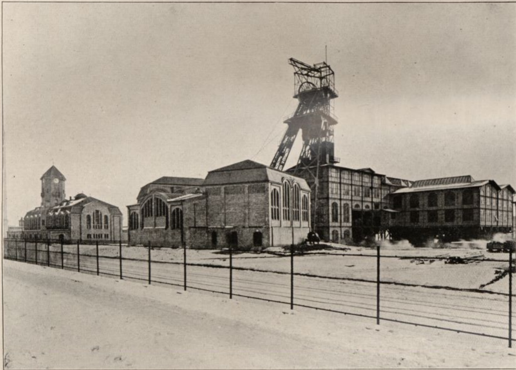
Carmerschacht der cons. Giesche- und Reservegrube
