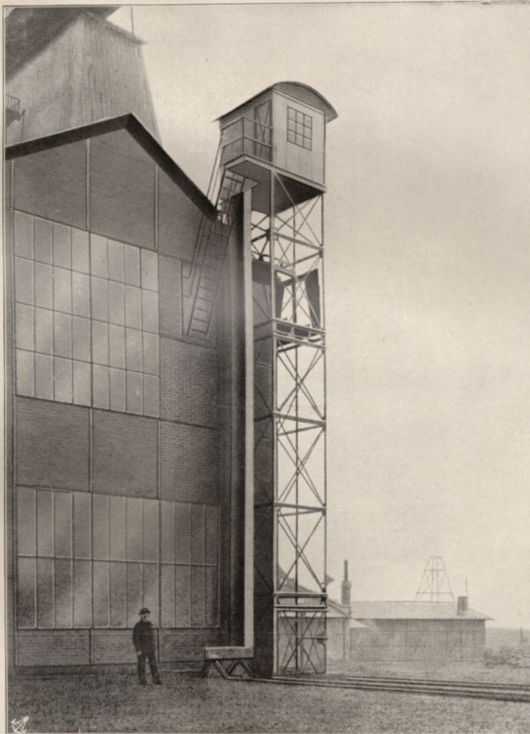
Elektrisch betriebener Lastenaufzug, 1500 kg Nutzlast, 9,4 Hubhöhe
