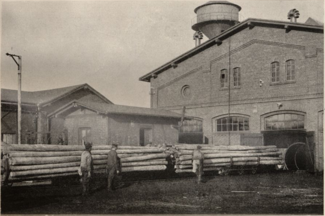
Besetzen des Imprägnierzylinders mit rohen Stangen
