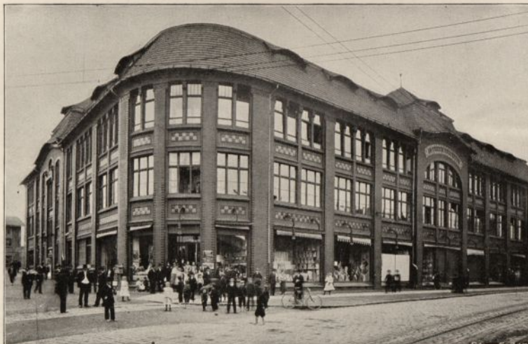
Abb. 4. Hütten-Kaufhaus in Friedenshütte
