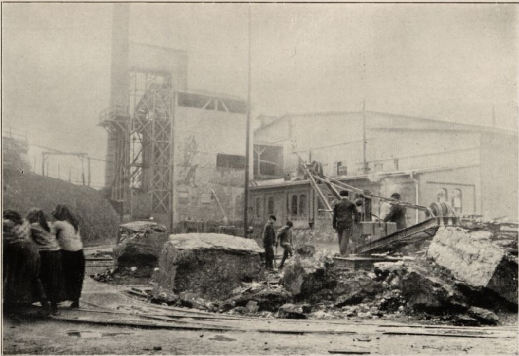
Abb. 3. Thomasschlackenhalde und Thomasschlackemühle der Betriebsstätte Friedenschütte bei Morgenroth O.-S.
