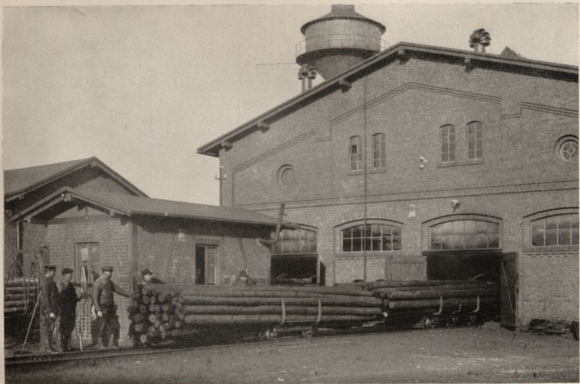
Die getränkten Stangen verlassen den Imprägnierzylinder
