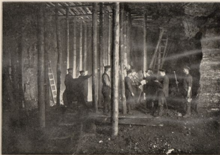
Gedingestellung im Pfeilerabbau
