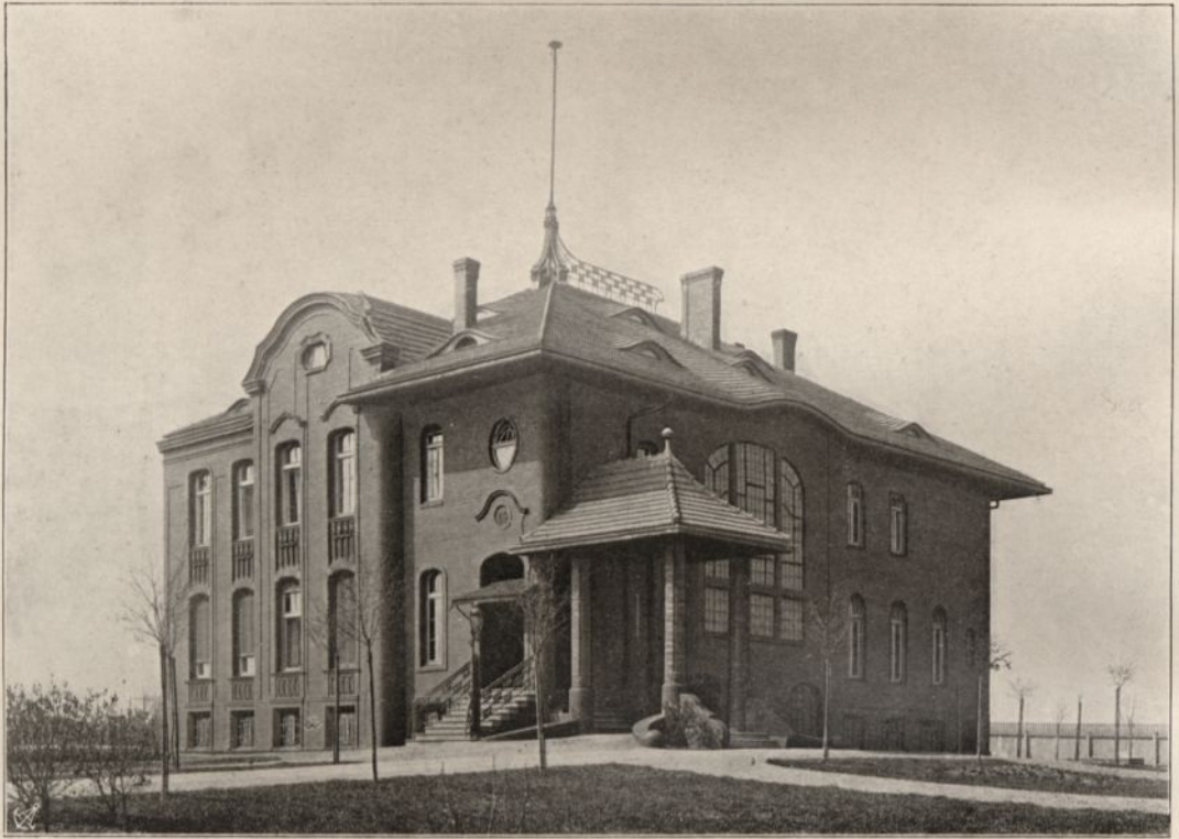
Villa des Generaldirektors in Bismarckhütte
