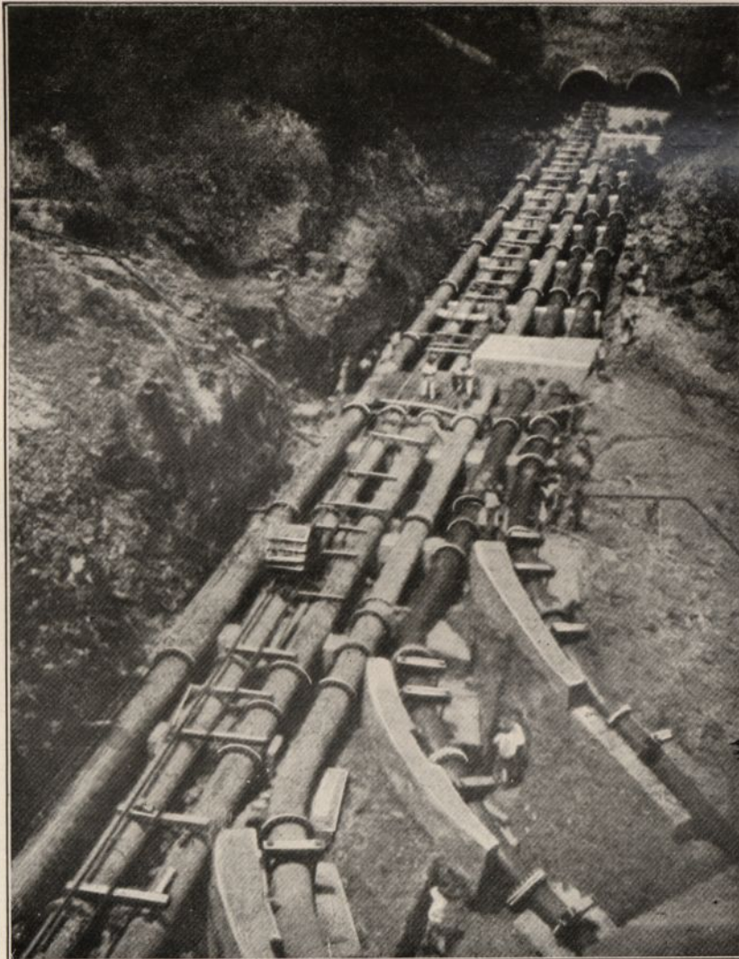
Druckrohranlage in Necaxa (Mexico)
