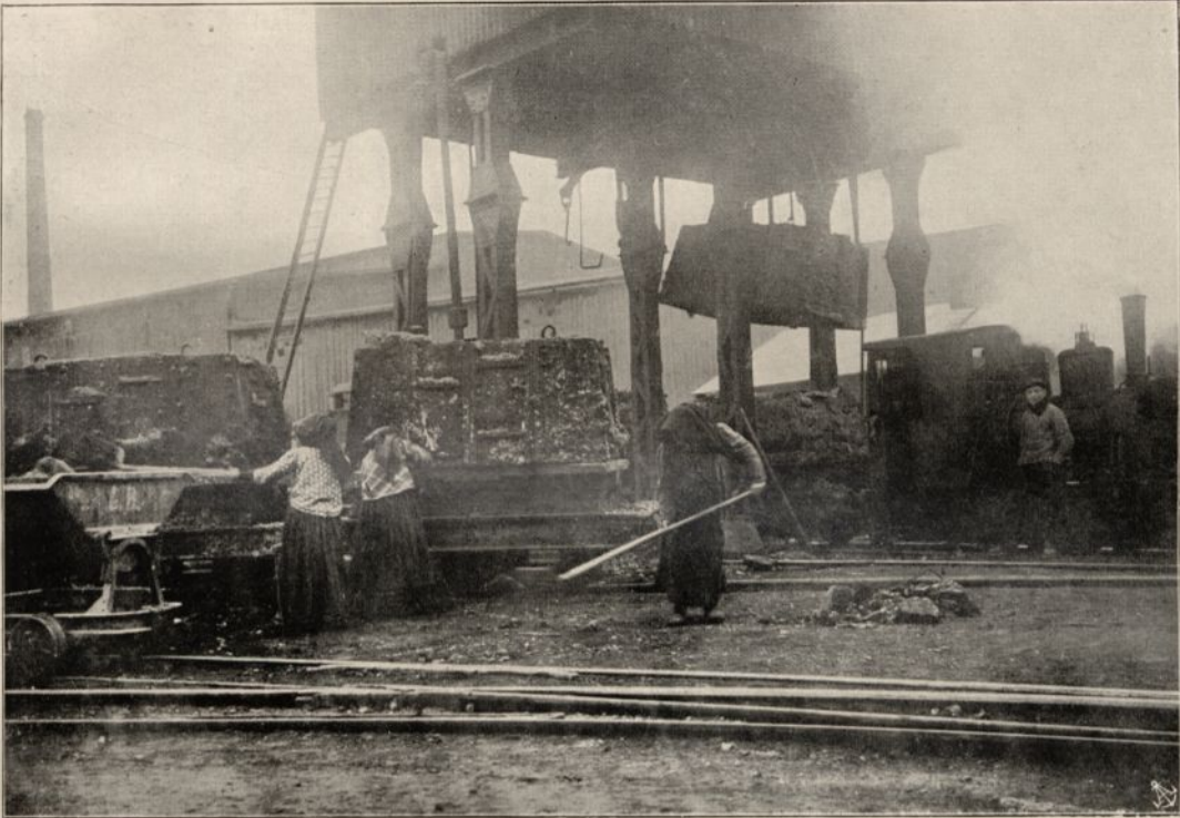
Abb. 2. Abheben der Stahlhauben von den erstarrten Thomasschlackenblöcken
