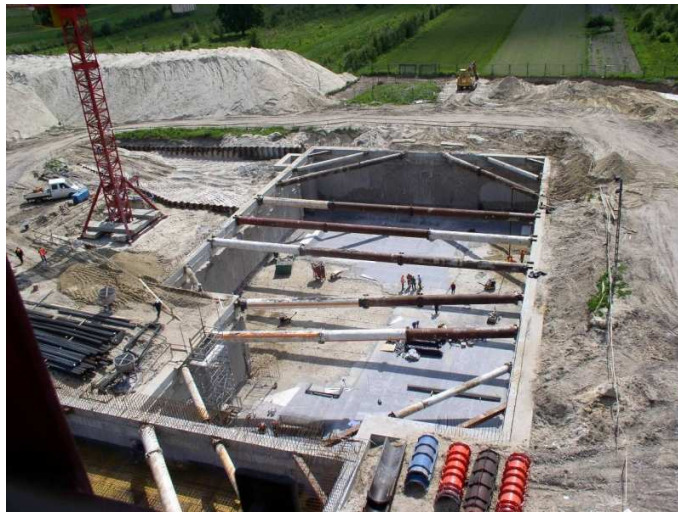
Rys. 2.2. Budowa siedziby operatora systemu przemysłowego (PSE) w Bielawie k/Konstancina, budynki B i C [99]
