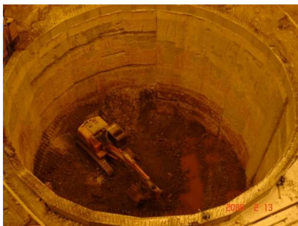
Rys. 2.6. Osadnik zgorzeliny w Hucie Katowice COS3 [99]
