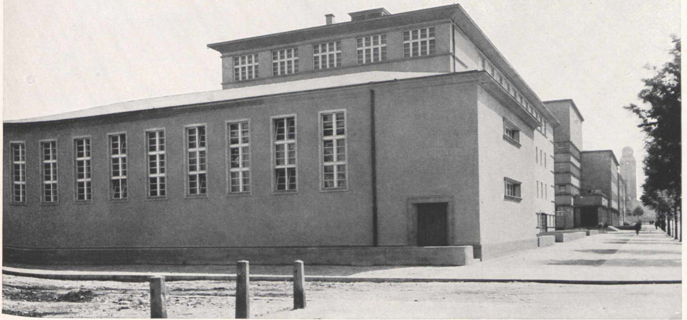
WESTANSICHT MIT TURNHALLE
